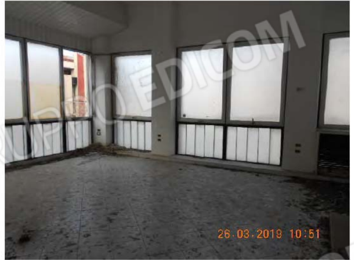
Vista delle condizioni del Vano 4.
