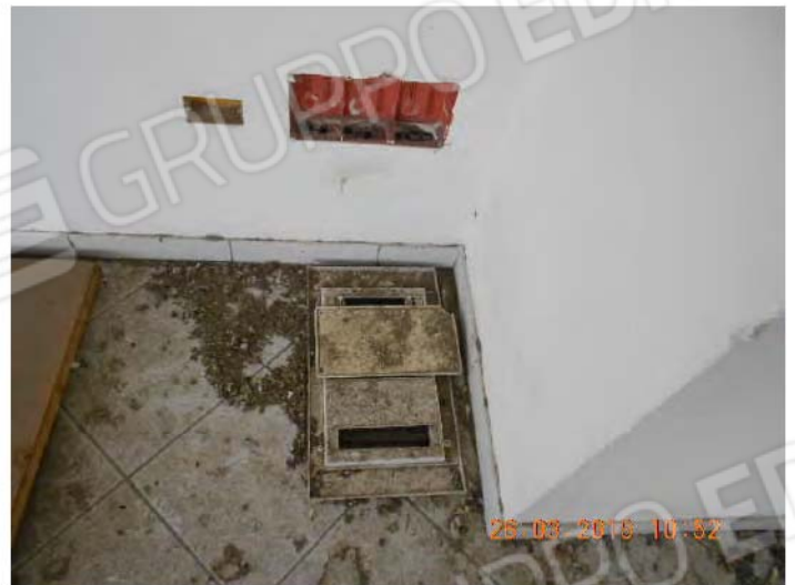
Quadretto vandalizzato nel vano 4 oltre cassette di derivazione e prese ed interruttori e dismissione dei cavi elettrici.
