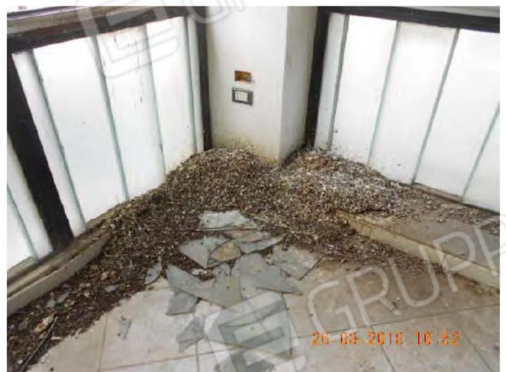
Quadretto vandalizzato nel vano 4 oltre cassette di derivazione e prese ed interruttori e dismissione dei cavi elettrici.
