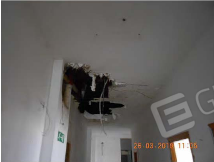
Condotta di scarico.
