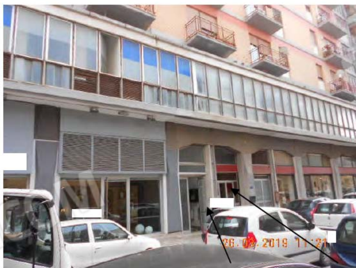
Ingresso Principale -via Pantelleria n.10 e secondario n. 8.
