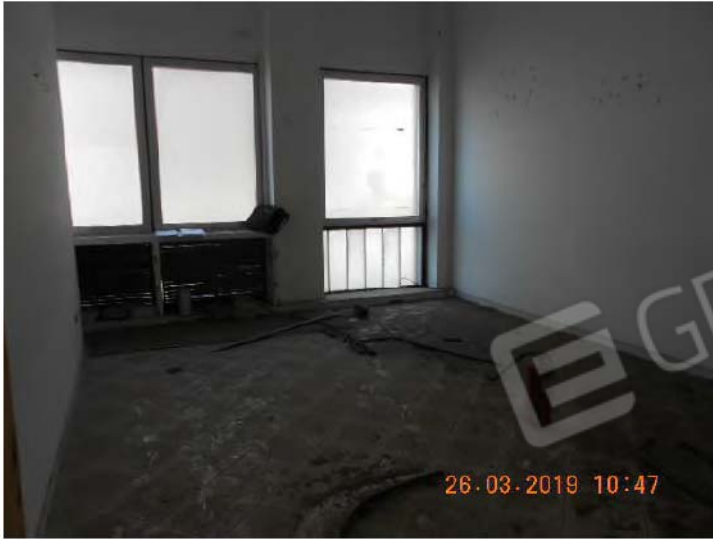
Vista delle condizione del Vano 1.
