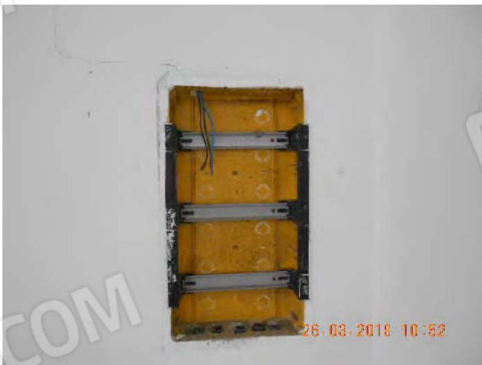
Quadretto vandalizzato nel vano 4 oltre cassette di derivazione e prese ed interruttori e dismissione dei cavi elettrici.
