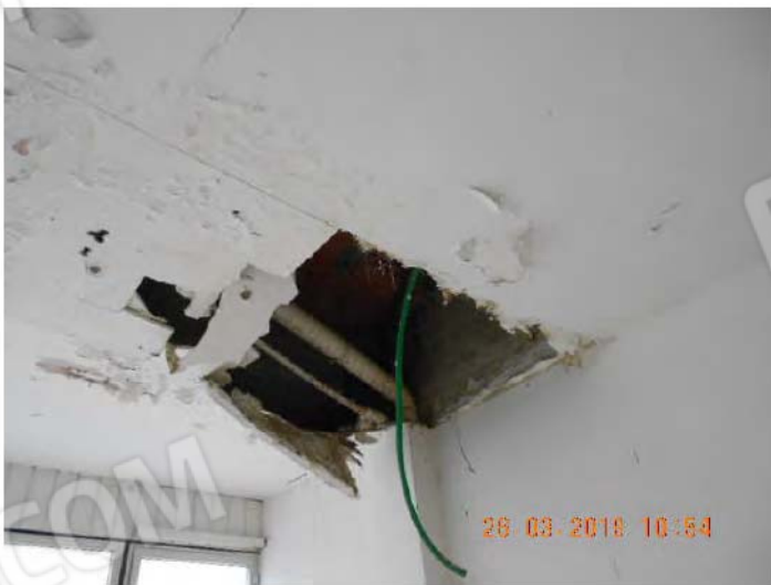
Crollo del controsoffitto del vano 5 proveniente da perdita d'acqua del piano superiore.
