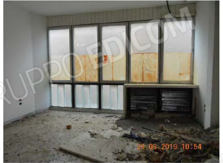
Vano 5: da notare la mancanza dell' infissi interni e le condizioni del vano 5 con crollo del controsoffitto.
