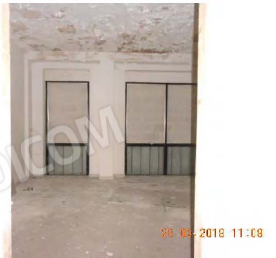
Vista del Vano 7 stesse condizioni del Vano 6.
