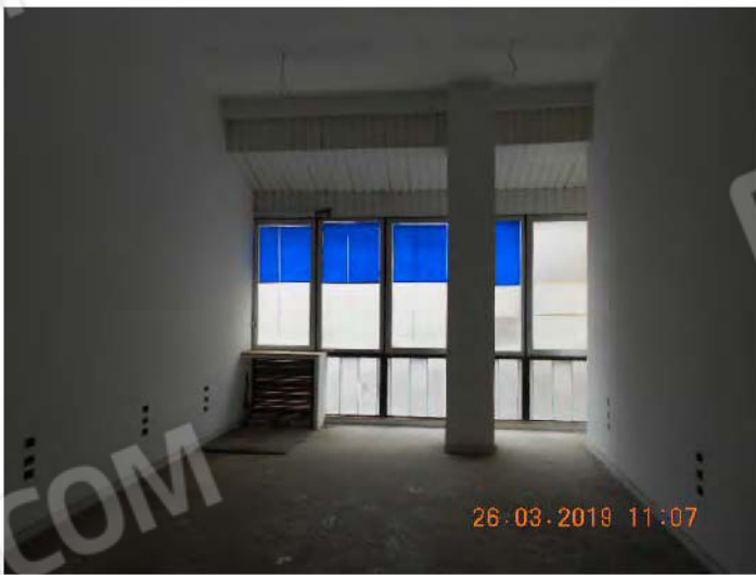
Vista del Vano 10.
