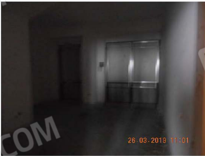
Vista del Vano 6: da notare gli infissi murati con blocchi in pomice mento.
