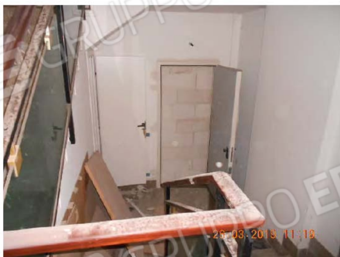
Porta murata che accedeva al cortile interno
