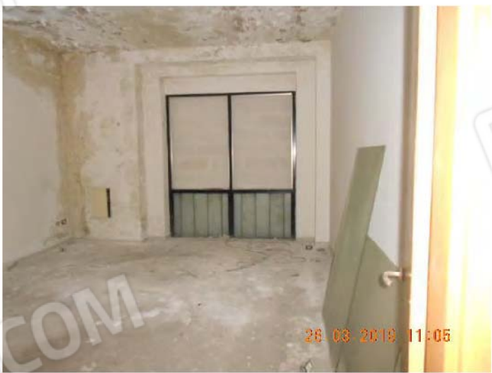
Vista delle condizioni del Vano 6.
