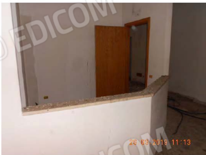
Vista altra angolazione del disimpegno 1.
