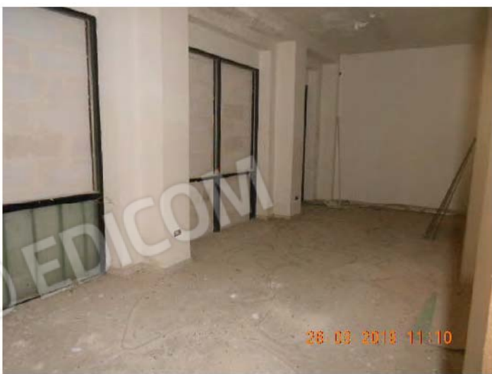
Vista del Vano 12.
