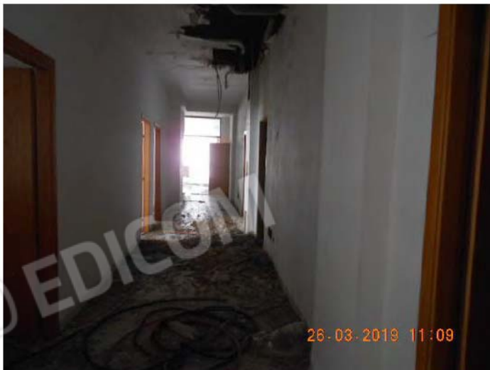
Vista delle condizioni del Disimpegno 2.
