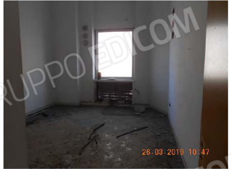
Vista delle condizione del Vano 2.
