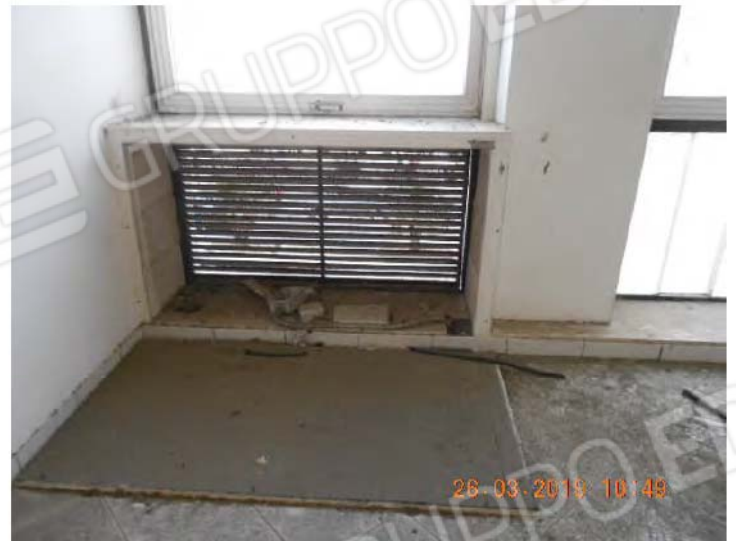
Vista delle condizione del Vano 3 e delle dismissioni attraverso atti vandalici dei climatizzatori.
