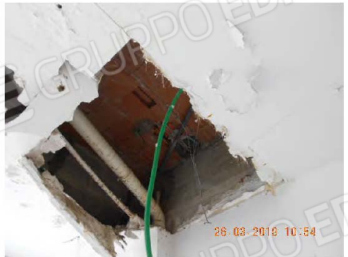
Crollo del controsoffitto del vano 5 proveniente da perdita d'acqua del piano superiore.
