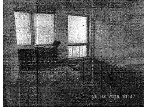
Le pareti interne sono intonacate e tinteggiate oggi allo stato pessimo il soffitto risulta in alcune parti controsoffittato e presentano tracce di infiltrazioni d'acqua dovuta alla perdita sicuramente del piano soprastante.
