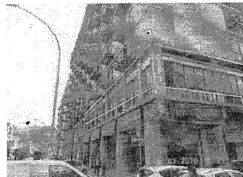
Gli infissi esterni sono in alluminio e vetri: a seguito di atti di vandalizzazione risultano o parzialmente mancanti o in pessimo stato di manutenzione e con vetri rotti e pericolosi per l'incolumità dei passanti.
