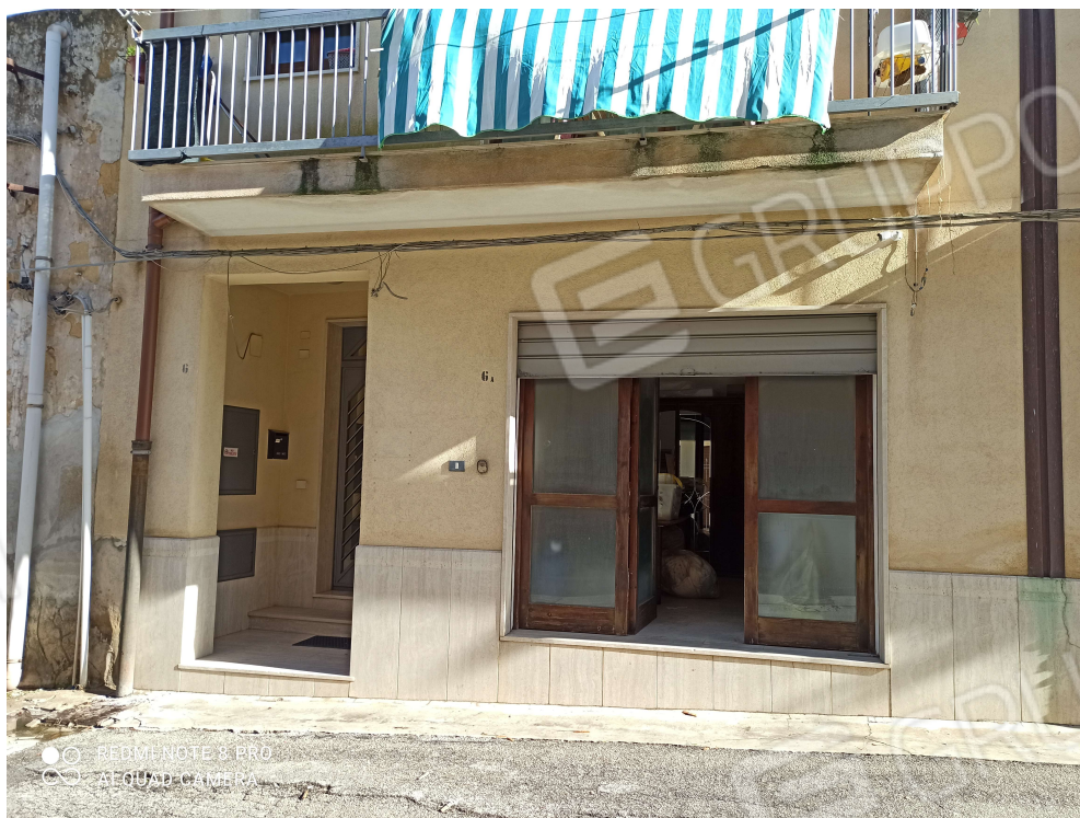
Facciata si via Enea – autorimessa e androne
