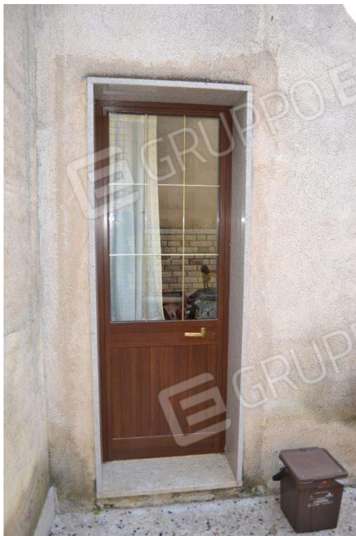
Foto 57) BENI 1 E 22 – Porta di accesso laterale
