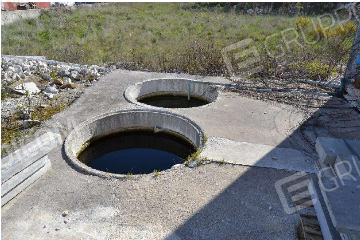
Foto 6) BENI 1 E 2 – Vasche in calcestruzzo
