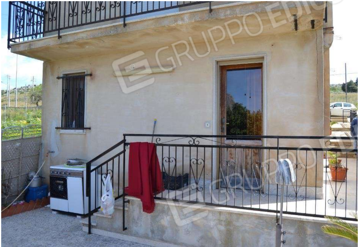
Foto 19) BENE 5 – Facciata lato nord (piano seminterrato)
