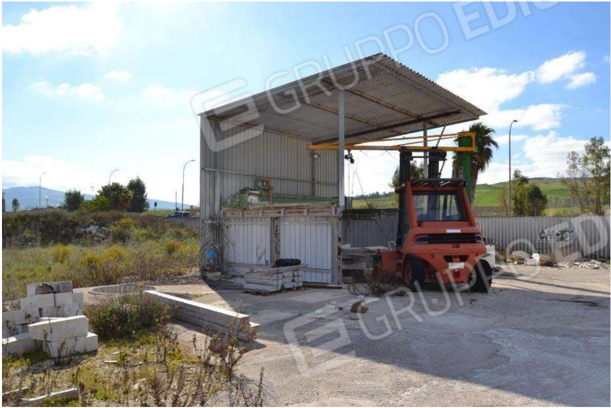
Foto 5) BENI 1 E 2 – Tettoia in acciaio
