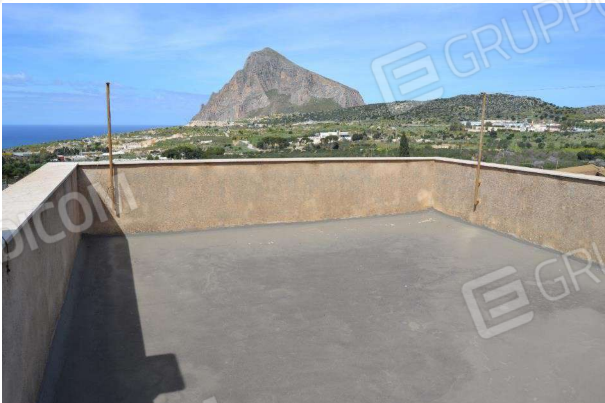
Foto 38) BENE 5 – Lastrico solare lato nord
