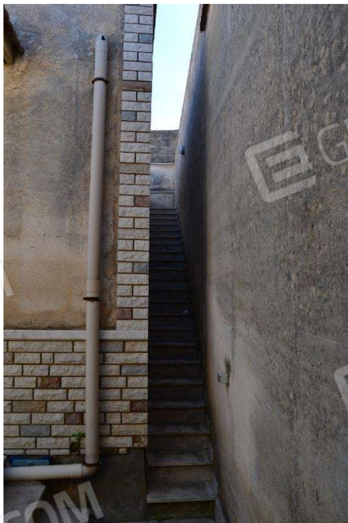
Foto 52) BENE 8 – Scala di accesso ai lastrici solari
