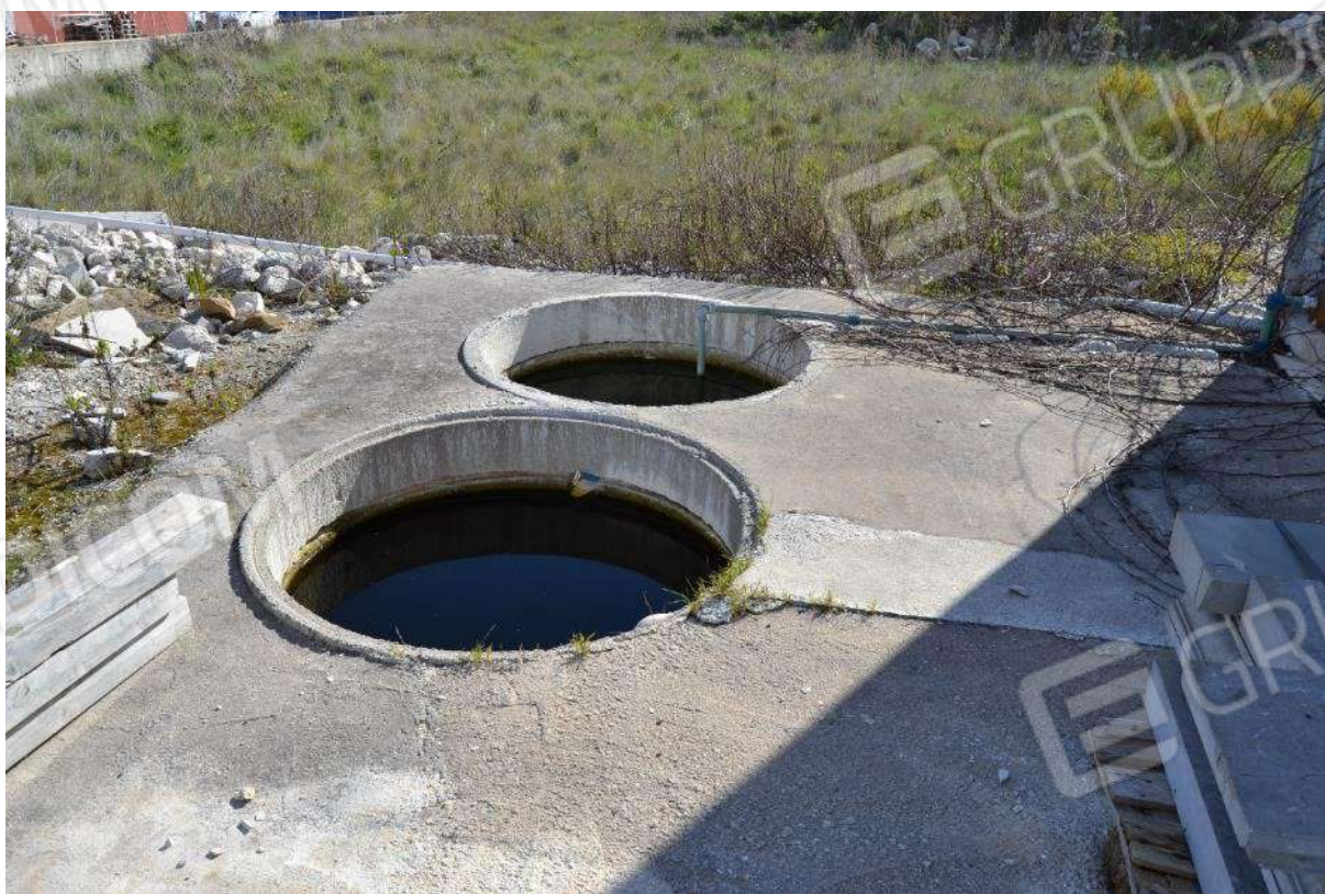
Foto 6) BENI 1 E 2 – Vasche in calcestruzzo
