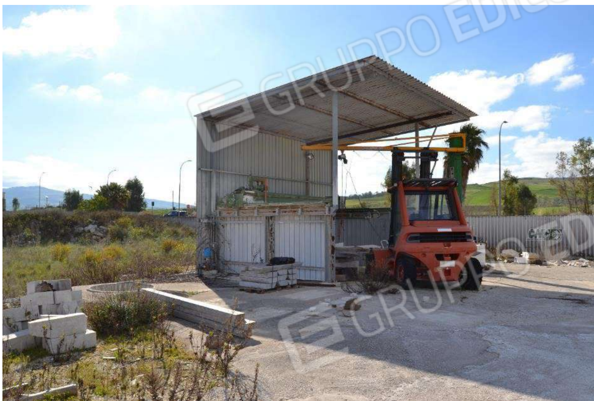
Foto 5) BENI 1 E 2 – Tettoia in acciaio
