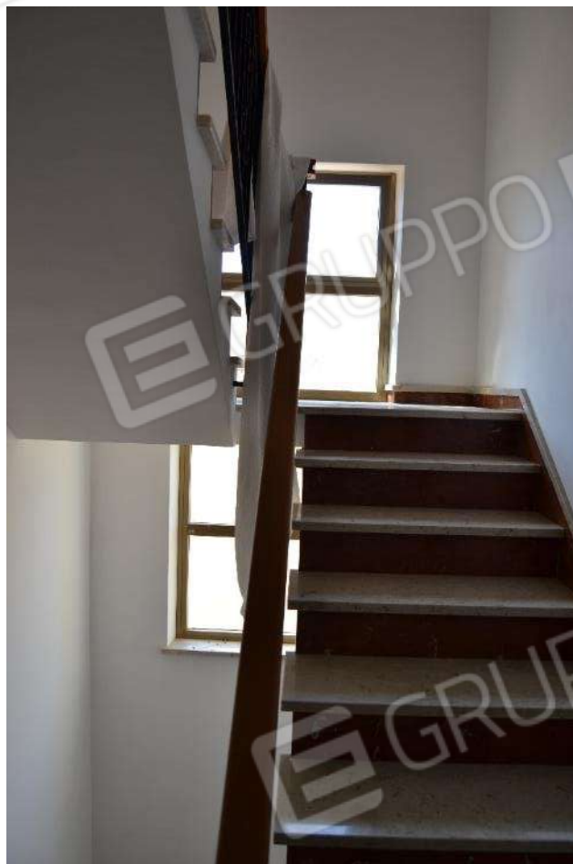
Foto 35) BENE 5 – Scala con finestra Piano secondo
