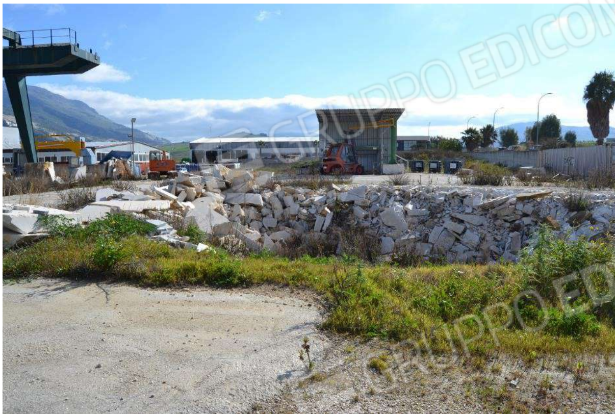
Foto 7) BENI 1 E 2 – Scavo e pezzame di marmo
