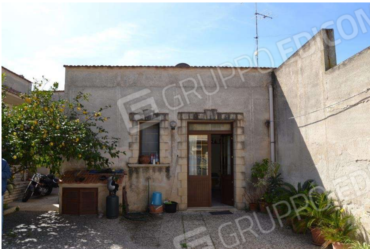
Foto 55) BENE 7 – Ingresso magazzino dalla corte interna
