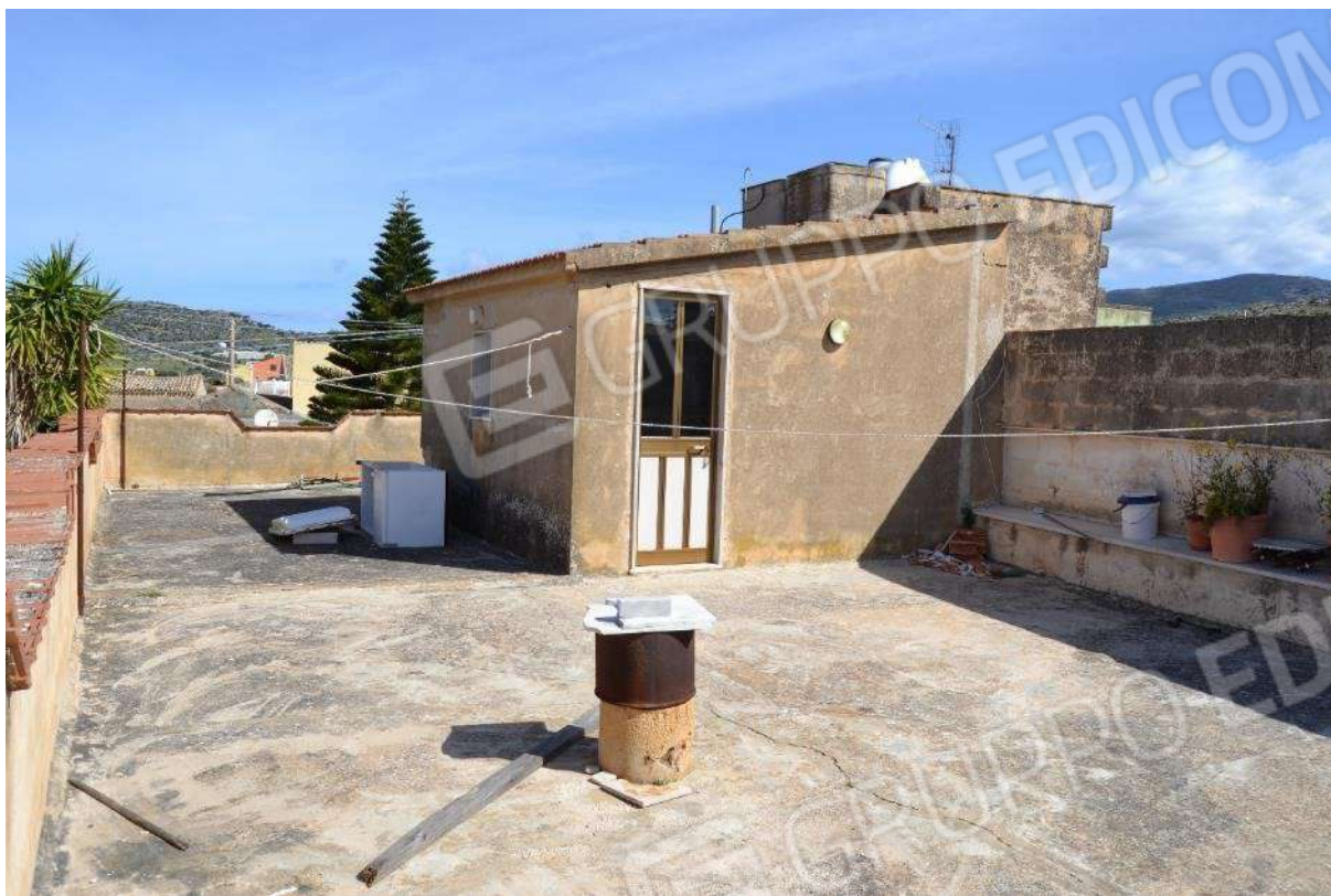
Foto 53) BENE 8 – Lavanderia e lastrici solari
