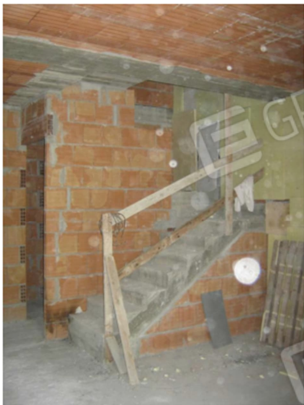
Piano terra interno scala
