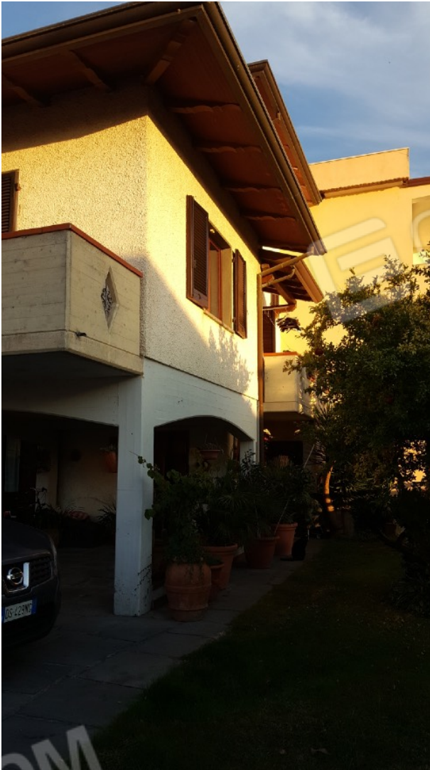
Foto 34. Prospetto lato mare lotto 1
