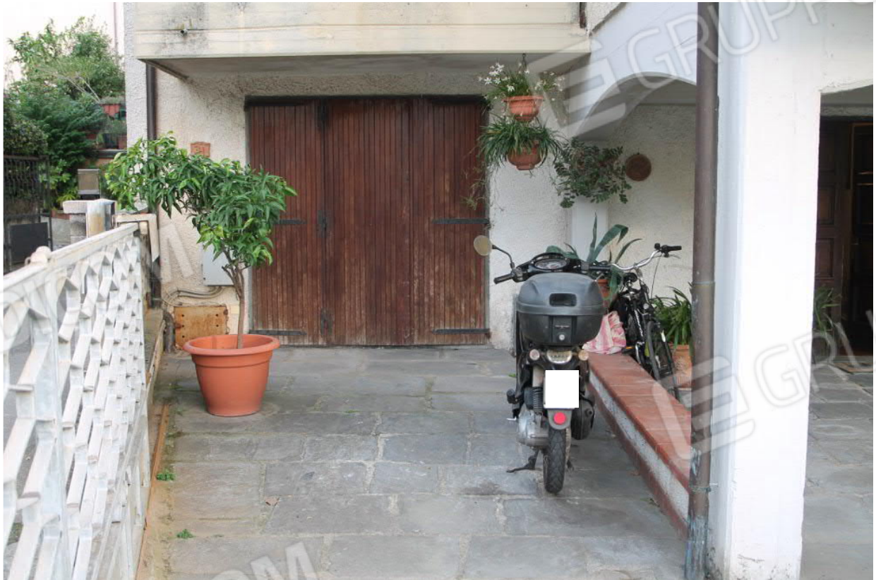
Foto 36. Prospetto lato Carrara piano terra lotto 1
