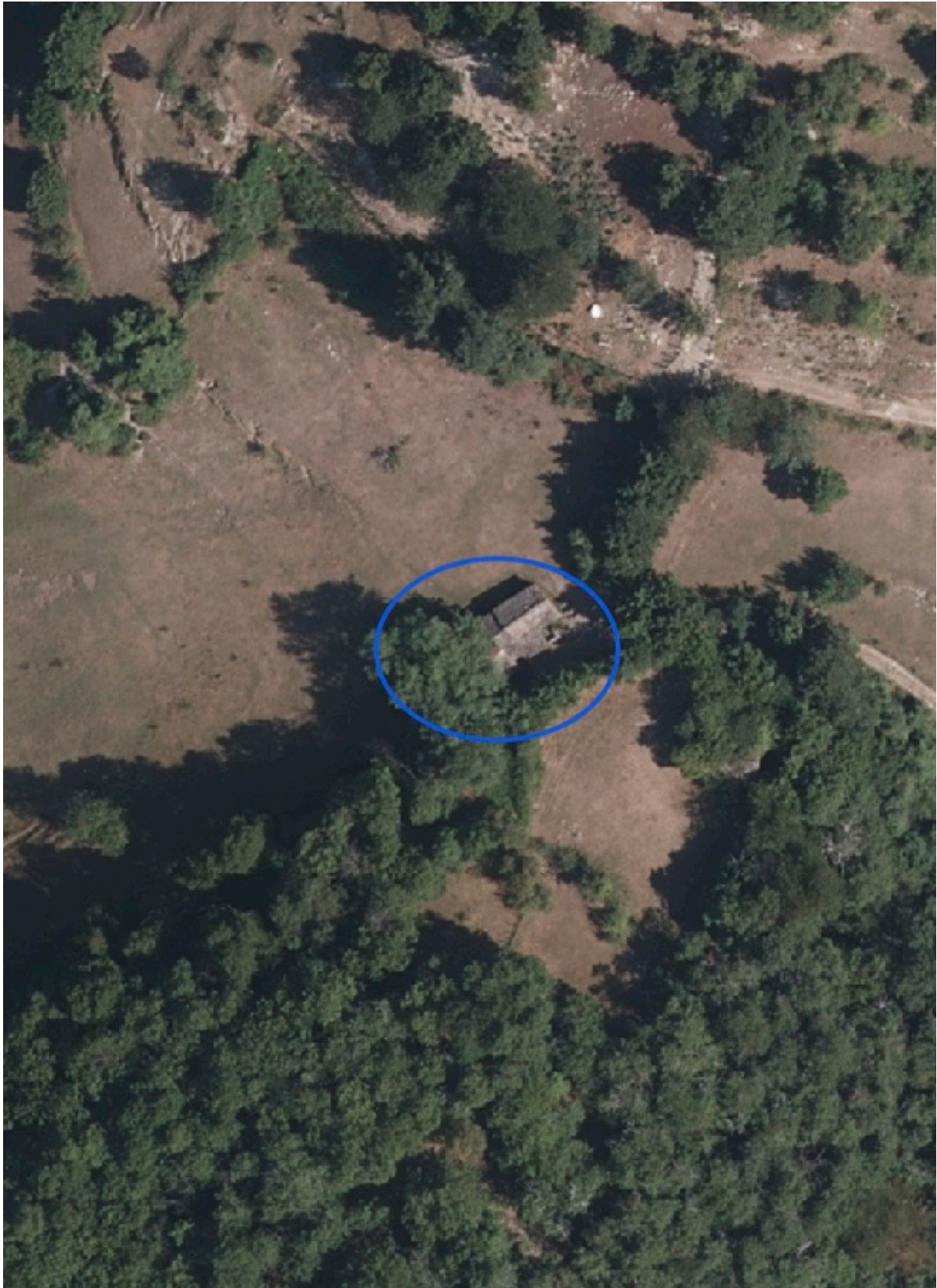
FOTO AEREA 3_ dettaglio Fabbricati rurali Part. 189 (evidenziati in blu)
