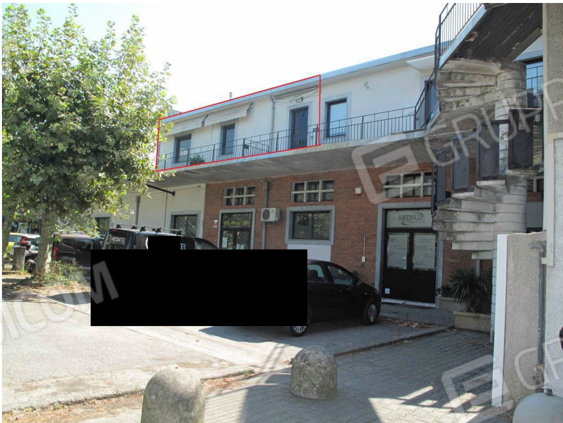
Foto 5. Esterno dal cortile interno
