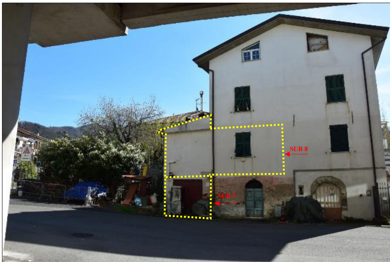
FOTO 2 – palazzina pluripiano in cui è evidenziato il LOTTO UNICO oggetto della procedura
