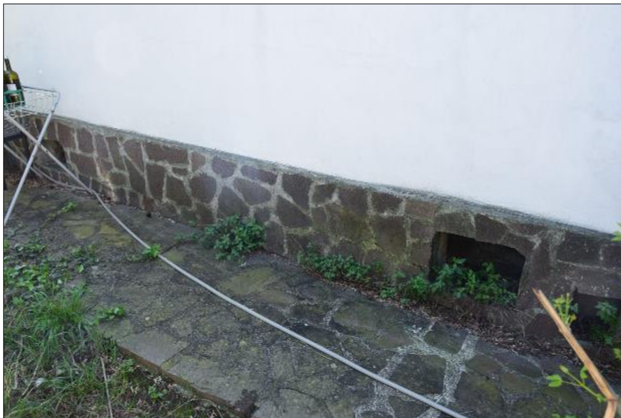
FOTO 13 – particolare aperture SUB. 7 su mapp. 258 (corte)
