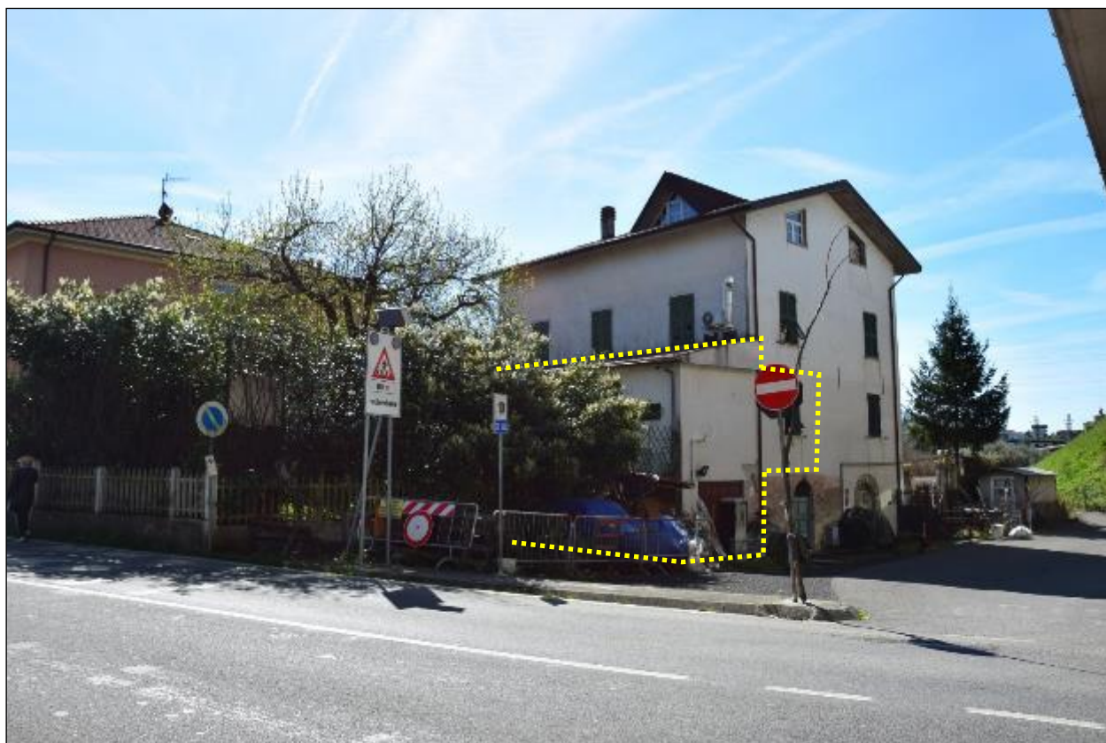
FOTO 1 - palazzina pluripiano in cui è evidenziato il LOTTO UNICO oggetto della procedura
