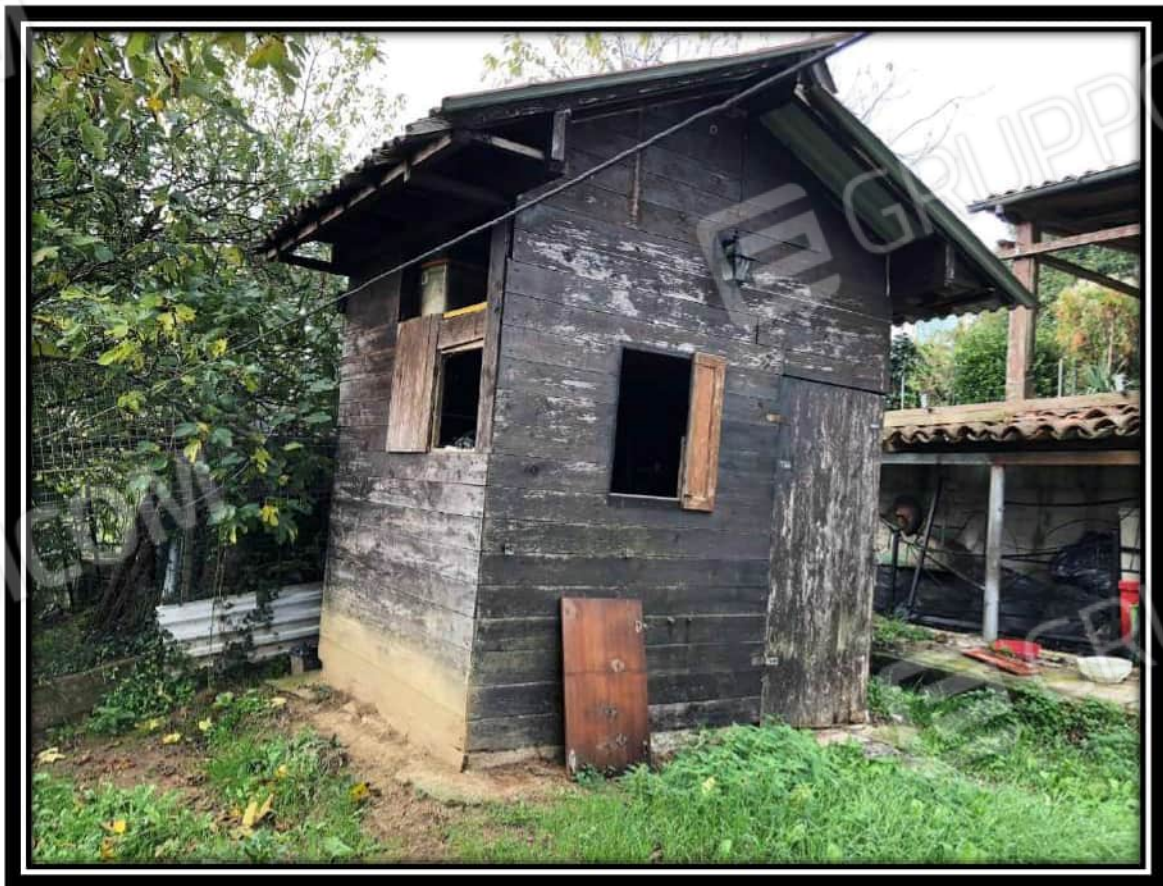
Foto 33 – Terrreno mappale 902 – capanno in legno
