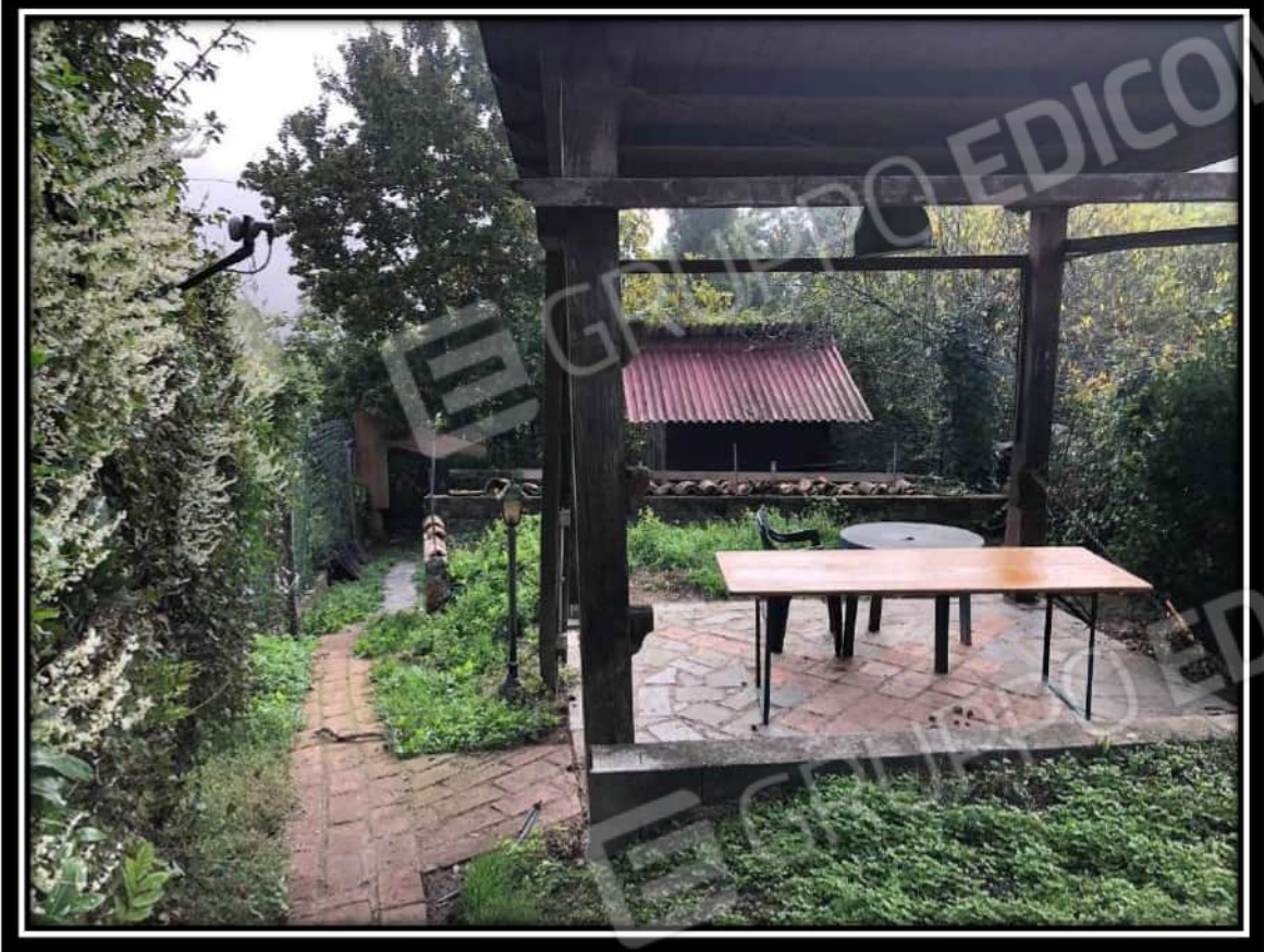
Foto 28 – Terrreno mappale 902 – Tettoia
