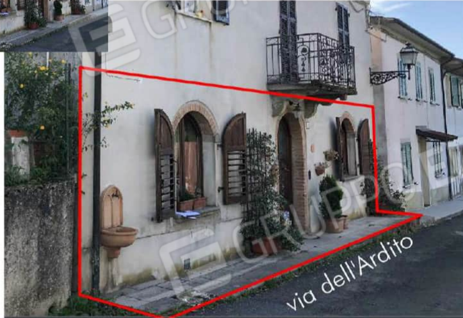
Abitazione al piano terra
