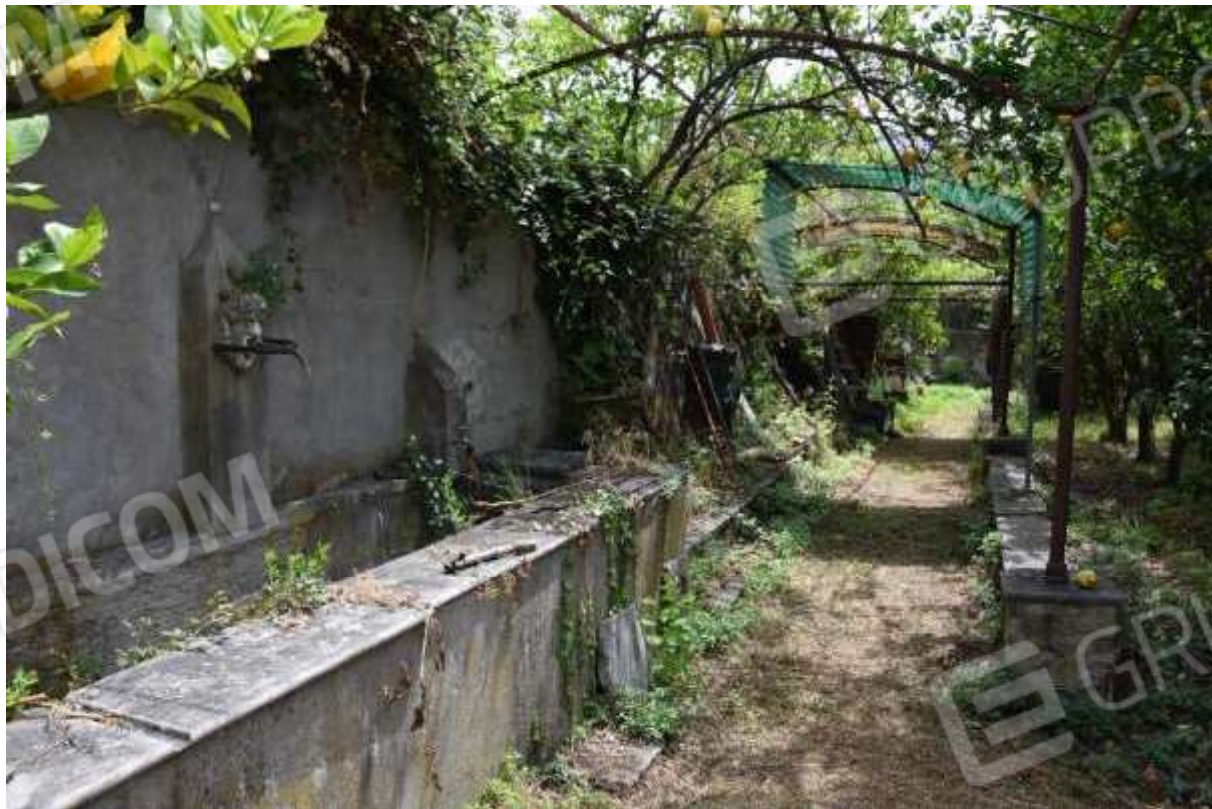
FOTO 24 – Vasca in muratura
