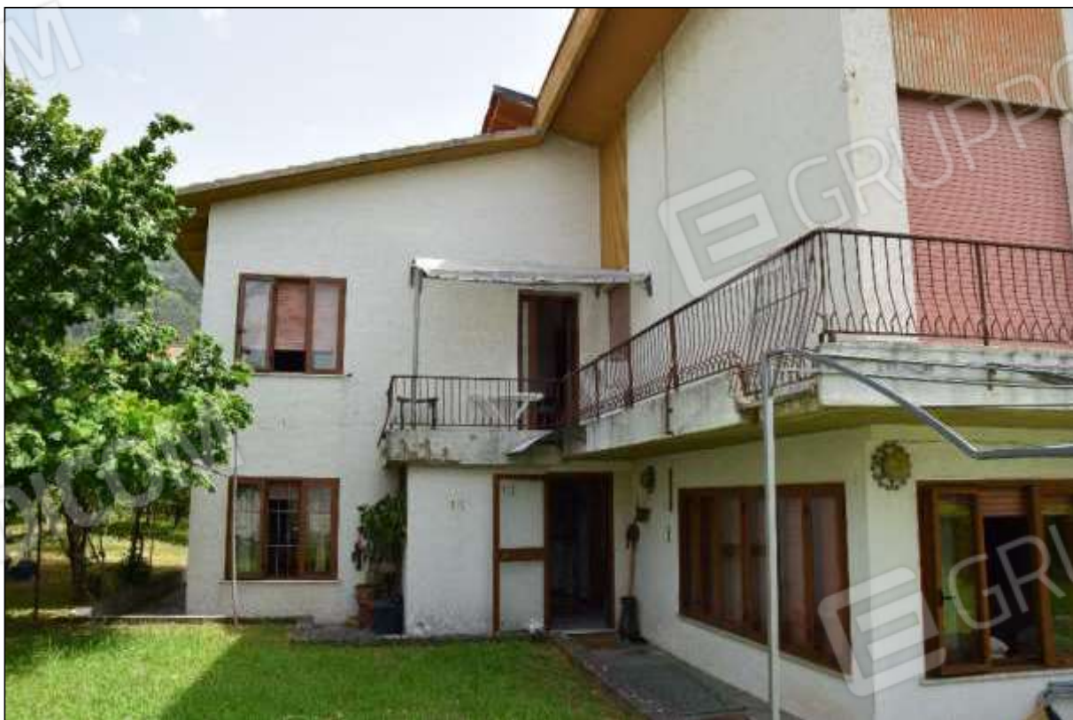
FOTO 10 – Ingresso al piano terra – porzione della facciata Sud-Ovest
