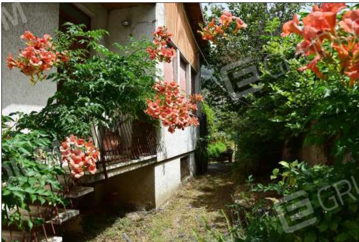
FOTO 4 - Immobile 1 -facciata Sud-Est
