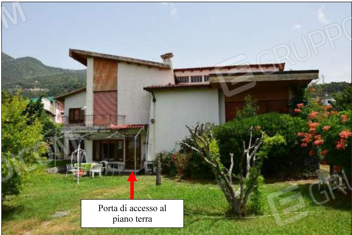
FOTO 12 – Immobile 1 - Facciata Sud-Ovest
