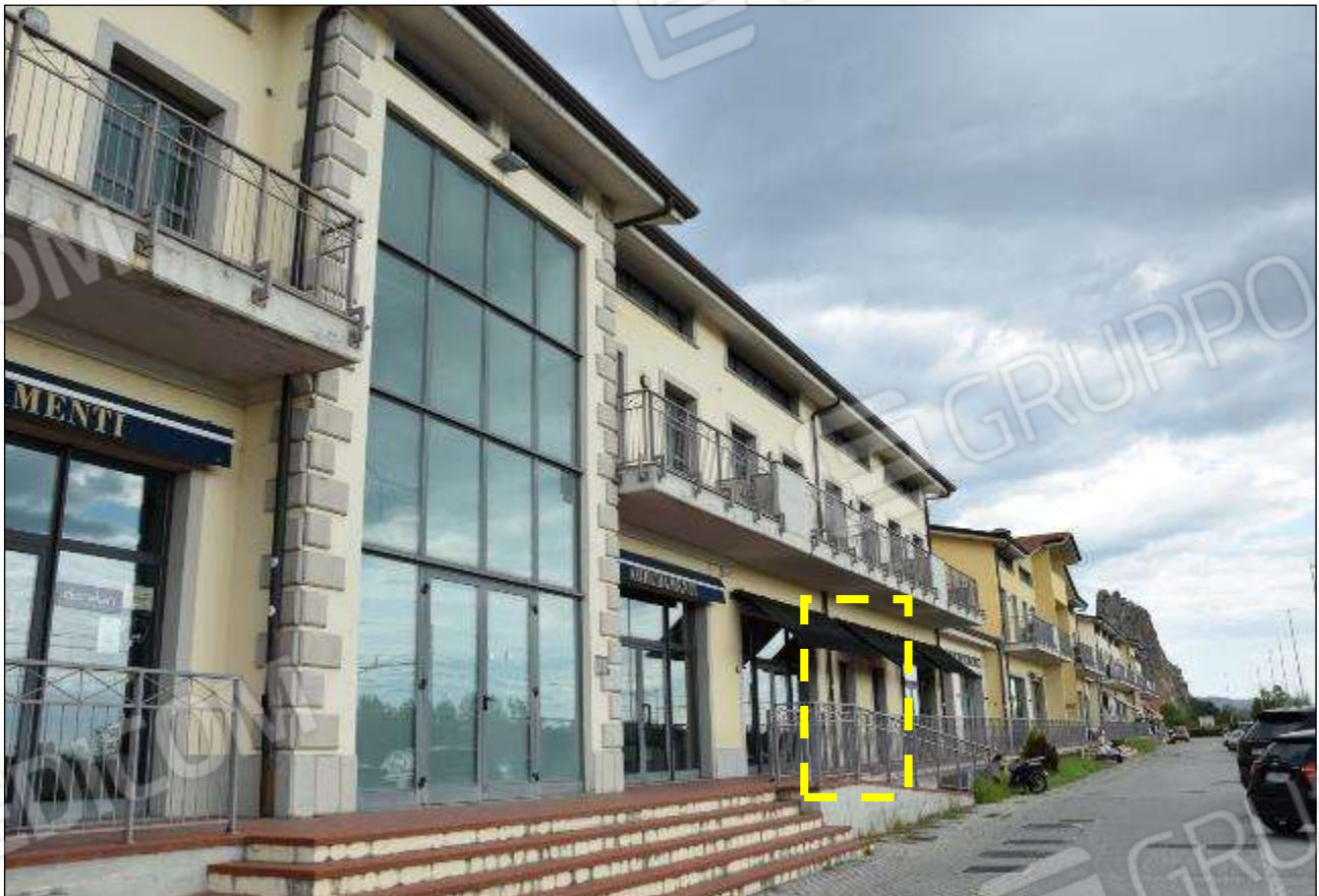
INDIVIDUAZIONE ACCESSO LOTTO – SUB 152 (BLOCCO SINISTRO LATO MASSA)
