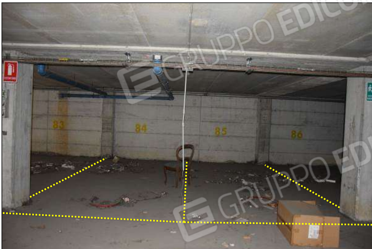
FOTO 3 – SUB 71 (POSTO 84) / SUB 72 (POSTO 85)
