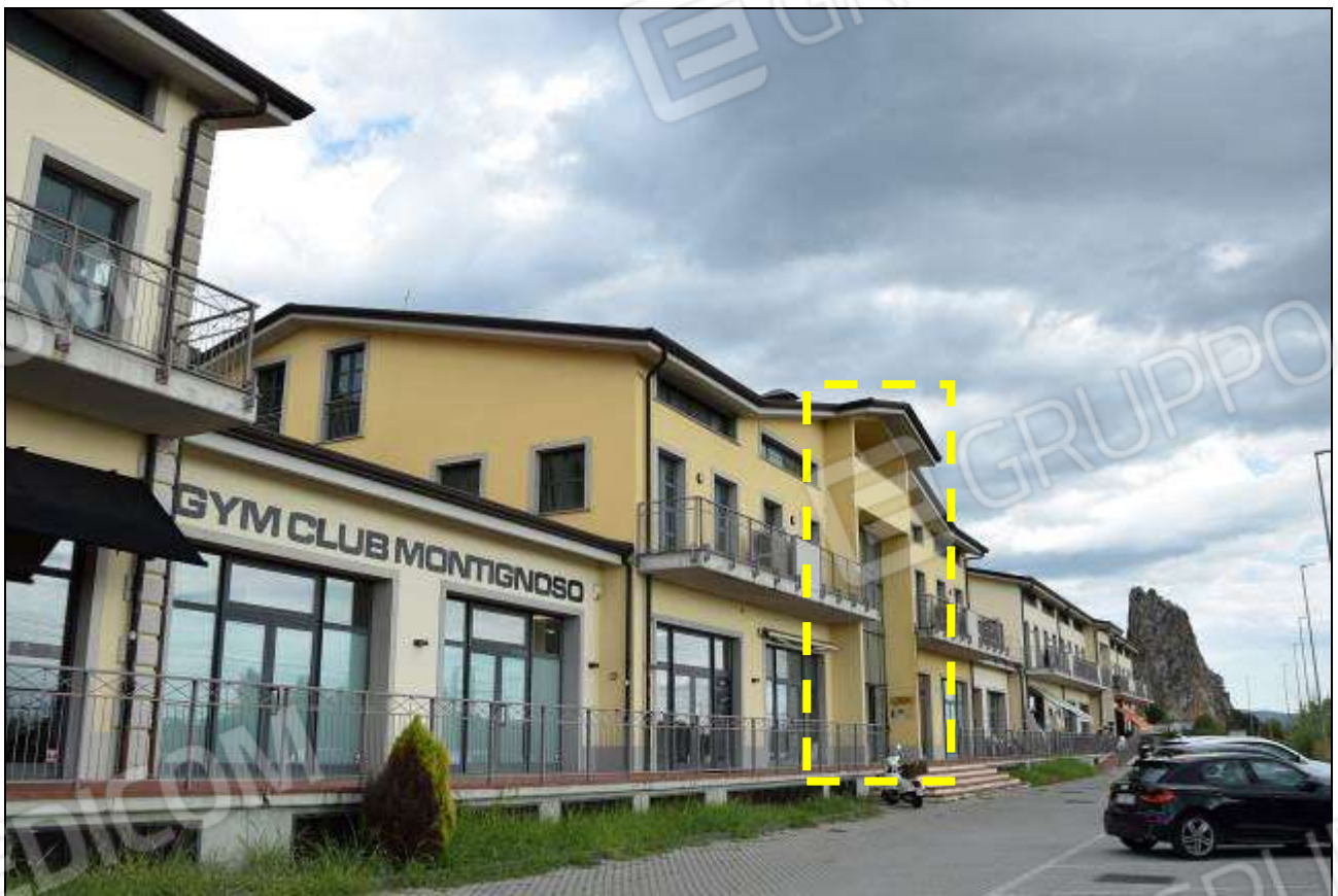
INDIVIDUAZIONE ACCESSO VANO SCALA “B” (BLOCCO CENTRALE)
