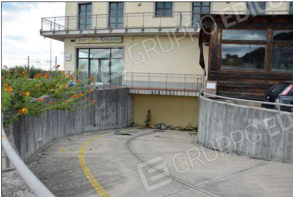
FOTO 7 – ingresso garage interrato chiuso per motivi di sicurezza
