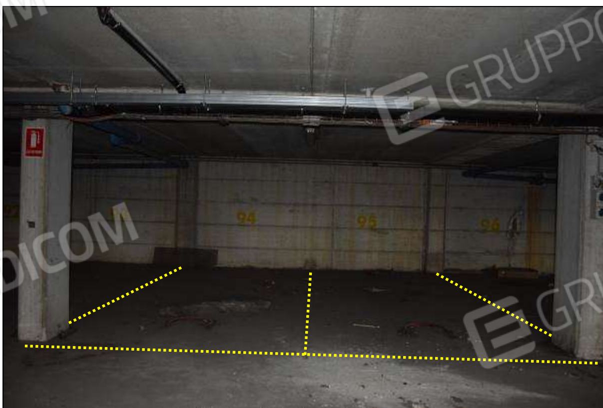
FOTO 8 – SUB 81 (POSTO 94) / SUB 82 (POSTO 95)
