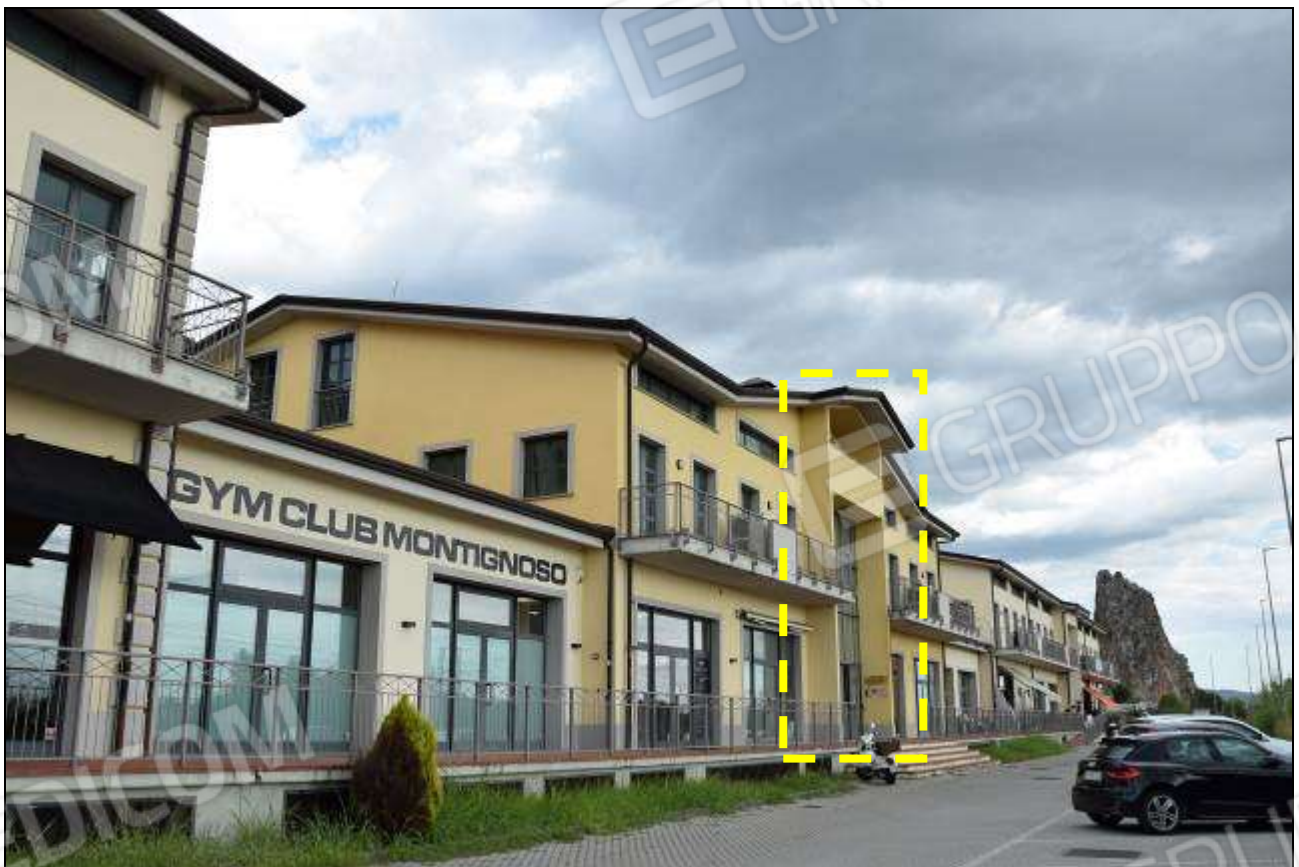
INDIVIDUAZIONE ACCESSO VANO SCALA “B” (BLOCCO CENTRALE)
