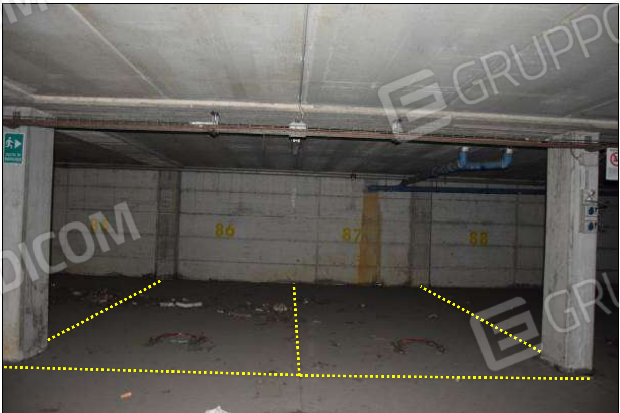
FOTO 4 – SUB 73 (POSTO 86) / SUB 74 (POSTO 87)
