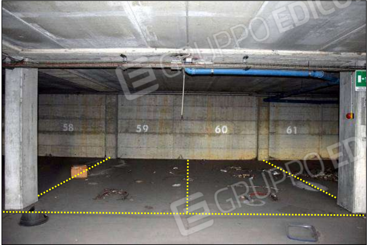
FOTO 1 – SUB 63 (POSTO 59) / SUB 64 (POSTO 60)
