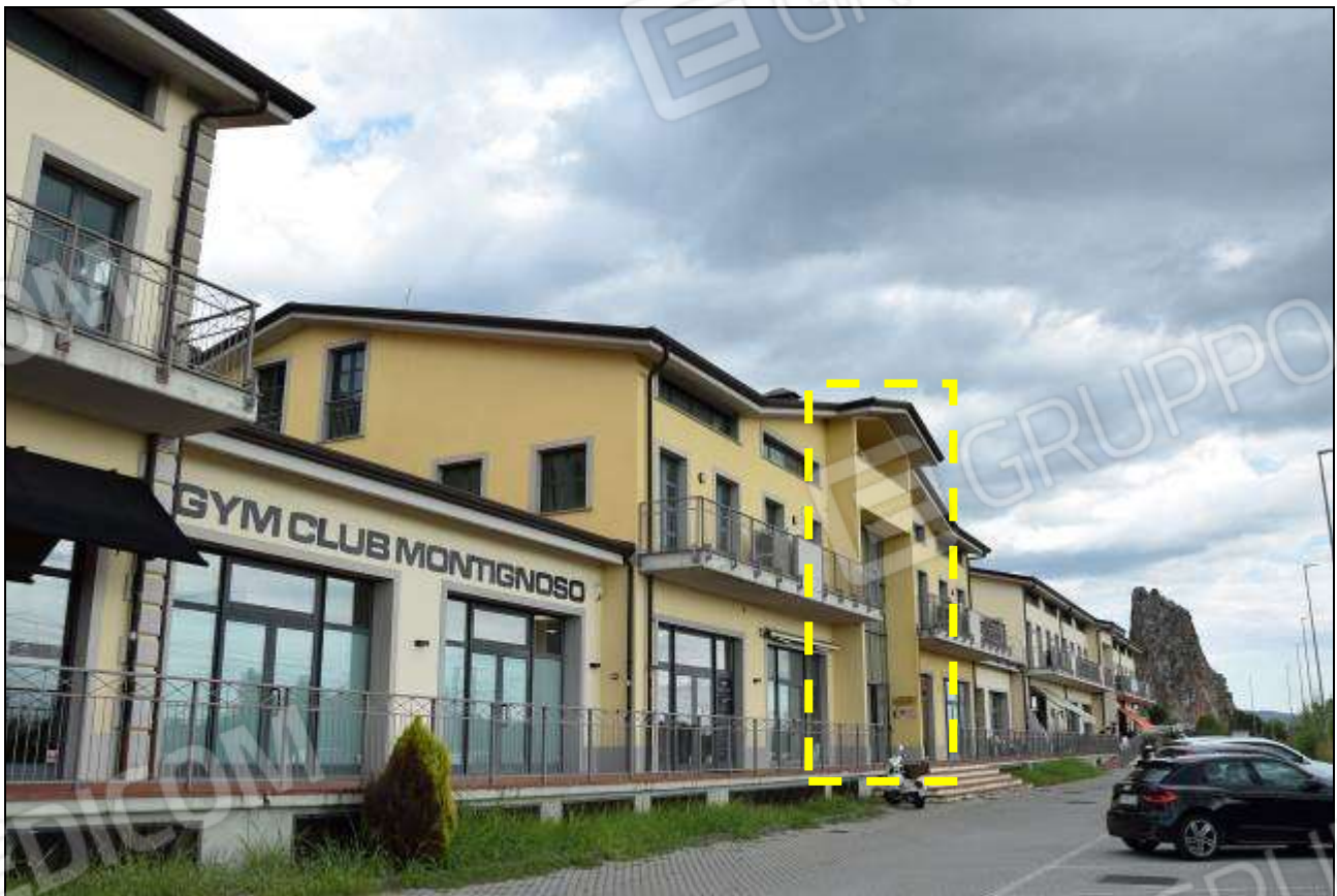
INDIVIDUAZIONE ACCESSO VANO SCALA “B” (BLOCCO CENTRALE)
