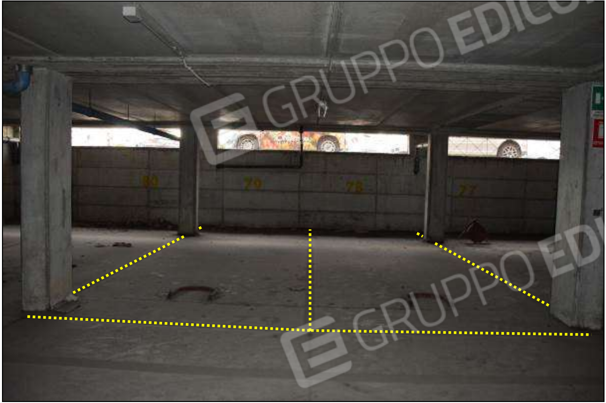
FOTO 1 – SUB 89 (POSTO 79) / SUB 90 (POSTO 78)
