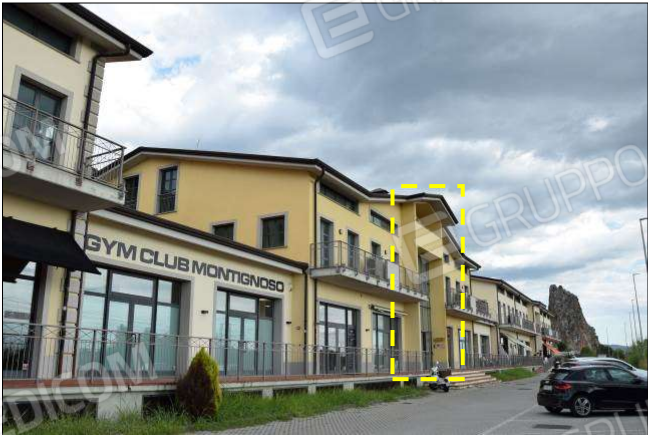
INDIVIDUAZIONE ACCESSO VANO SCALA “B” (BLOCCO CENTRALE)
