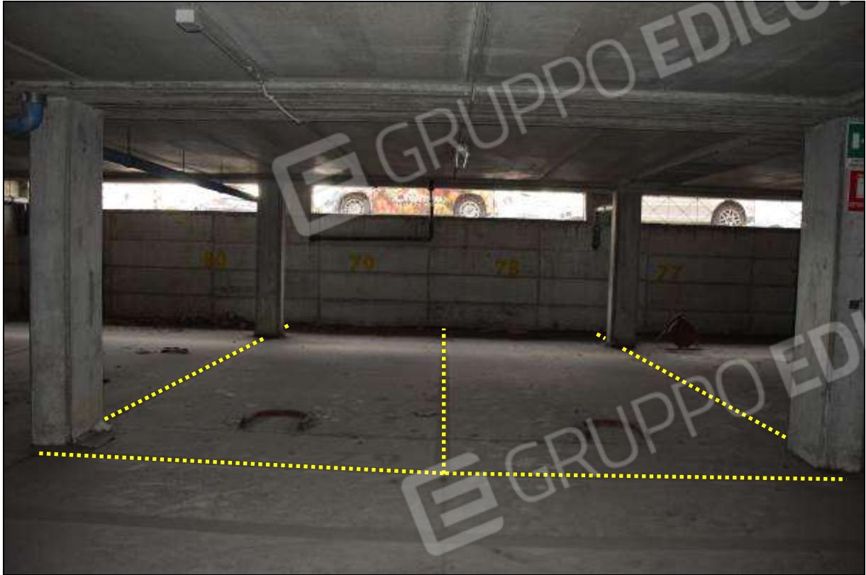
FOTO 1 – SUB 89 (POSTO 79) / SUB 90 (POSTO 78)
