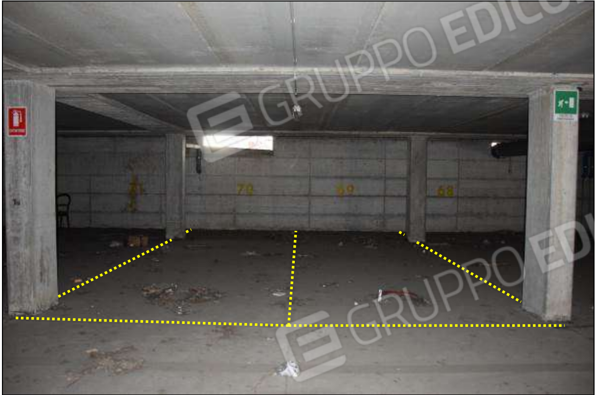
FOTO 1 – SUB 98 (POSTO 70) / SUB 99 (POSTO 69)
