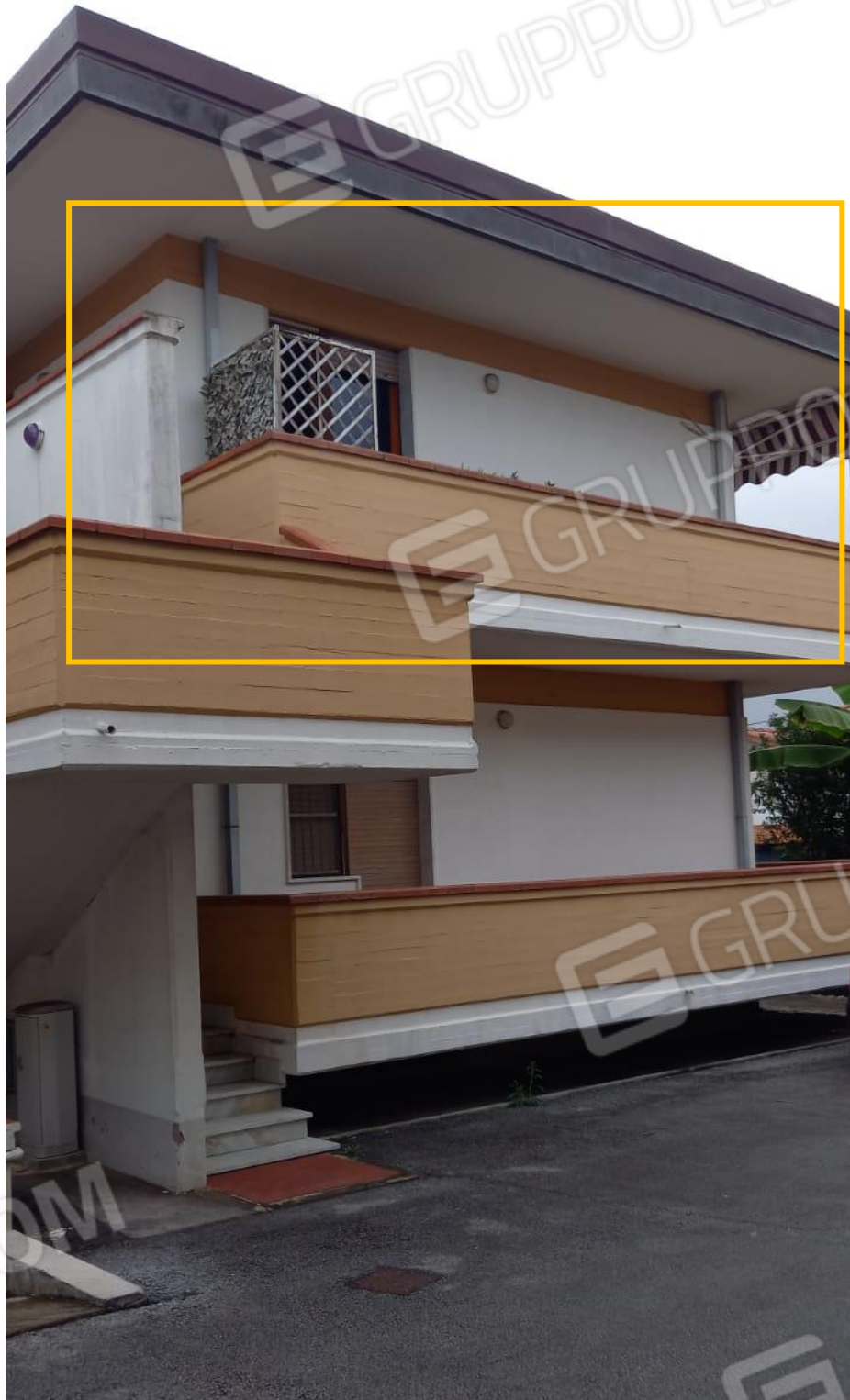
Foto 1 – Vista immobile dal viale comune
