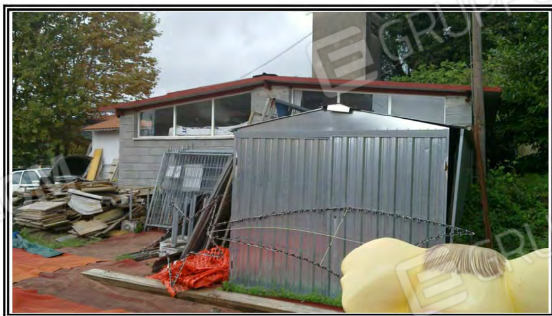
Foto n. 2 – Vista del bene immobile dall'interno del lotto
