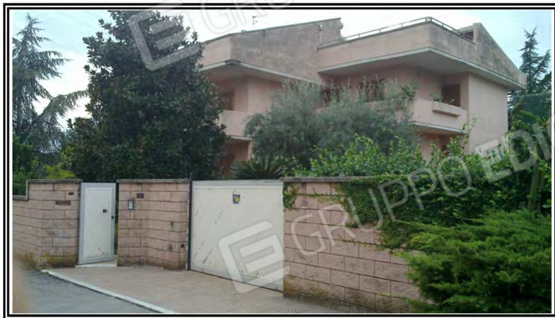
Foto n. 1 – Ingresso alla proprietà
