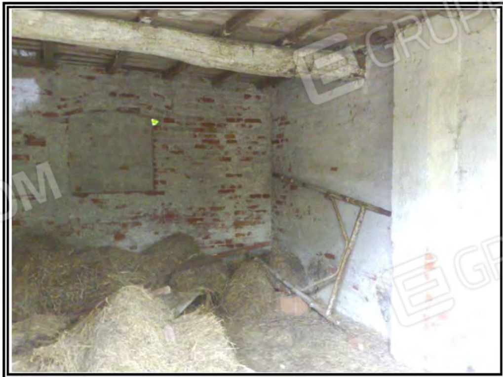
Foto n. 10 – Fabbricato rurale mappale 42 - ambienti interni
