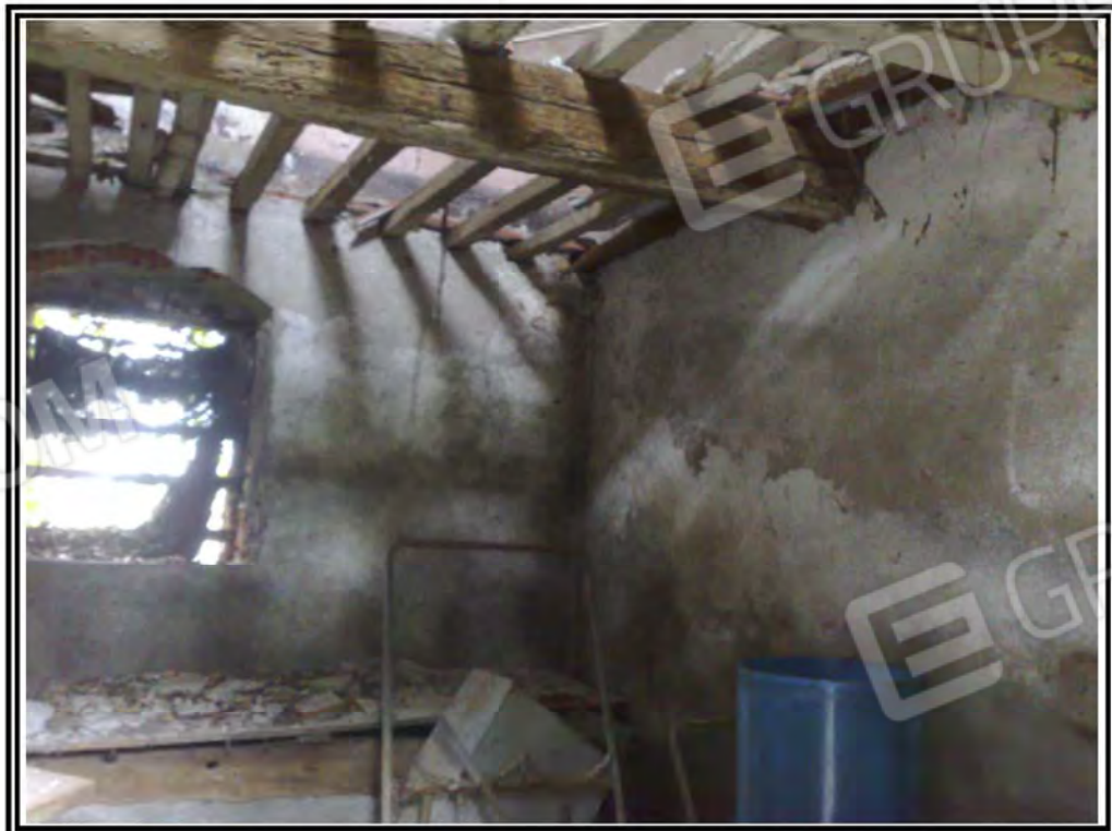
Foto n. 8 – Fabbricato rurale mappale 42 - ambienti interni
