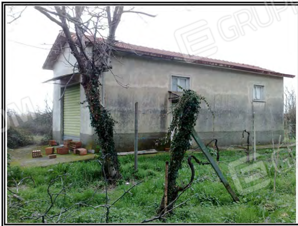
Foto n. 12 – Fabbricato rurale mappale 311
