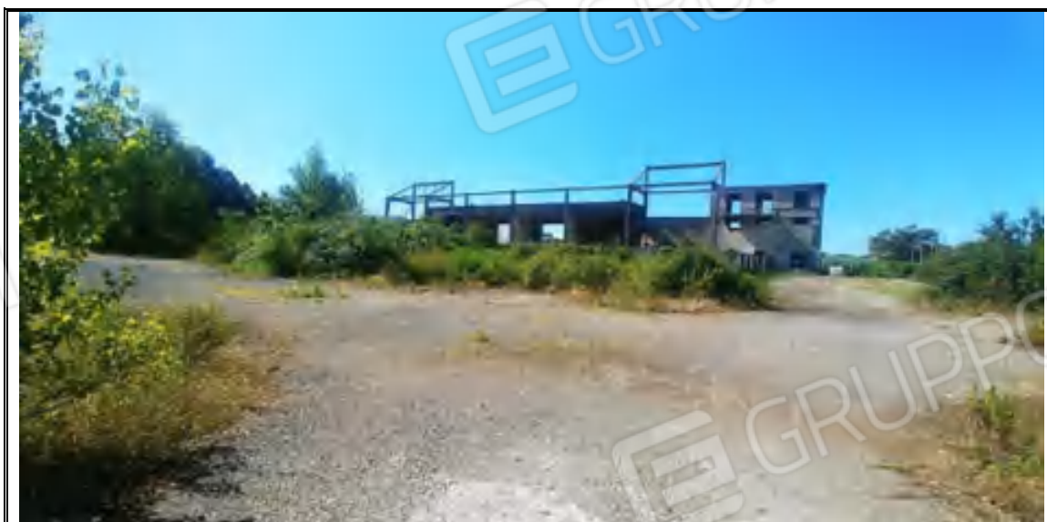
Foto n. 92– Corpo G – Terreno edificabile mappali 563/1, 563/2 e 564/2
