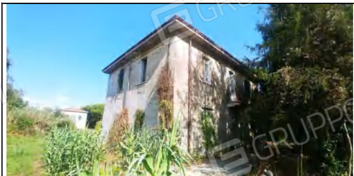
Foto n. 14 – Corpo A - Fabbricato mappale 287 – Angolo SUD
