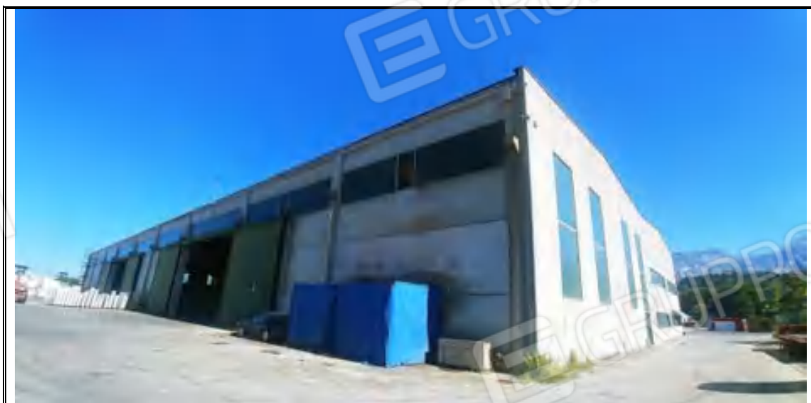
Foto n. 56– Corpo C – Capannone mappale 547 – Angolo NORD
