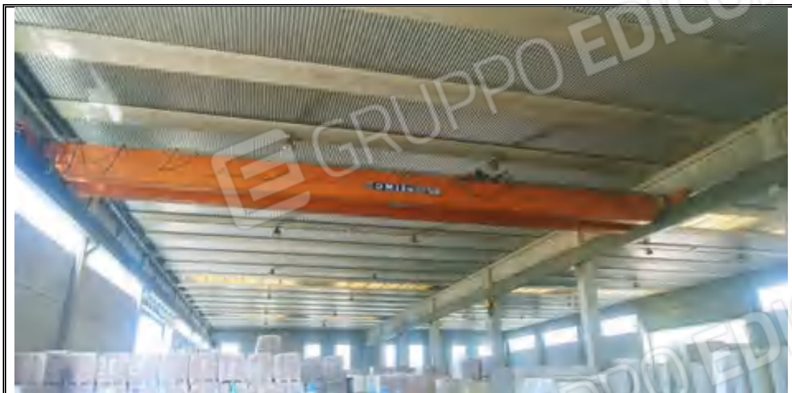
Foto n. 70– Corpo C – Capannone mappale 547 – Carroponte
