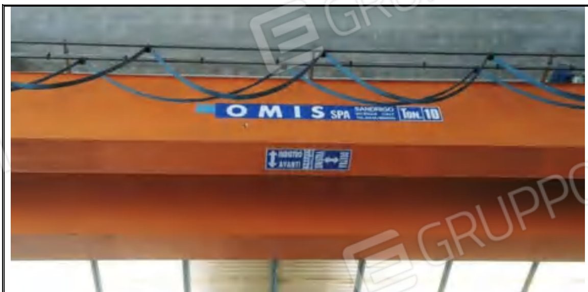
Foto n. 71 – Corpo C – Capannone mappale 547 – Carroponte
