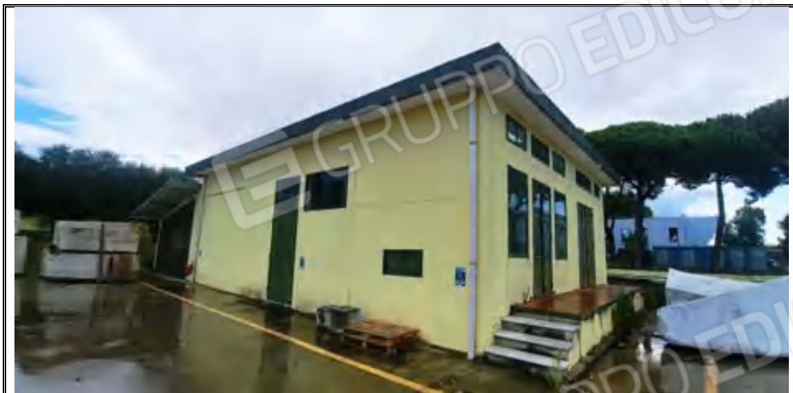
Foto n. 49– Corpo C – Magazzino mappale 548 – Angolo OVEST
