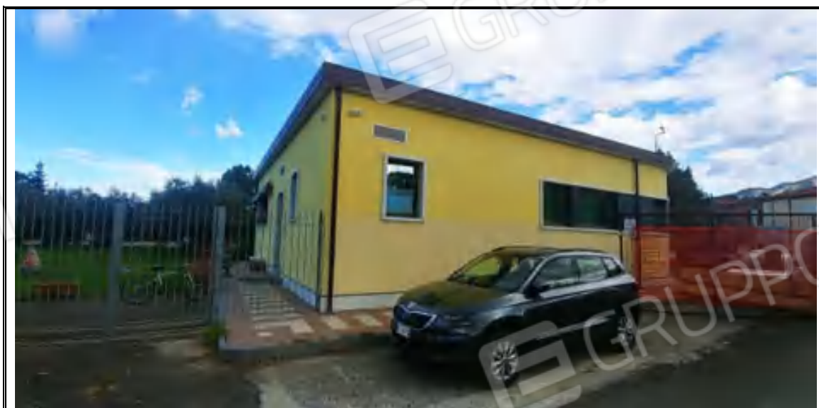
Foto n. 23– Corpo B – Palazzina uffici mappale 505 – Angolo SUD
