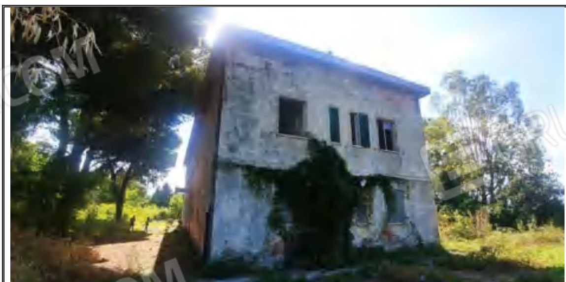
Foto n. 9 – Corpo A - Fabbricato mappale 282 – Angolo NORD
