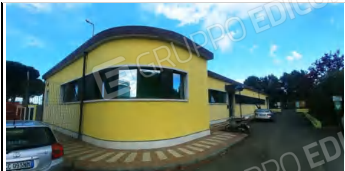
Foto n. 22– Corpo B – Palazzina uffici mappale 505 – Angolo EST
