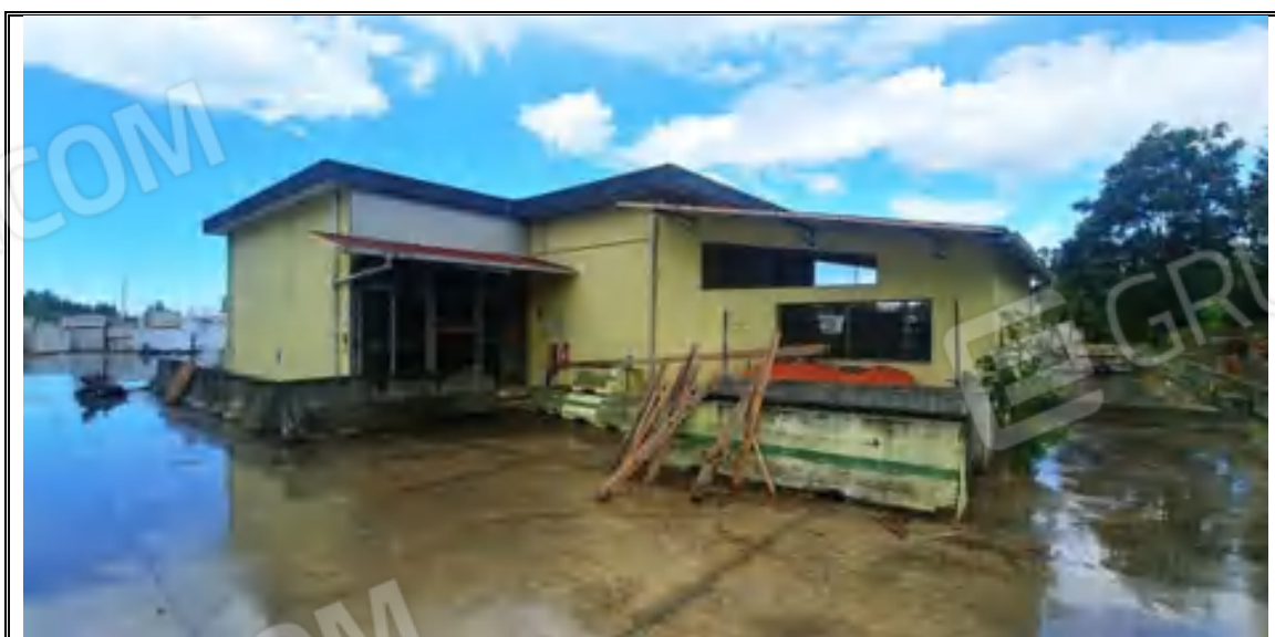
Foto n. 51 – Corpo C – Magazzino mappale 548 – Angolo EST
