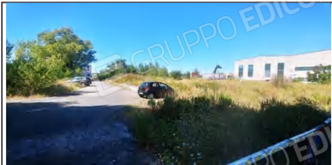
Foto n. 91– Corpo G – Terreno edificabile mappali 563/1, 563/2 e 564/2
