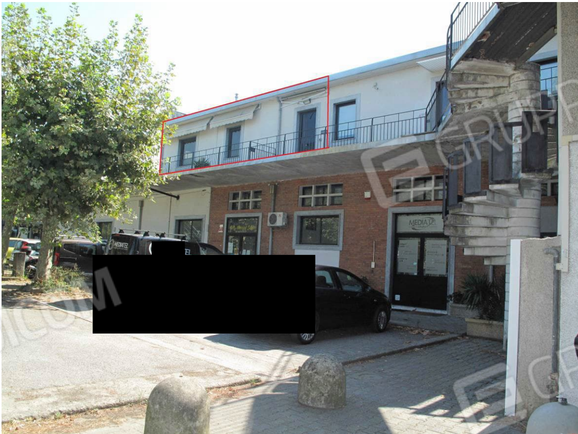
Foto 5. Esterno dal cortile interno
