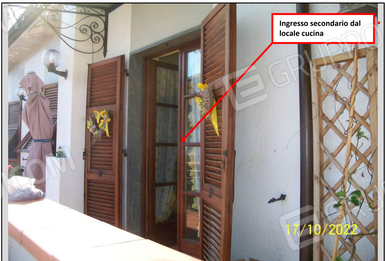
Vista Esterna: Balcone lato N-E dove è posto l'ingresso secondario dell'unità immobiliare
