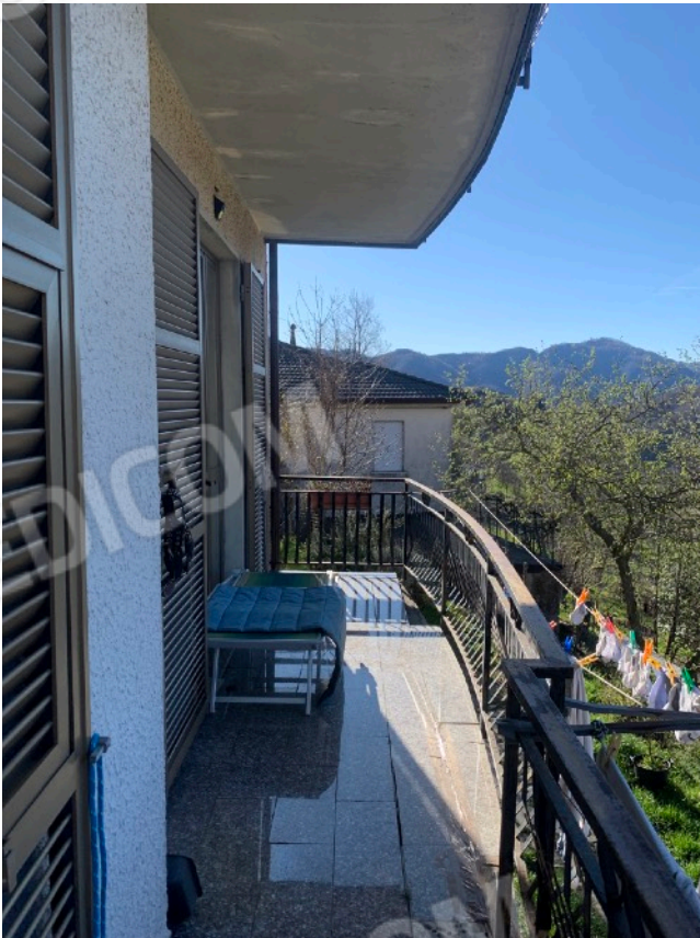
FOTO E7_ Balcone lato fronte SUD-OVEST
