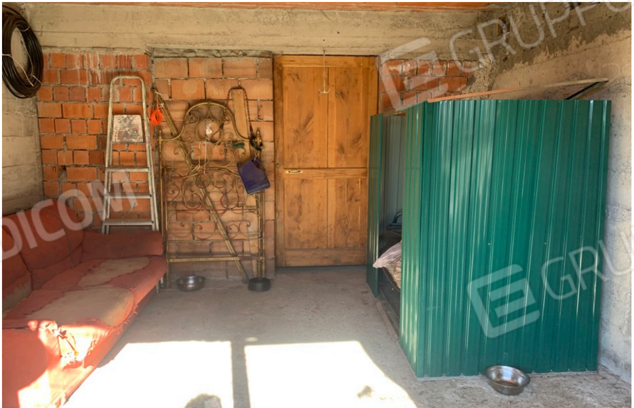
FOTO 10 _INTERNO garage/deposito (livello seminterrato )
