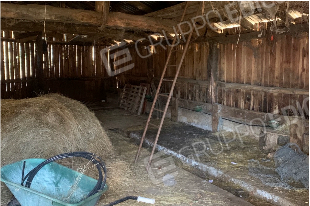
FOTO 3_fabbricato- stalla- part. 527. Interno
