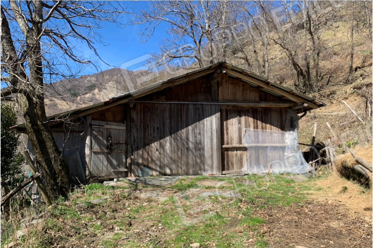
FOTO 1_fabbricato- stalla- part. 527
