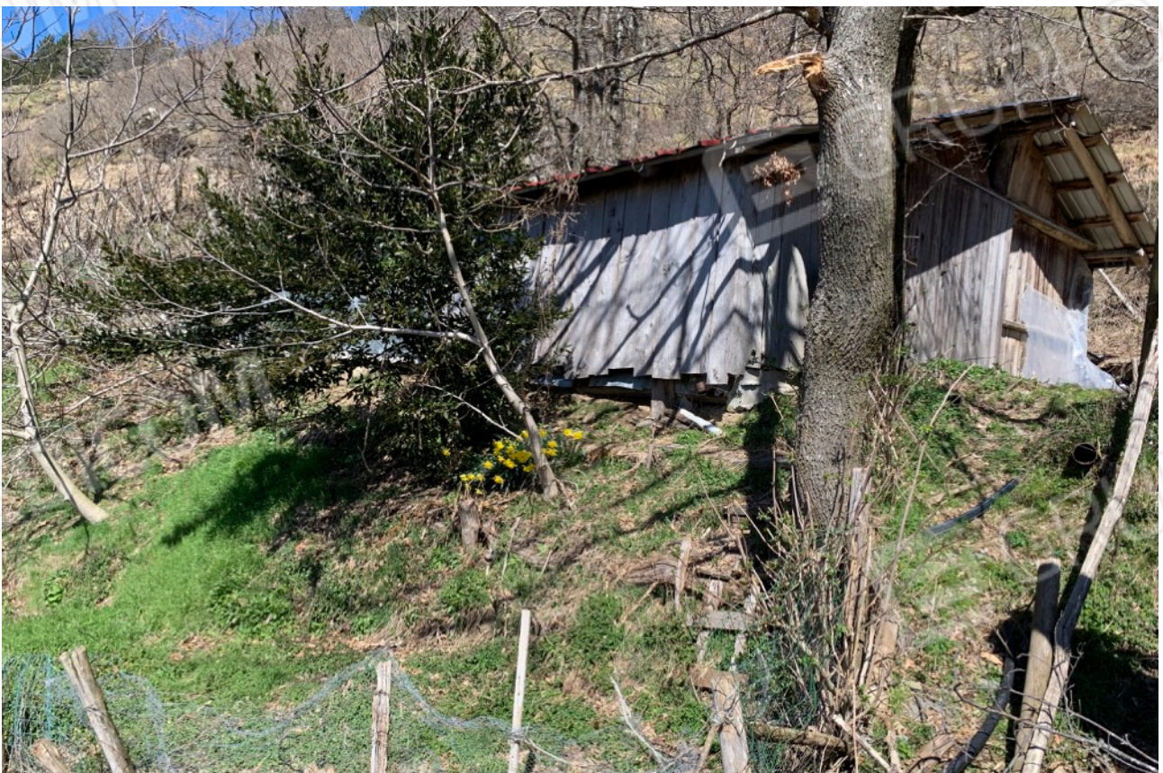
FOTO 2_fabbricato- stalla- part. 527
