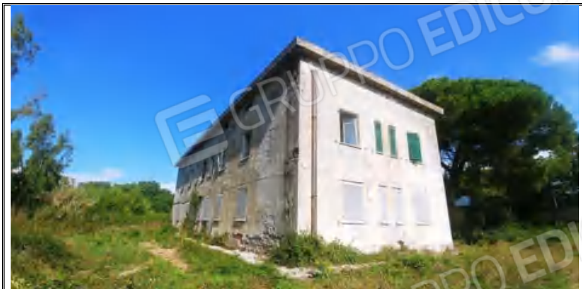
Foto n. 7– Corpo A - Fabbricato mappale 282 – Angolo SUD
