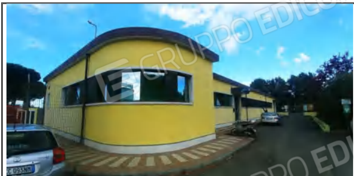
Foto n. 22– Corpo B – Palazzina uffici mappale 505 – Angolo EST
