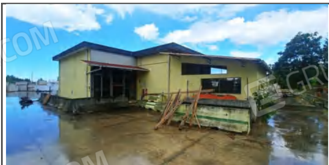
Foto n. 51 – Corpo C – Magazzino mappale 548 – Angolo EST
