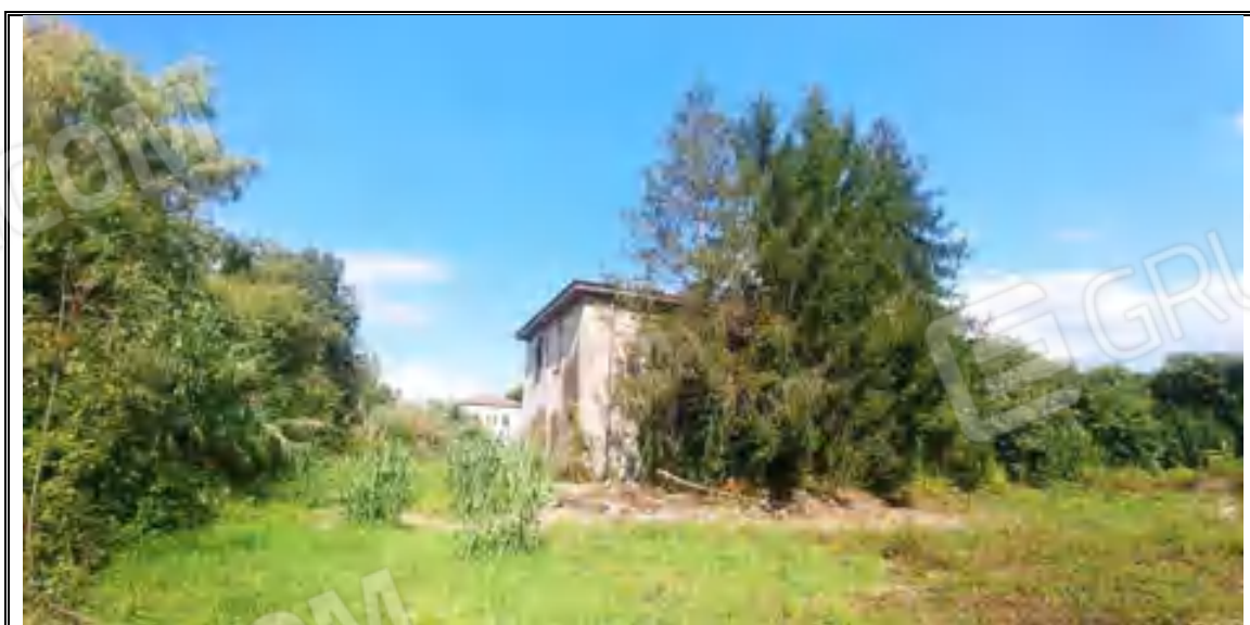
Foto n. 18 – Corpo A - Fabbricati mappali 282 e 287
