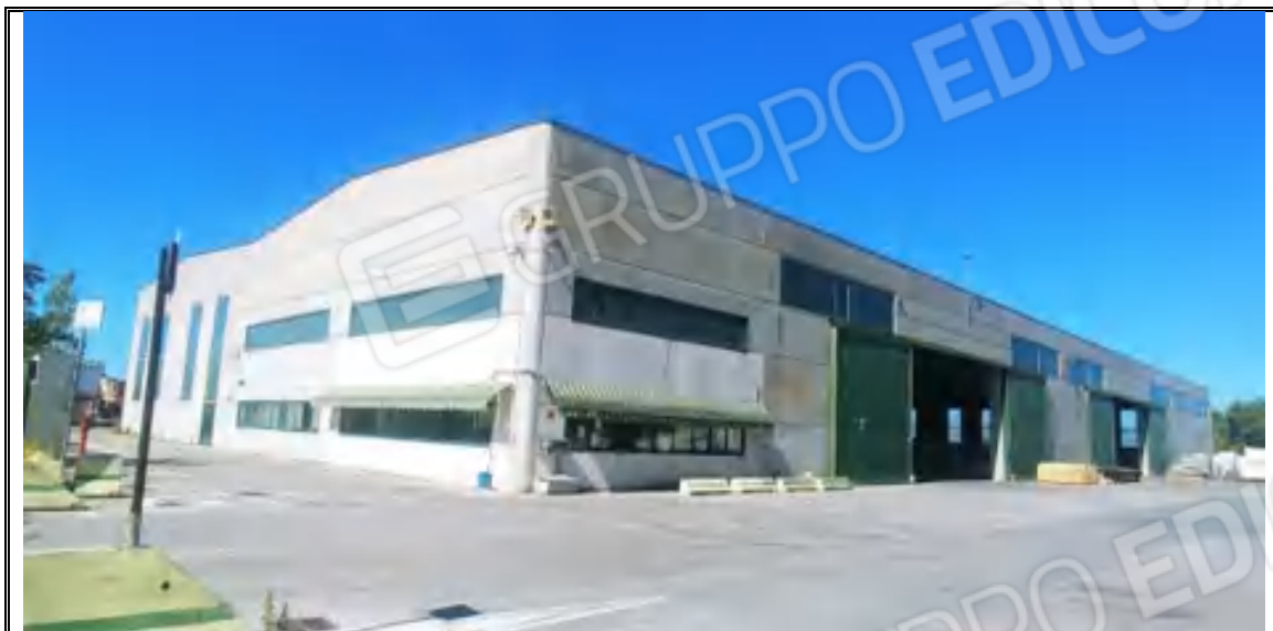
Foto n. 55– Corpo C – Capannone mappale 547 – Angolo EST
