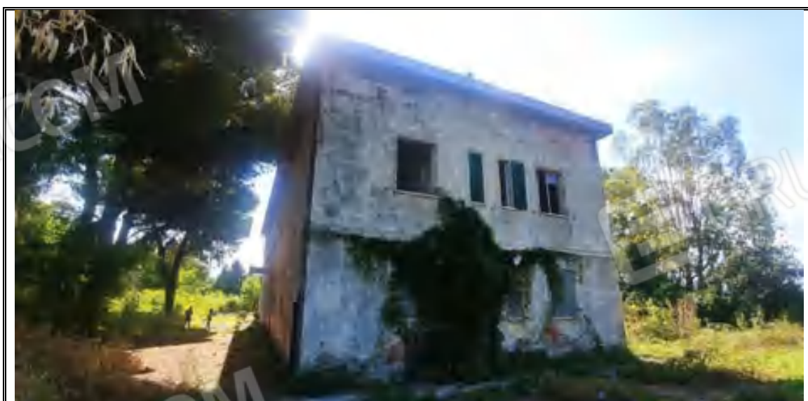
Foto n. 9 – Corpo A - Fabbricato mappale 282 – Angolo NORD
