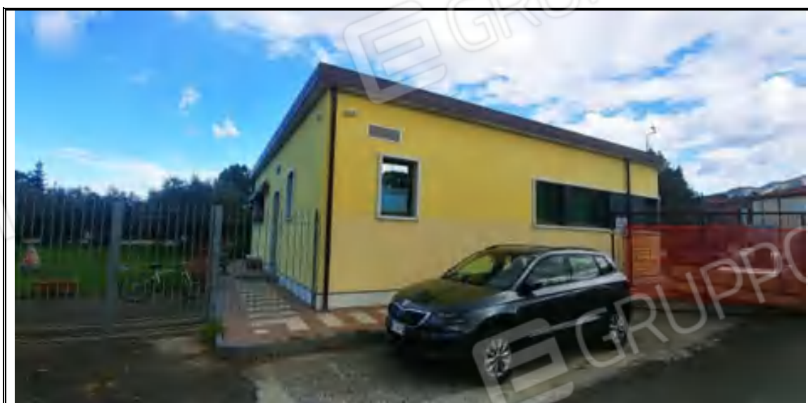
Foto n. 23– Corpo B – Palazzina uffici mappale 505 – Angolo SUD
