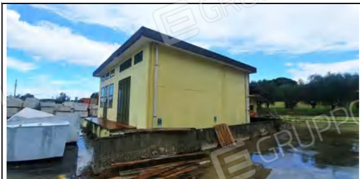
Foto n. 50– Corpo C – Magazzino mappale 548 – Angolo SUD
