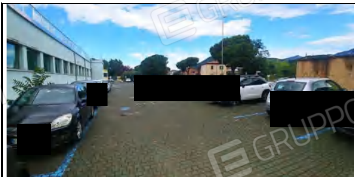
Foto n. 83 – Corpo E – Terreni mappali 506 e 522 – Parcheggio
