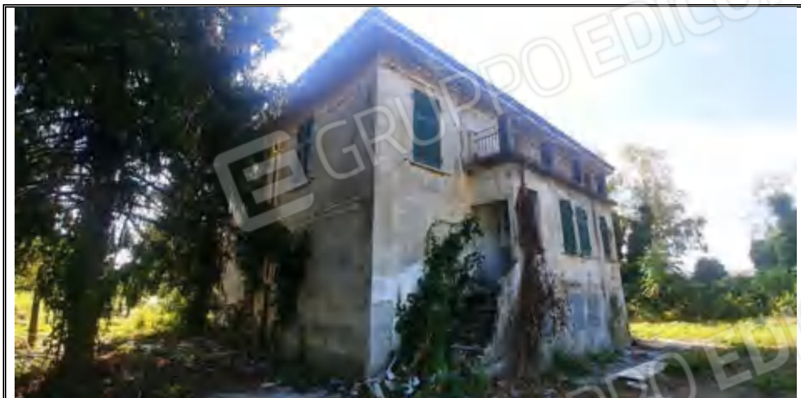
Foto n. 16– Corpo A - Fabbricato mappale 287 – Angolo NORD
