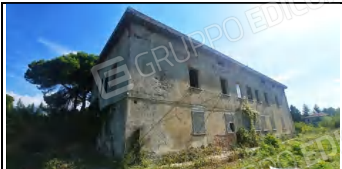
Foto n. 10– Corpo A - Fabbricato mappale 282 – Angolo OVEST
