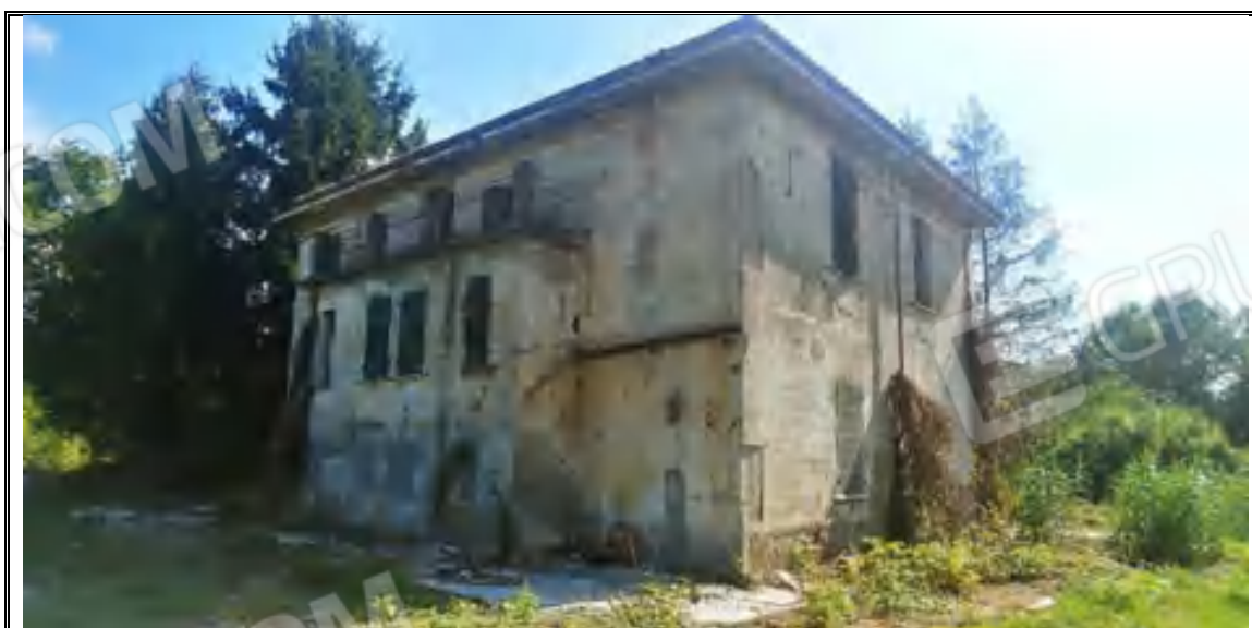
Foto n. 15 – Corpo A - Fabbricato mappale 287 – Angolo OVEST
