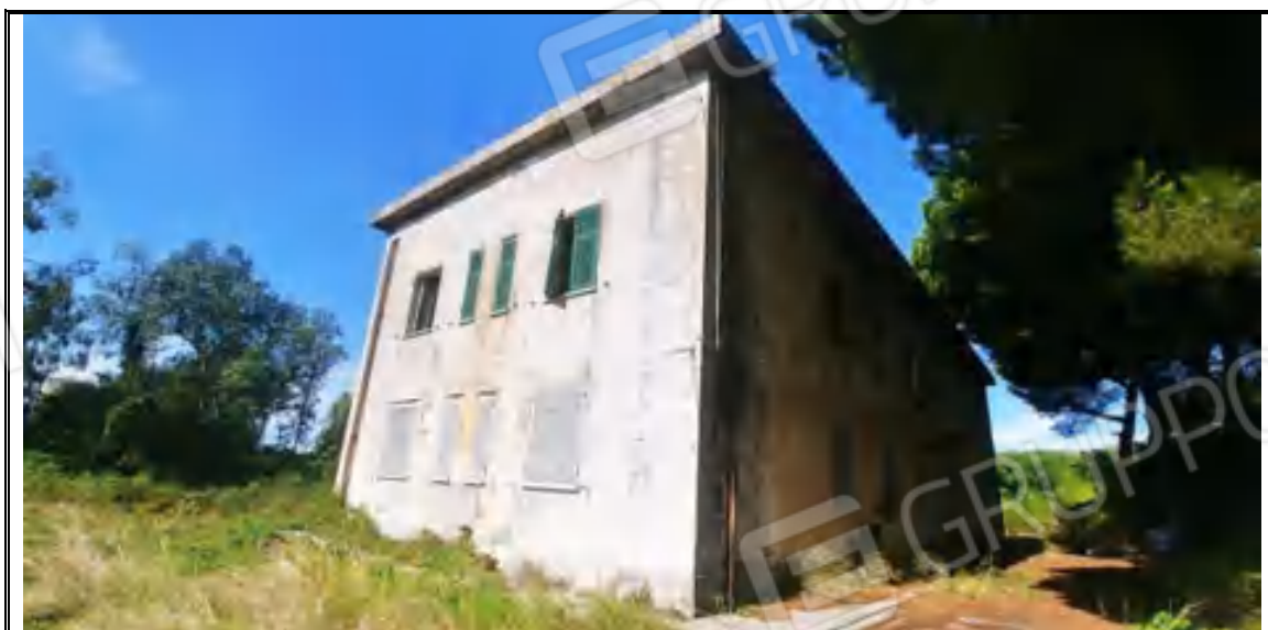
Foto n. 8 – Corpo A - Fabbricato mappale 282 – Angolo EST
