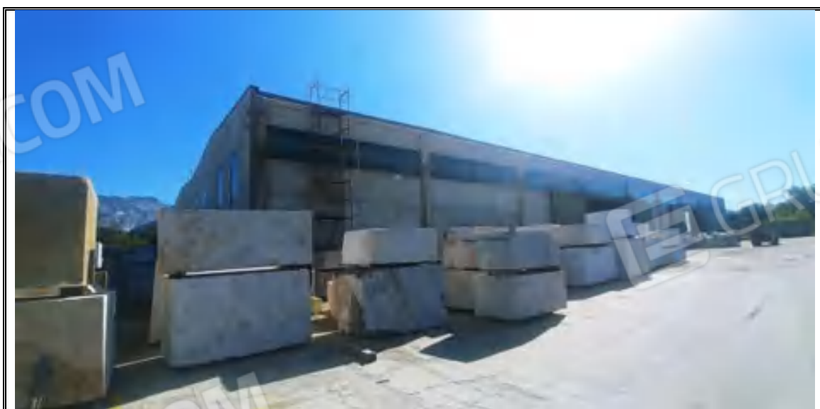
Foto n. 57 – Corpo C – Capannone mappale 547 – Angolo OVEST
