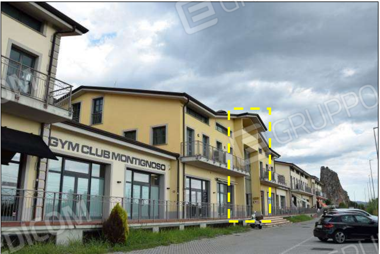
INDIVIDUAZIONE ACCESSO VANO SCALA “B” (BLOCCO CENTRALE)
