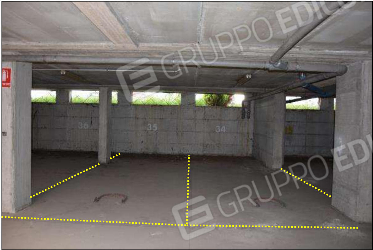
FOTO 3 – SUB 115 (POSTO 35) – SUB 116 (POSTO 34)
