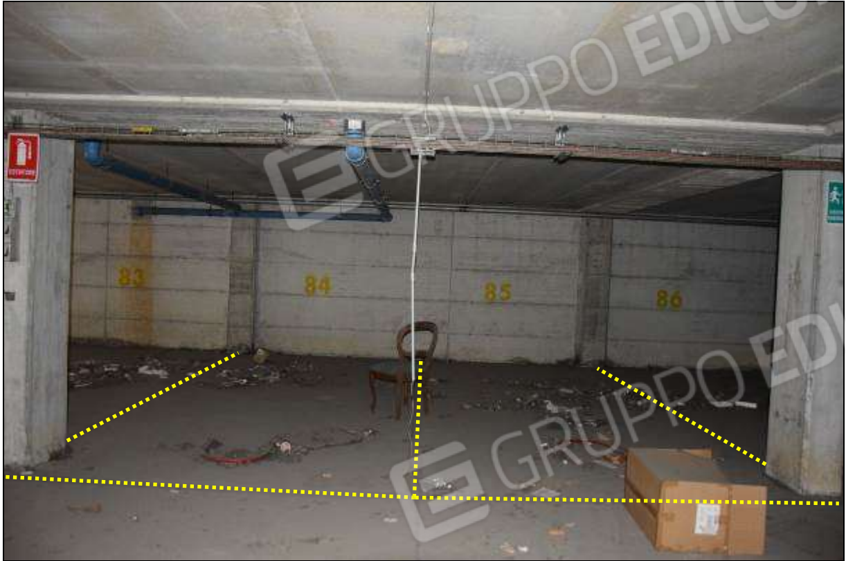
FOTO 3 – SUB 71 (POSTO 84) / SUB 72 (POSTO 85)
