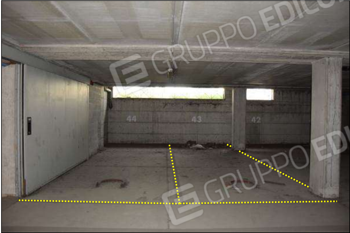
FOTO 1 – SUB 106 (POSTO 44) / SUB 107 (POSTO 43)
