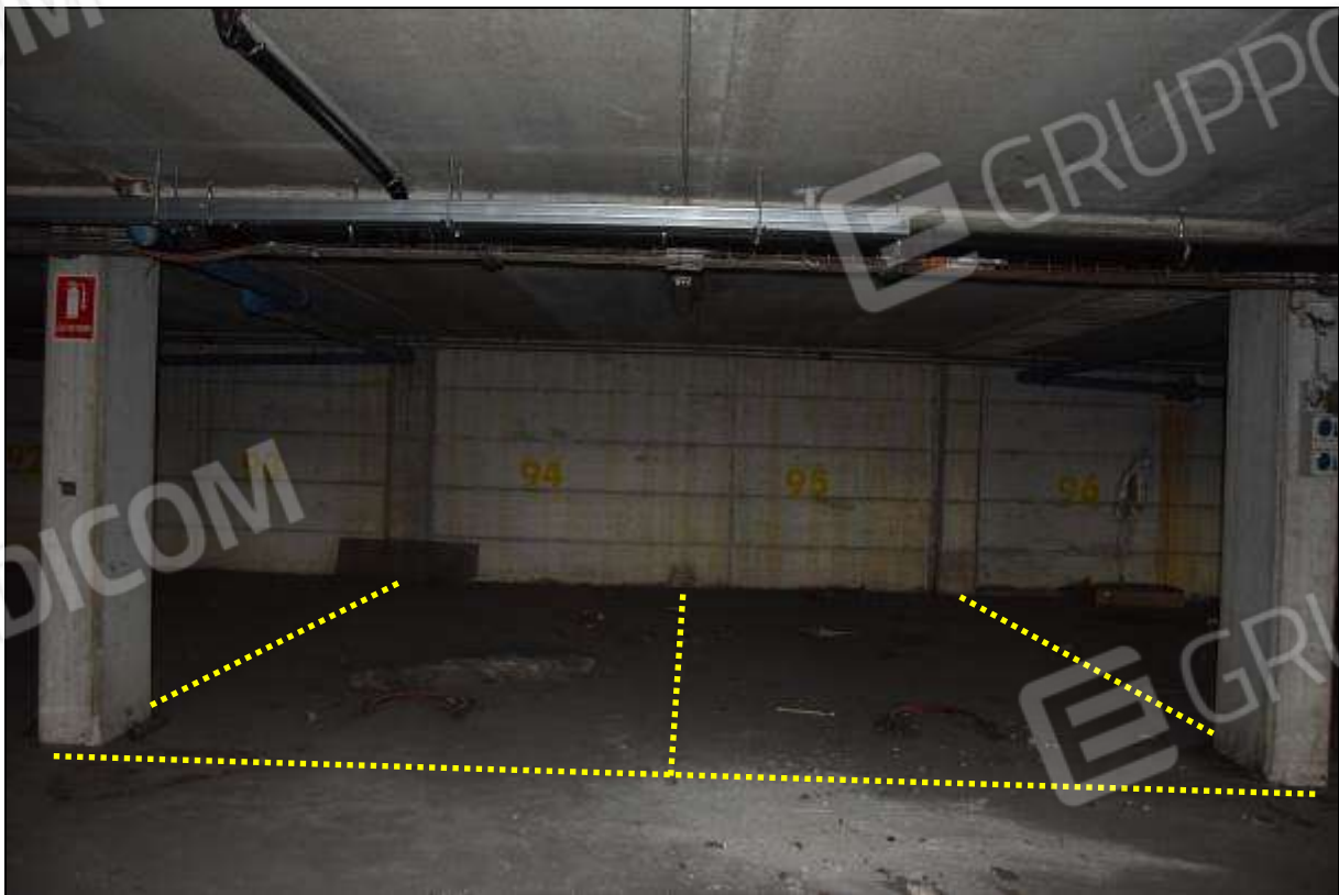
FOTO 8 – SUB 81 (POSTO 94) / SUB 82 (POSTO 95)
