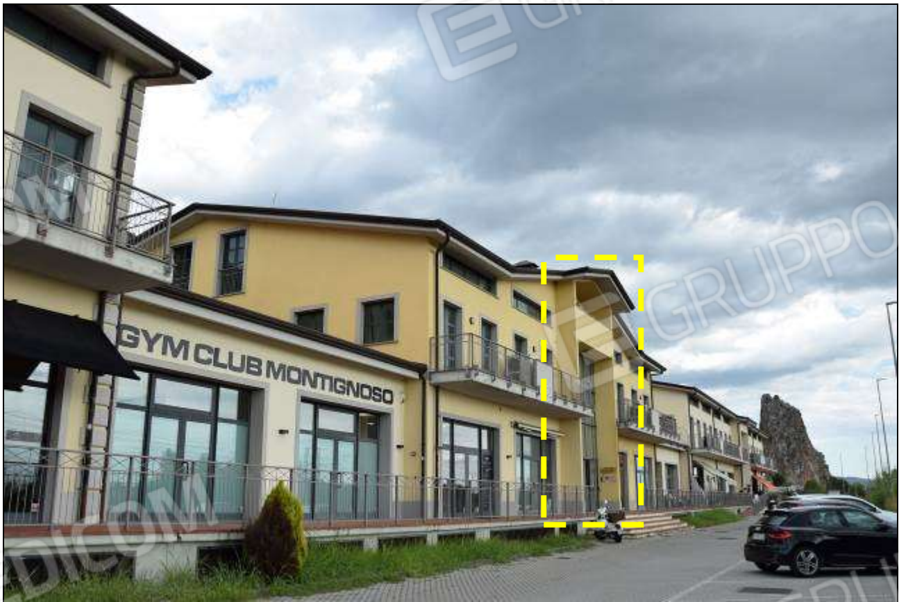
INDIVIDUAZIONE ACCESSO VANO SCALA “B” (BLOCCO CENTRALE)
