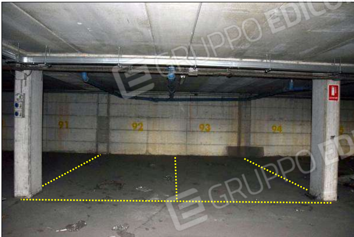
FOTO 7 – SUB 79 (POSTO 92) / SUB 80 (POSTO 93)
