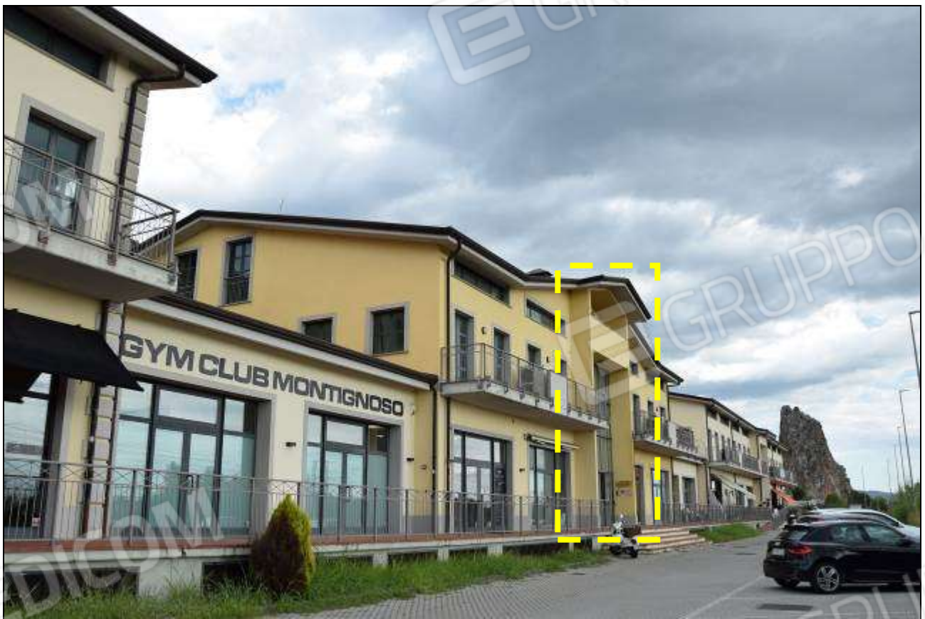
INDIVIDUAZIONE ACCESSO VANO SCALA “B” (BLOCCO CENTRALE)
