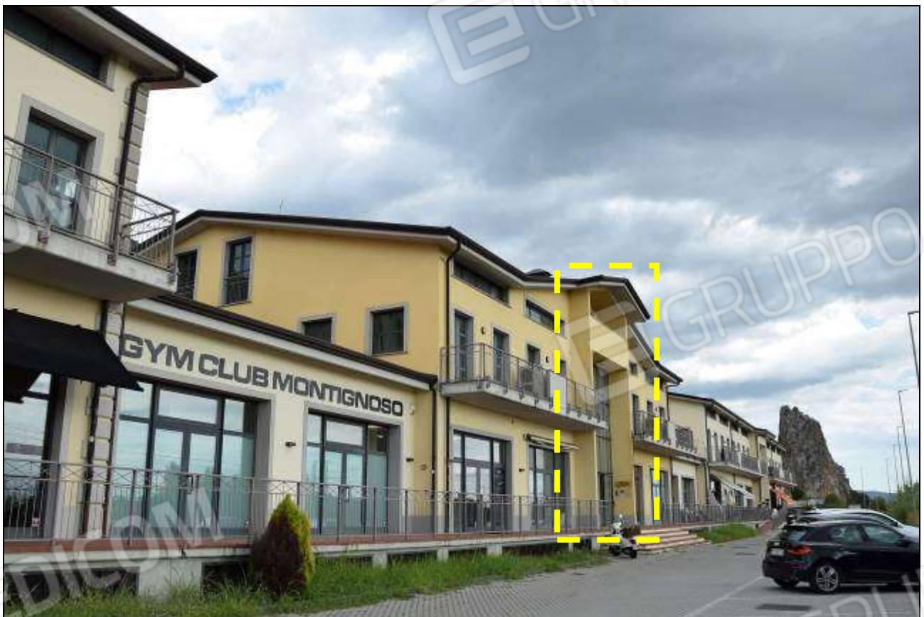
INDIVIDUAZIONE ACCESSO VANO SCALA “B” (BLOCCO CENTRALE)
