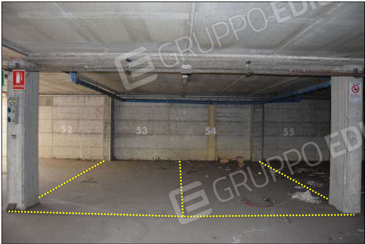
FOTO 1 – SUB 57 (POSTO 53) / SUB 58 (POSTO 54)
