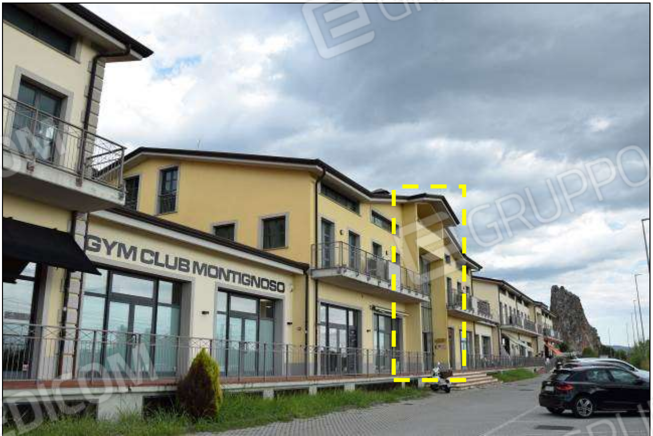
INDIVIDUAZIONE ACCESSO VANO SCALA “B” (BLOCCO CENTRALE)
