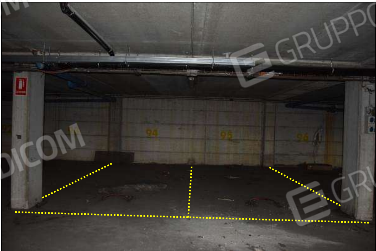
FOTO 8 – SUB 81 (POSTO 94) / SUB 82 (POSTO 95)
