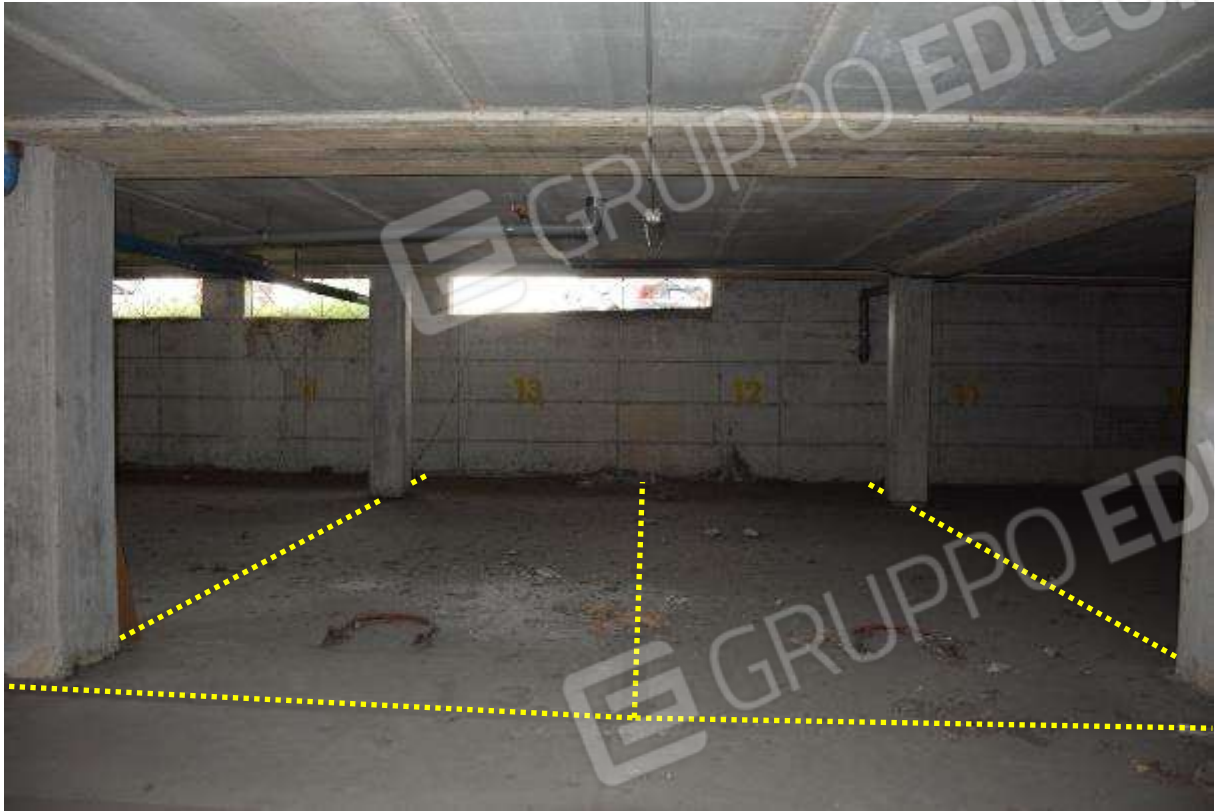
FOTO 13 – SUB 119 (POSTO 13) / SUB 120 (POSTO 12)
