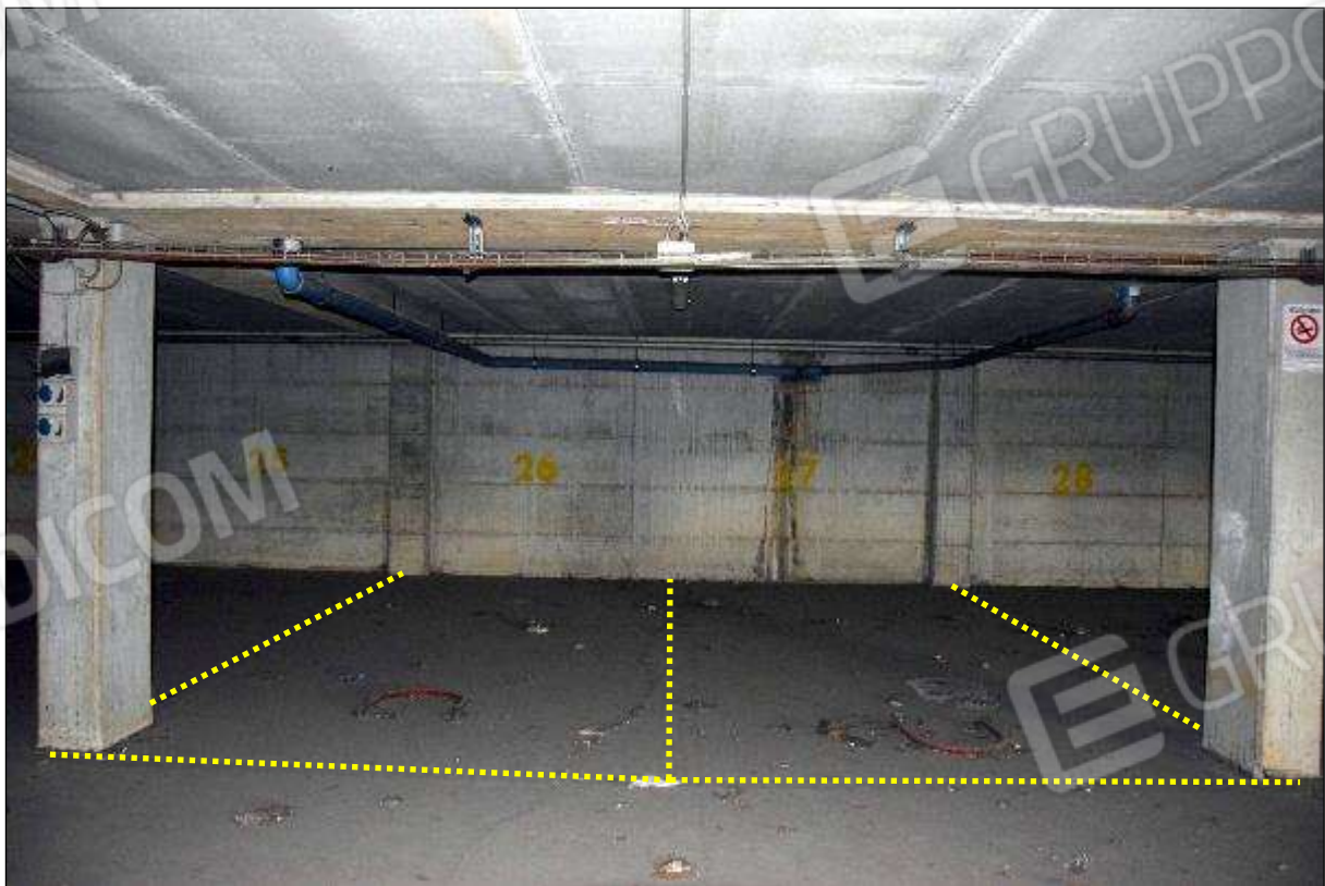
FOTO 6 – SUB 47 (POSTO 26) / SUB 48 (POSTO 27)
