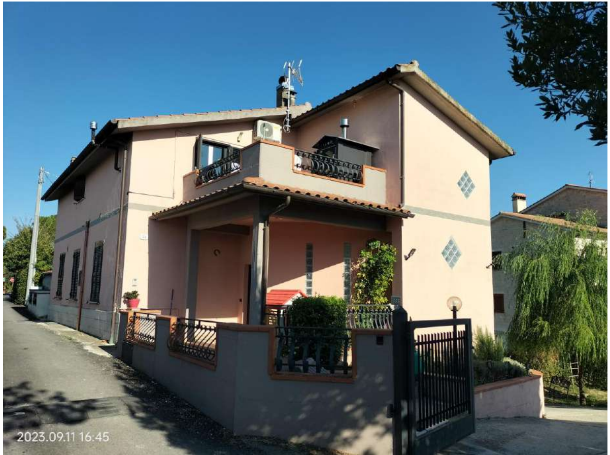
esterno fabbricato lato ovest - dalla strada di accesso
