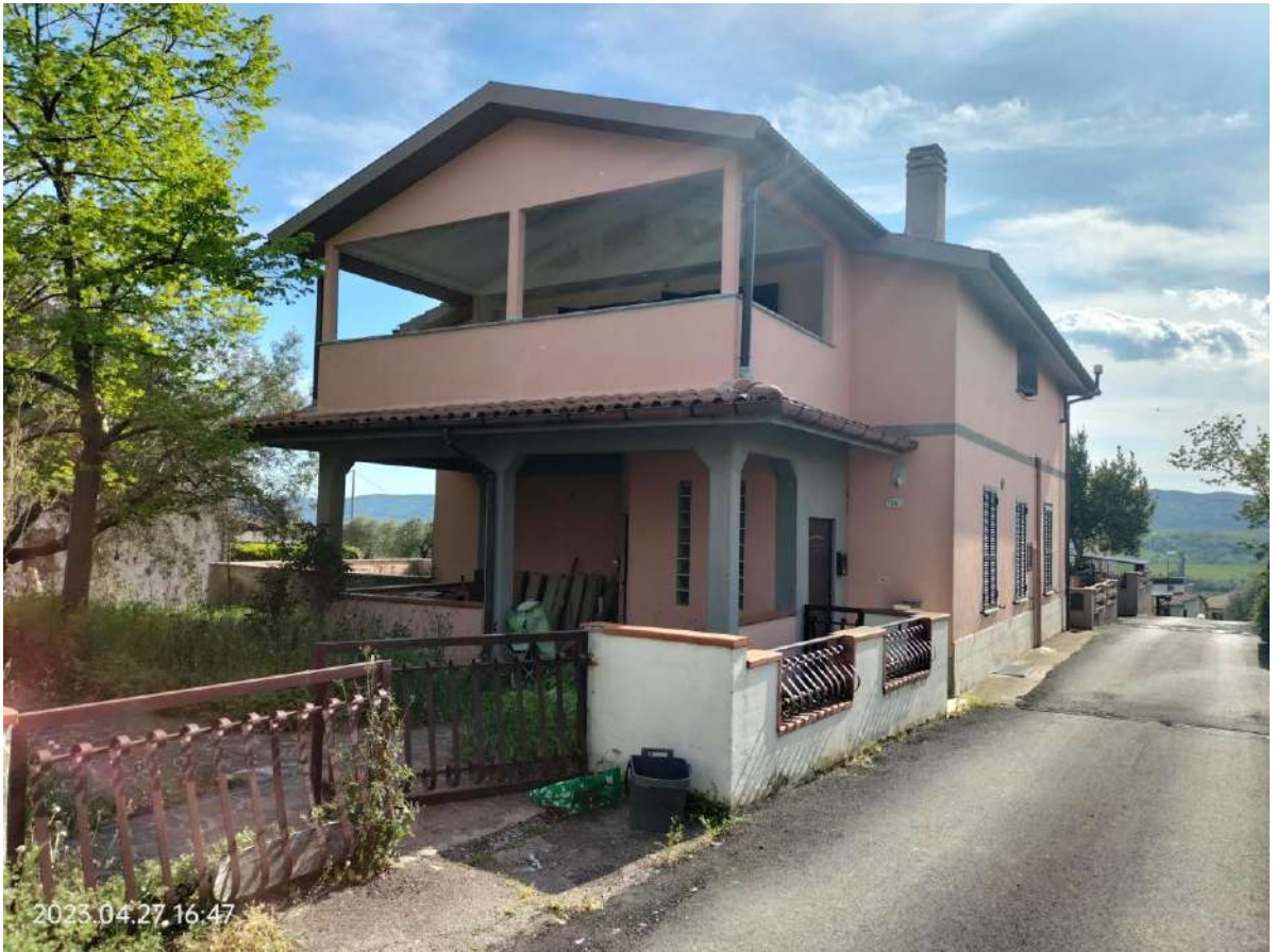
esterno fabbricato - dalla strada di accesso
