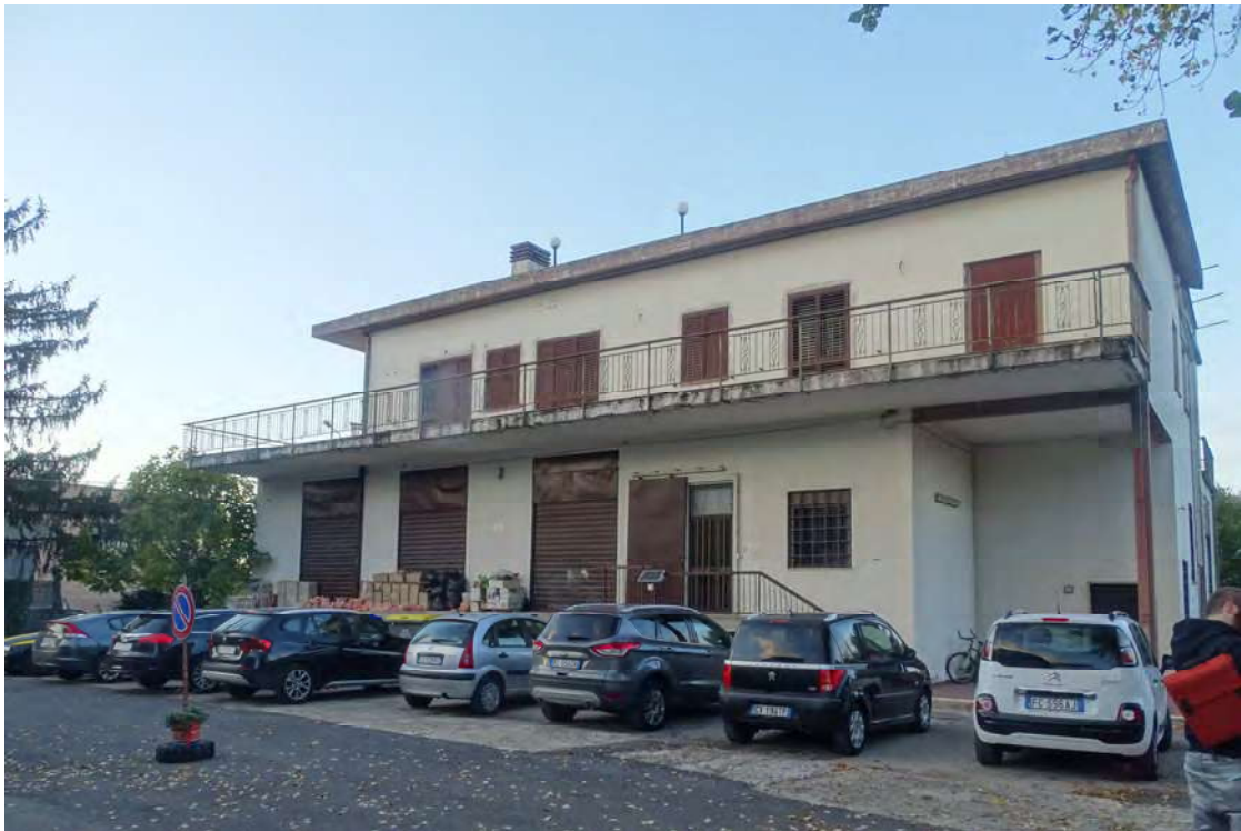
VISTA ESTERNA – FRONTE SUD (foto n.2)
