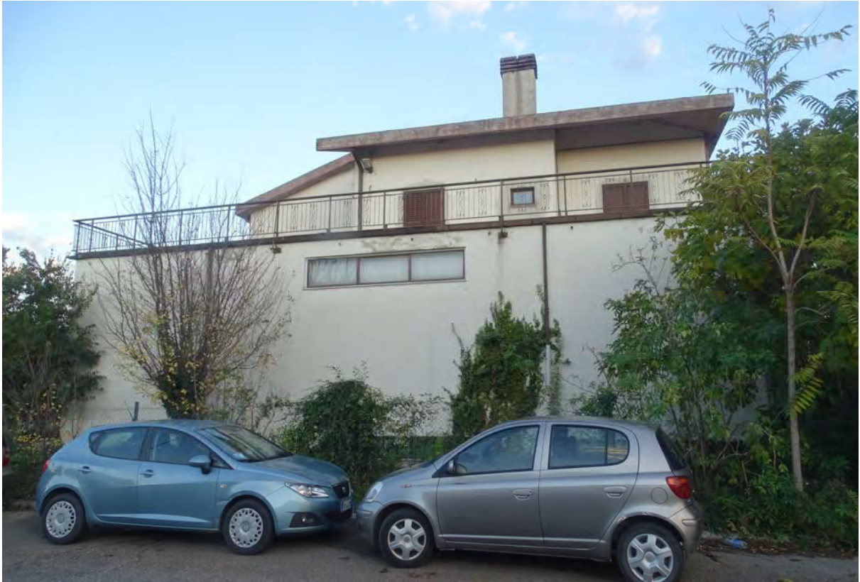
VISTA ESTERNA – FRONTE OVEST (foto n.5)
