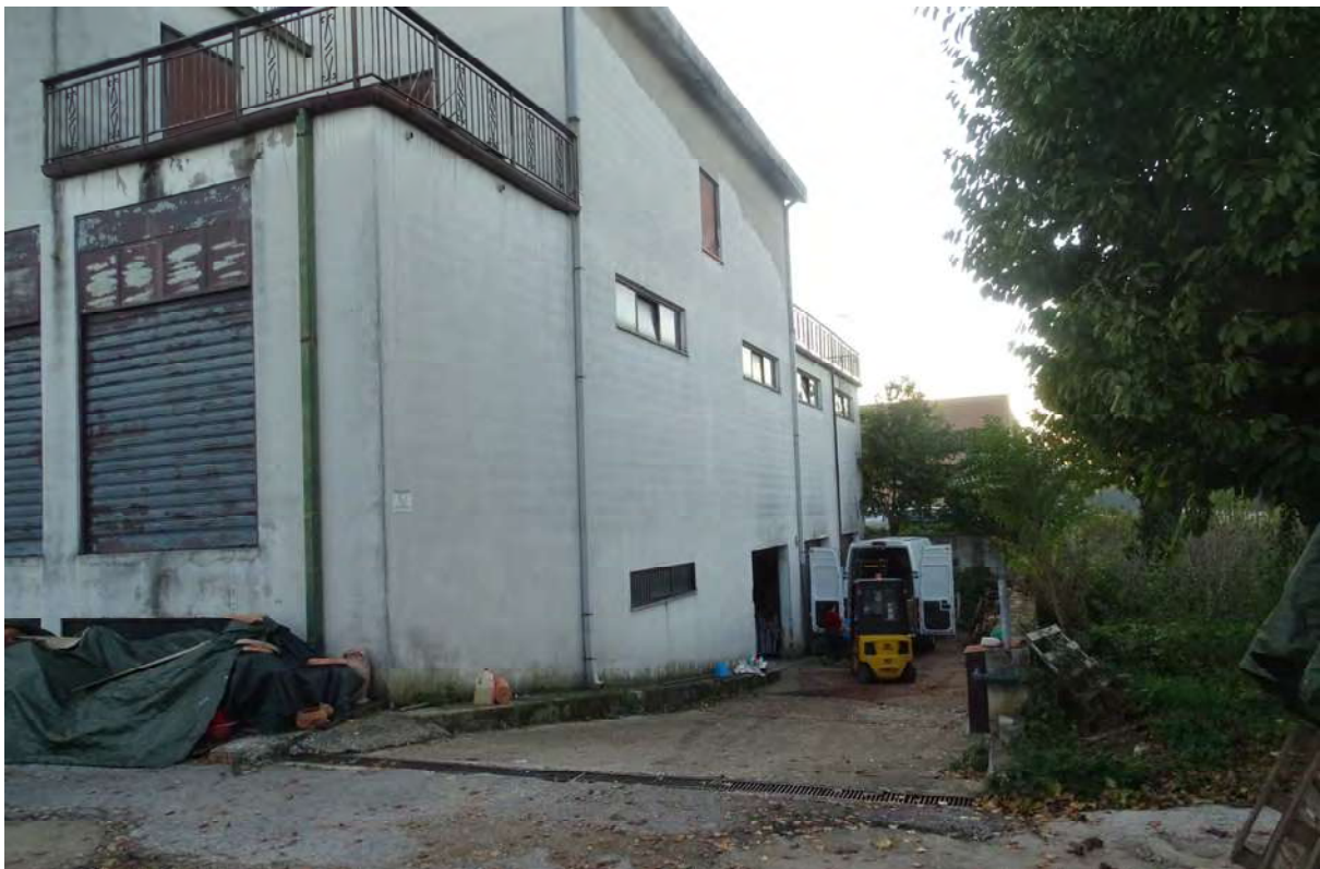
RAMPA DI ACCESSO AL PIANO INTERRATO (foto n.6)
