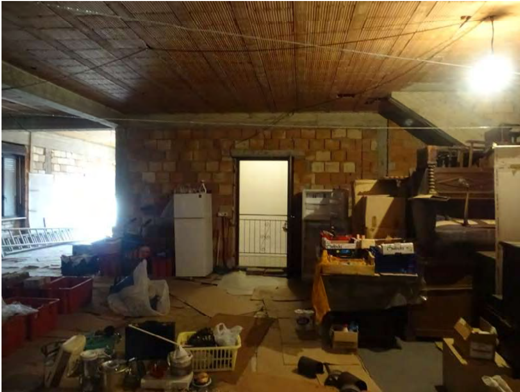
UNITA' IMMOBILIARE NON ULTIMATA (foto n.41)
