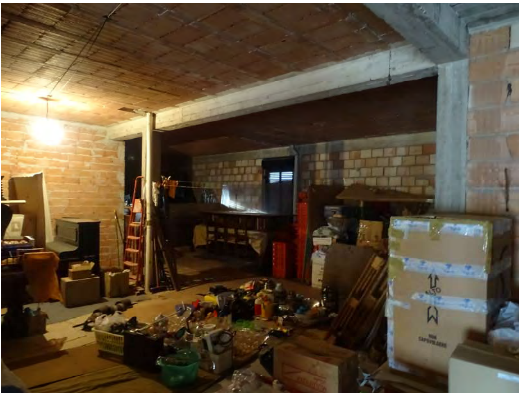
UNITA' IMMOBILIARE NON ULTIMATA (foto n.42)
