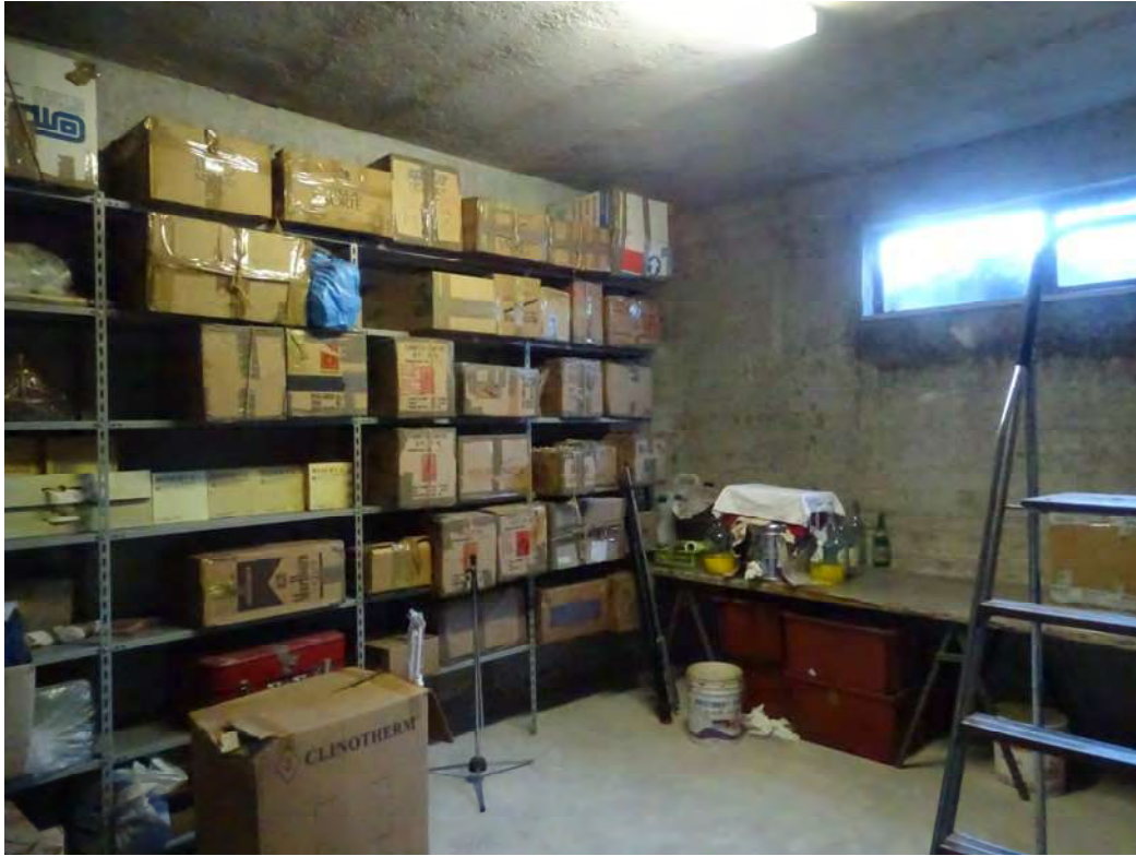
CANTINA – PIANO INTERRATO (foto n.23)
