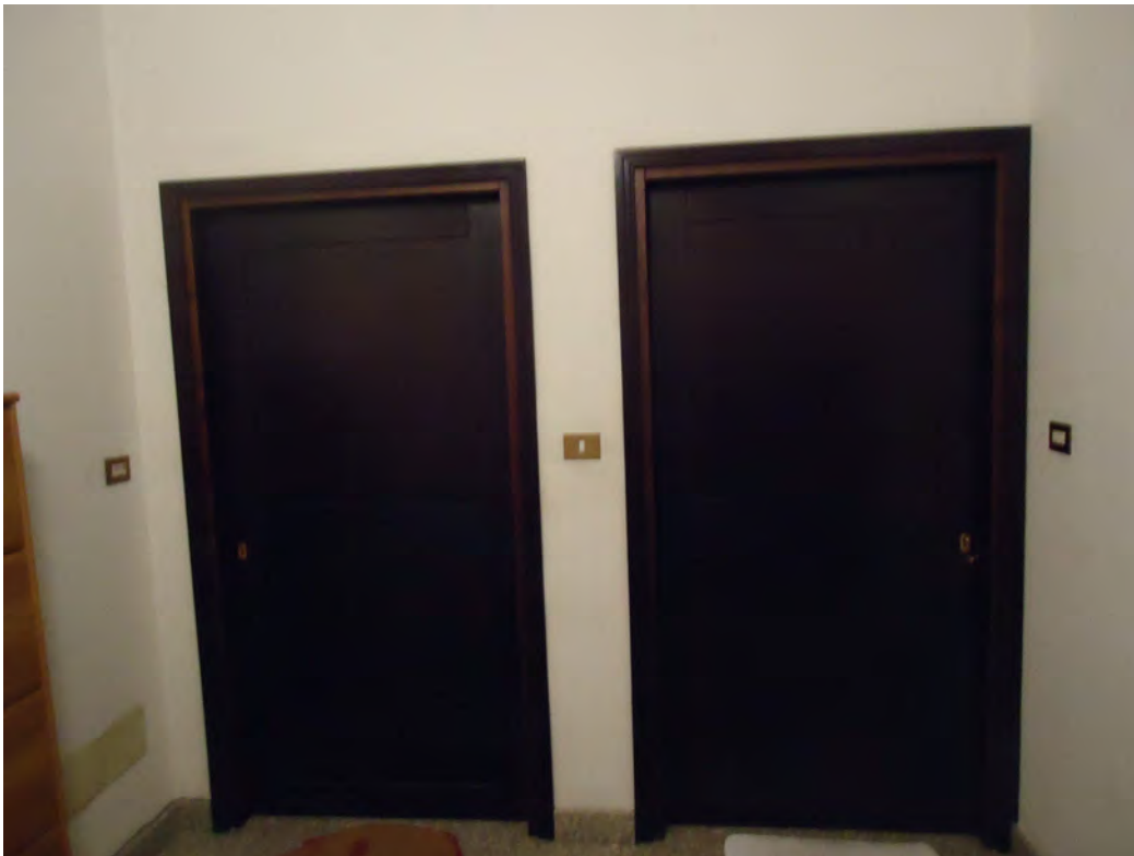
SCALA COMUNE – PIANO PRIMO (foto n.8)
