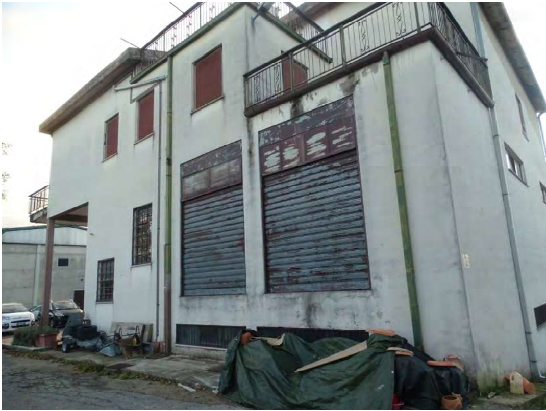
VISTA ESTERNA – FRONTE EST (foto n.3)
