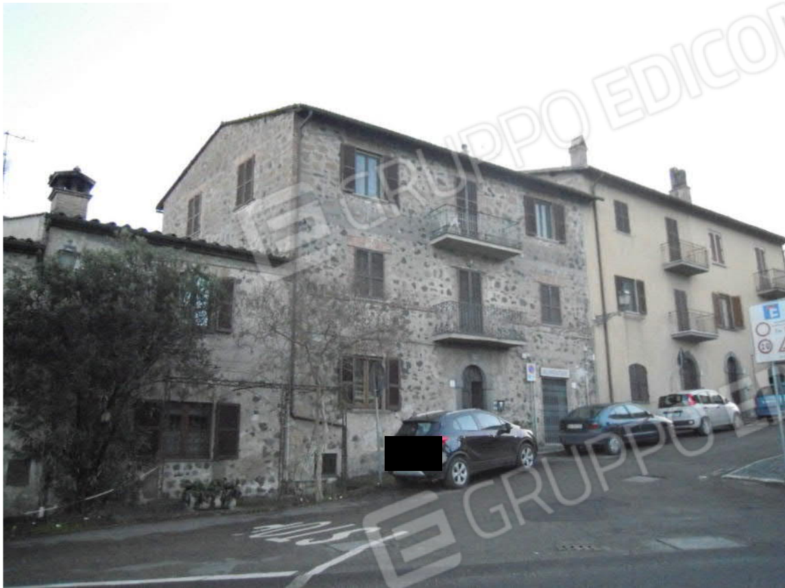
vista esterna dell'appartamento al piano 2° (ultimo)
