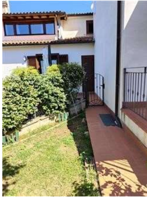
Vista prospetto ovest
