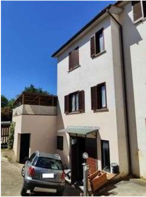
Vista prospetto est
