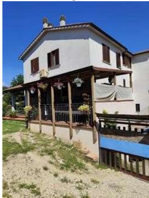
Vista prospetto sud
