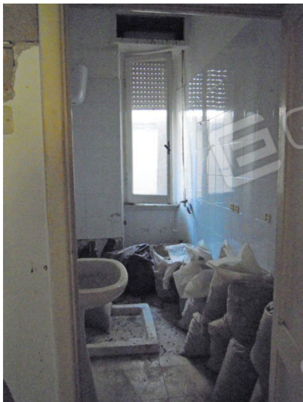
FOTO 7 – vista del WC
