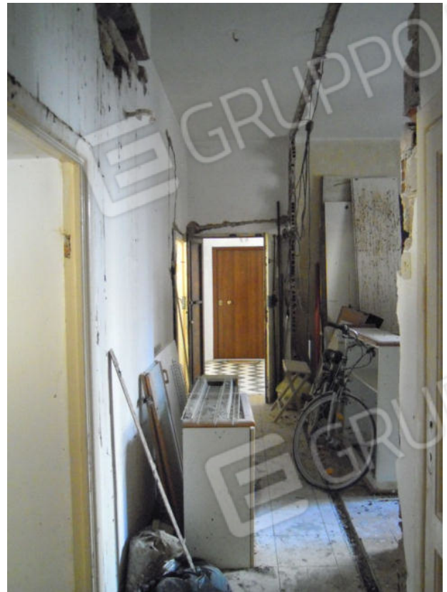
FOTO 6 – vista del corridoio verso l'ingresso
