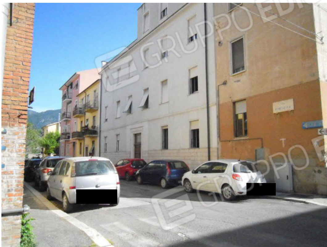
FOTO 1 – vista dell'edificio condominiale da via Eugenio Chiesa
