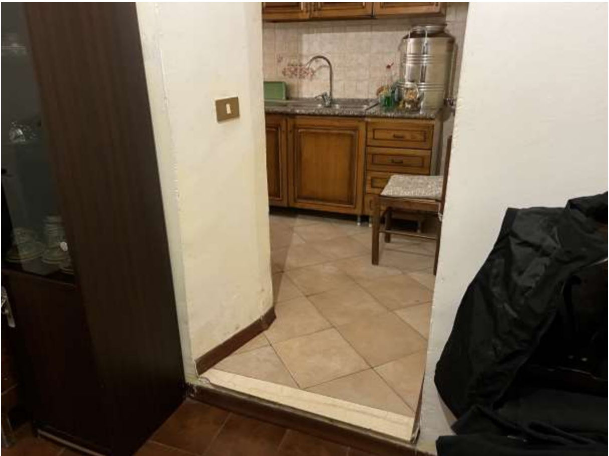
Accesso alla cucina (autorizzata come cantina) P.T.
