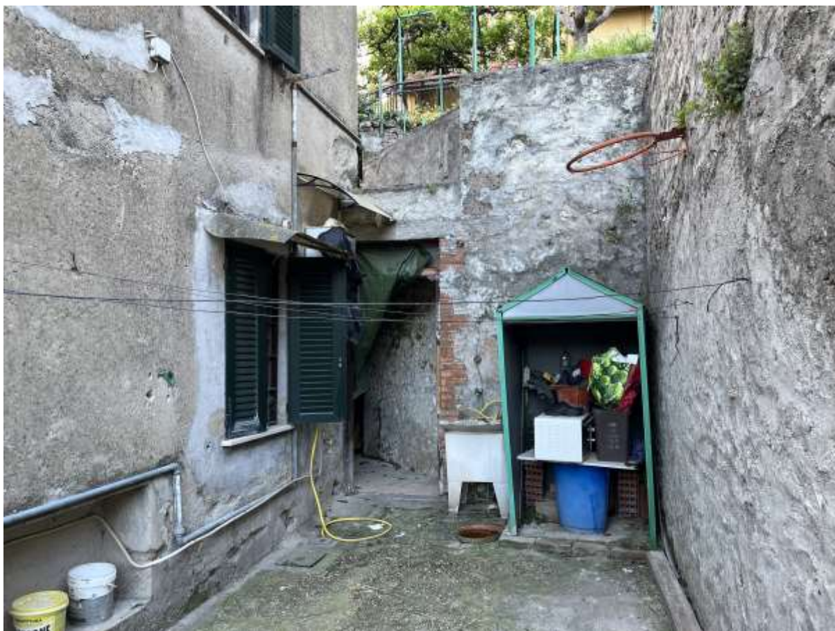
Area urbana comune (F. 73 P.lla 113 Sub 5) e ingresso alla cantina
