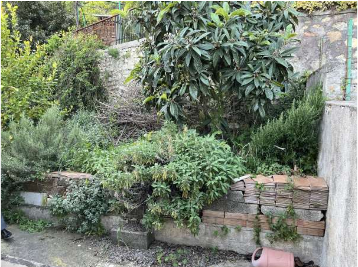
Area urbana comune (F. 73 P.lla 113 Sub 4) posta sul retro del fabbricato
