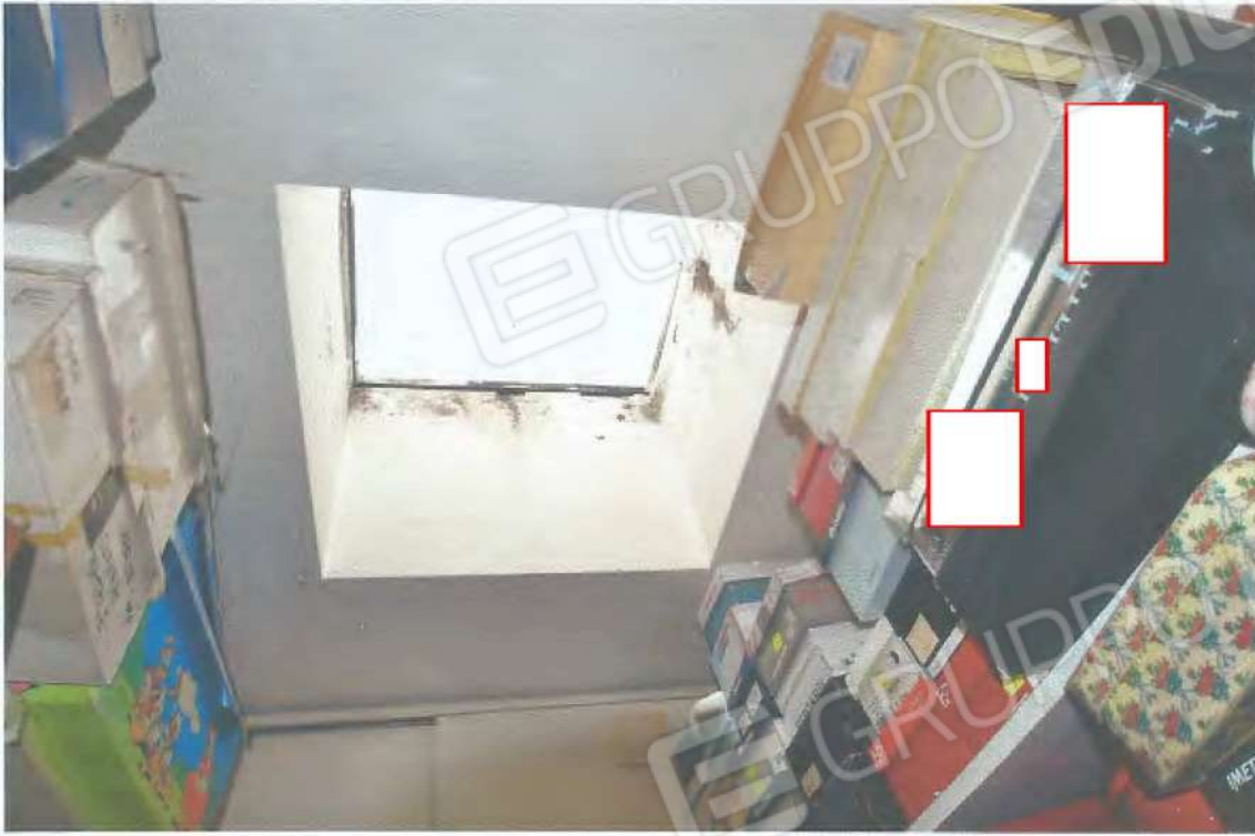
09) Vista infiltrazione al perimetro del lucernario del ripostiglio; 10) Vista tinello;
