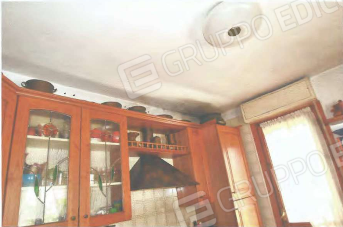
07) Vista infiltrazione all'angolo nord-est del soffitto della cucina; 08) Vista cucina;
