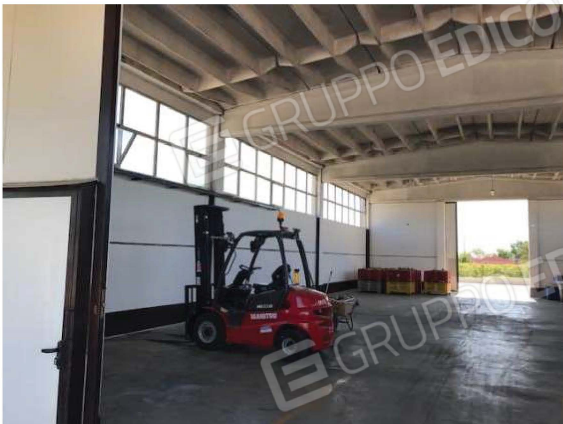
Foto 01 – Vista interna del capannone (parte sinistra entrando dall'ingresso principale anteriore)
