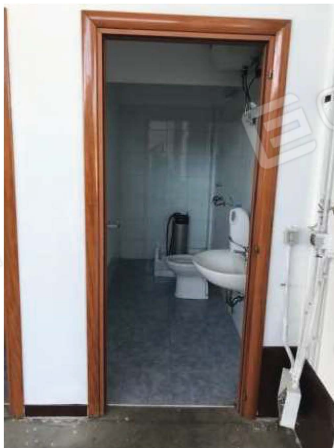
Foto 08 – Dettaglio dell'ingresso nel WC2
