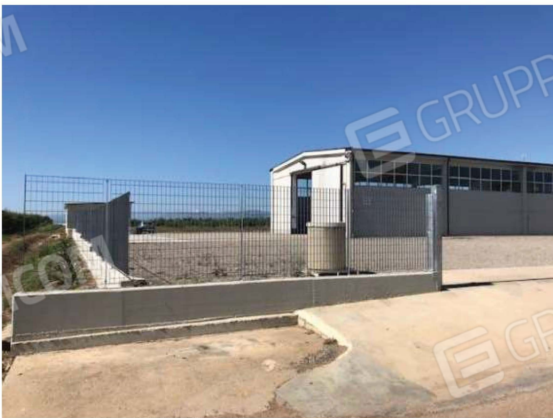
Foto 02 – Vista del capannone dall'ingresso di sinistra
