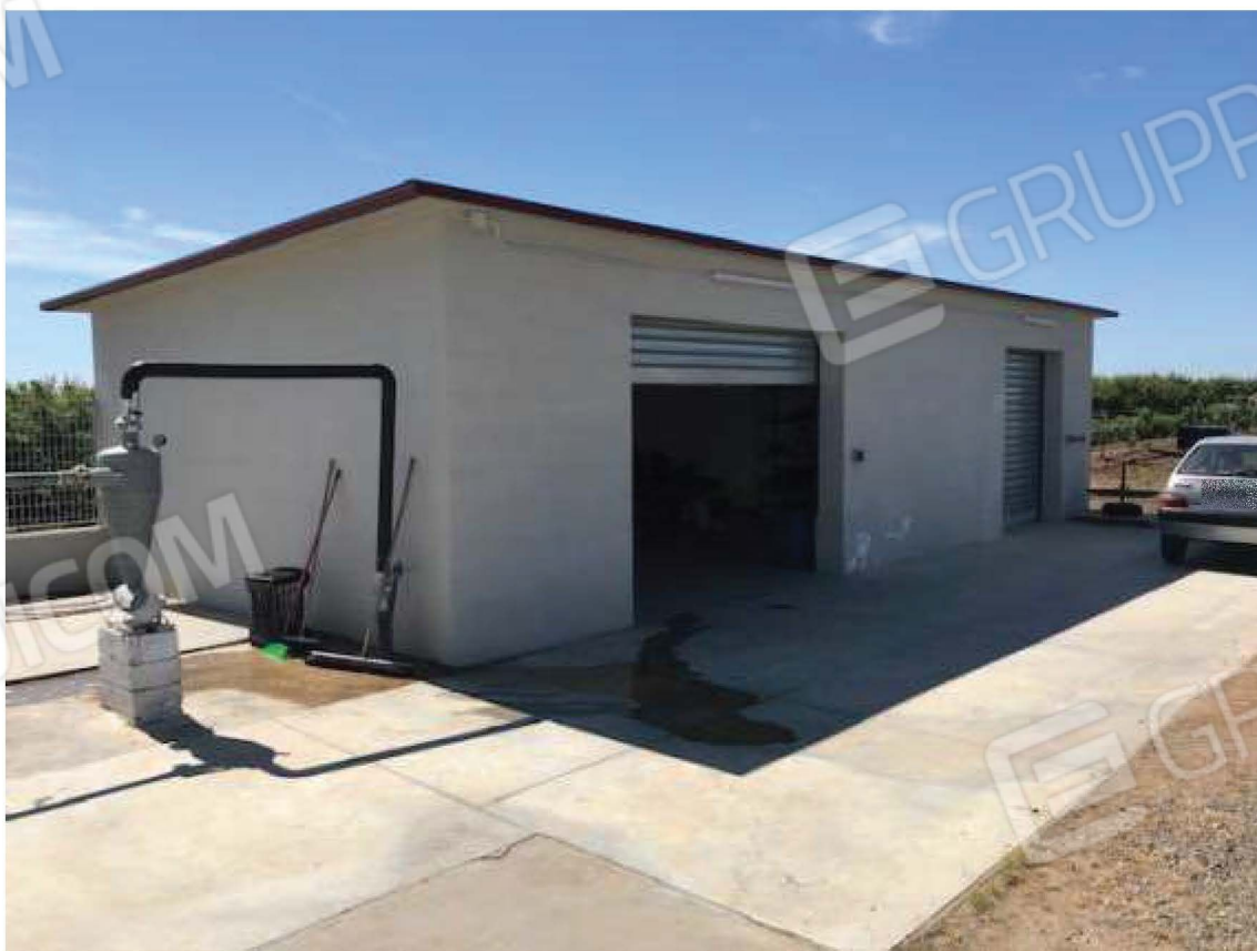
Foto 06 – Vista del deposito posteriore
