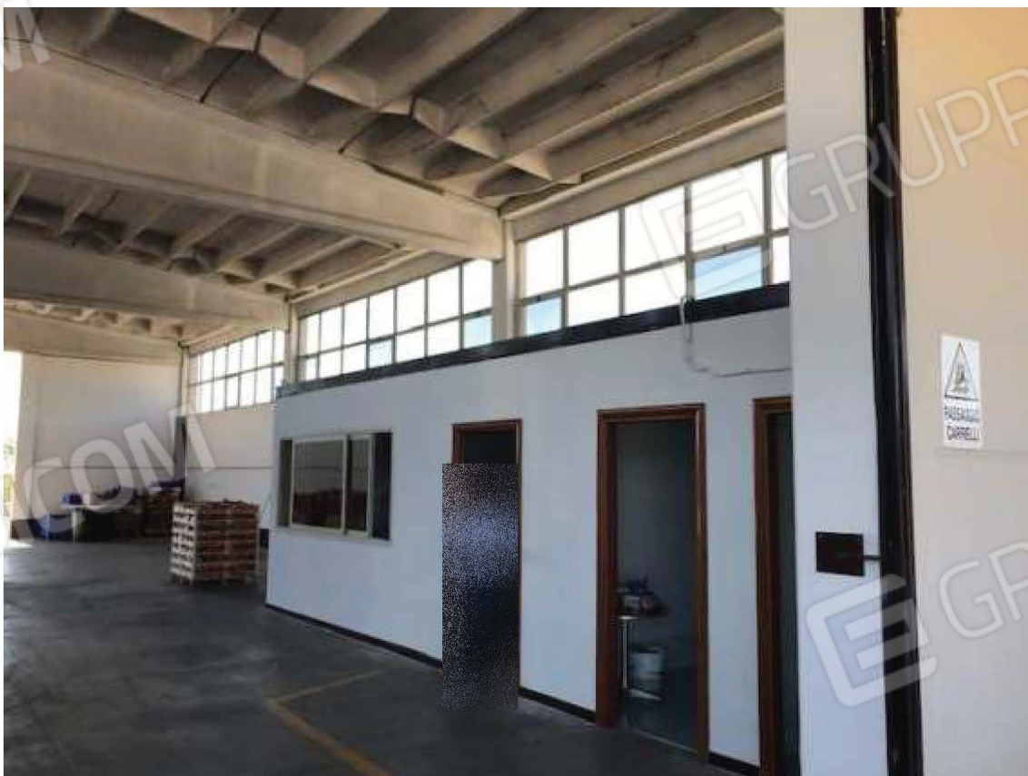
Foto 02 – Vista interna del capannone, con ufficio e WC (parte destra entrando dall'ingresso principale anteriore)
