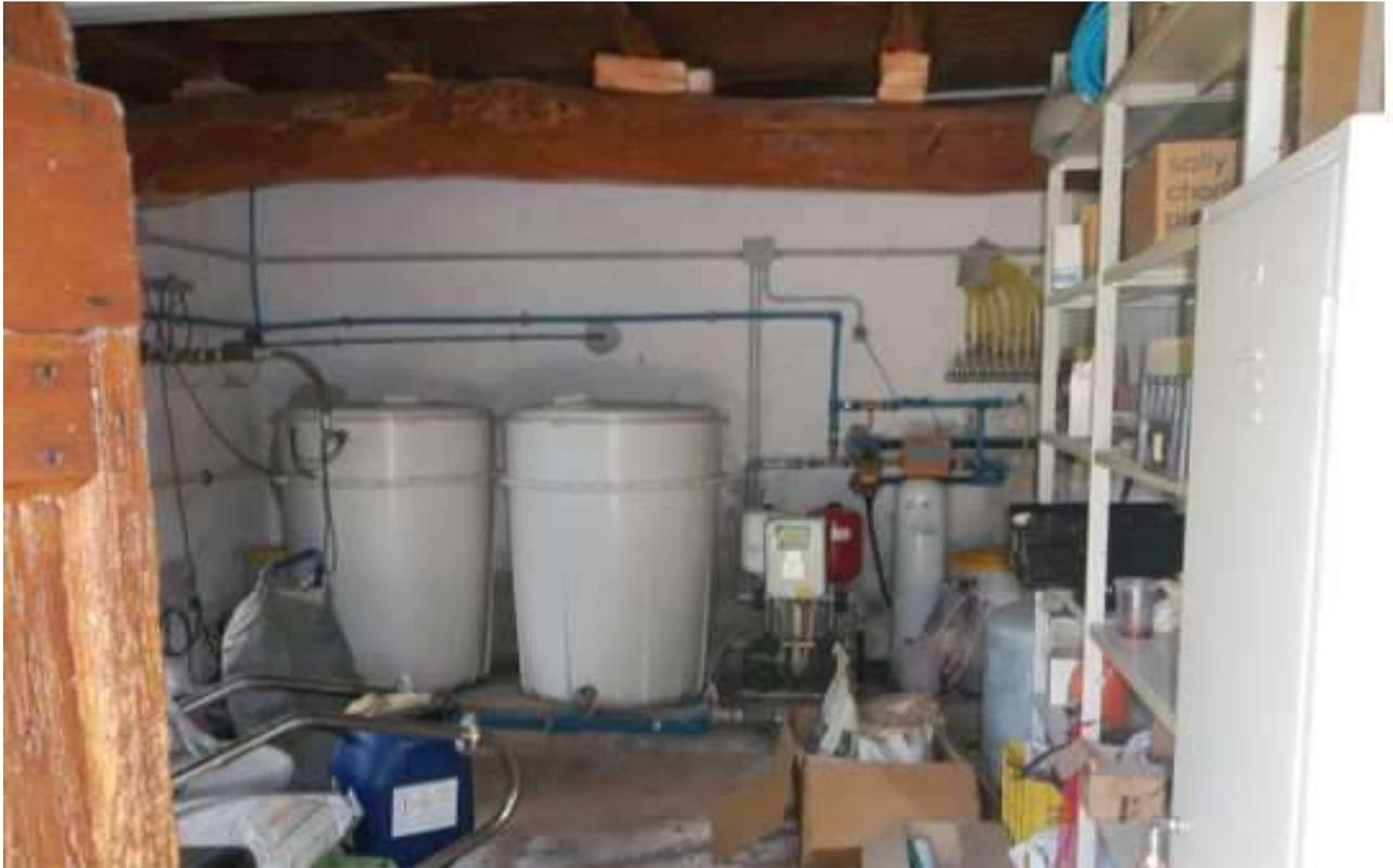
Foto 9 - Piano Terra – A2: potabilizzatore
