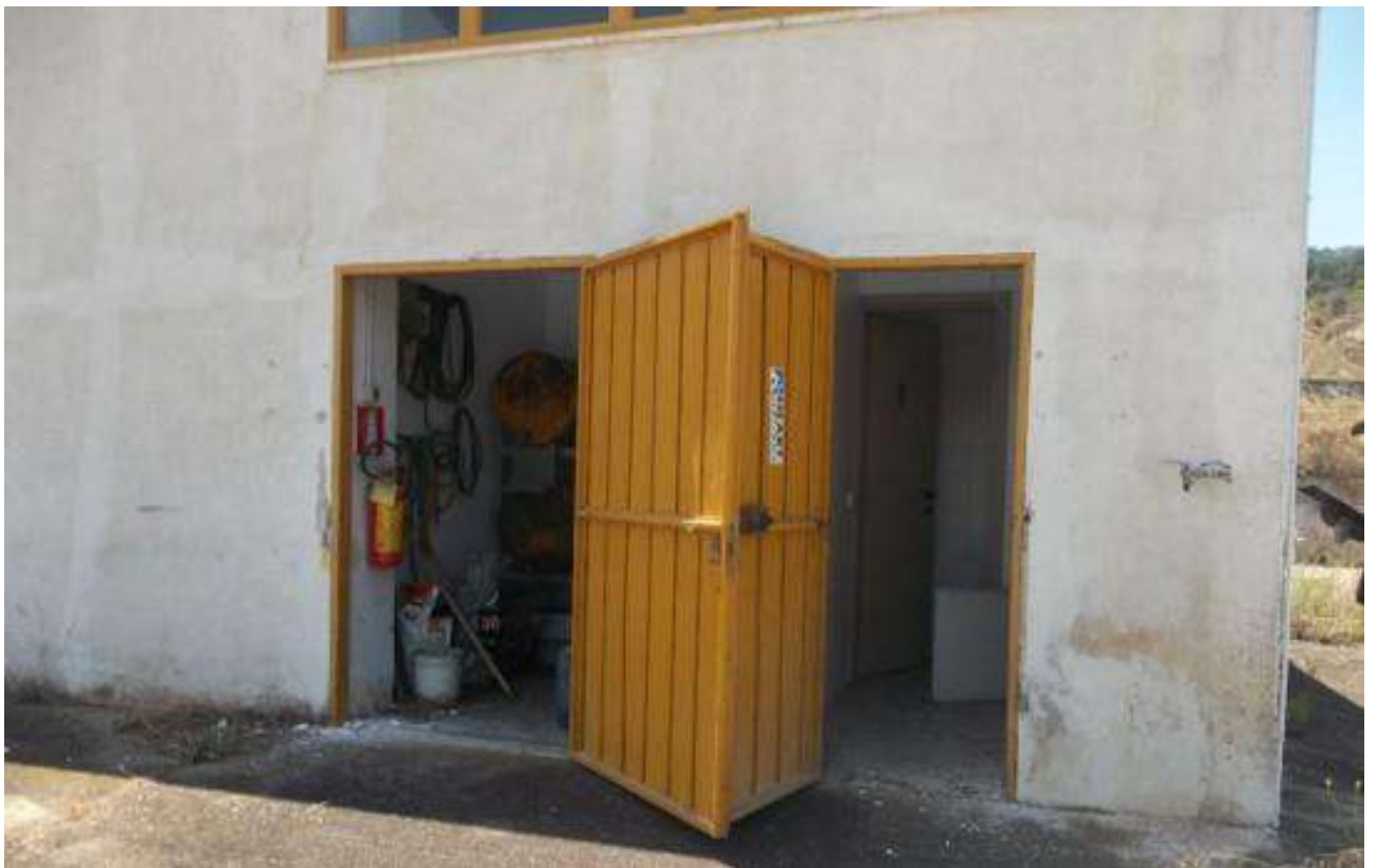
Foto 8 - Piano Terra – ripostiglio e w.c. – sub 3
