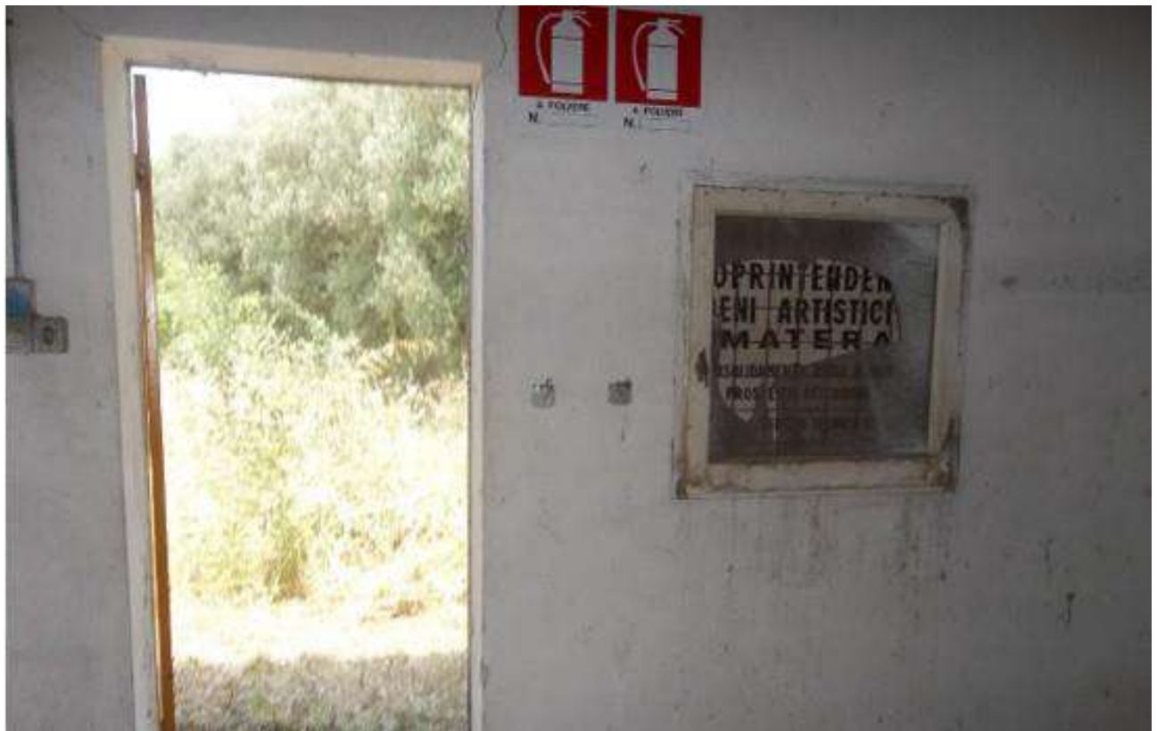
Foto 16 - Piano Terra – magazzino: interno – sub 6
