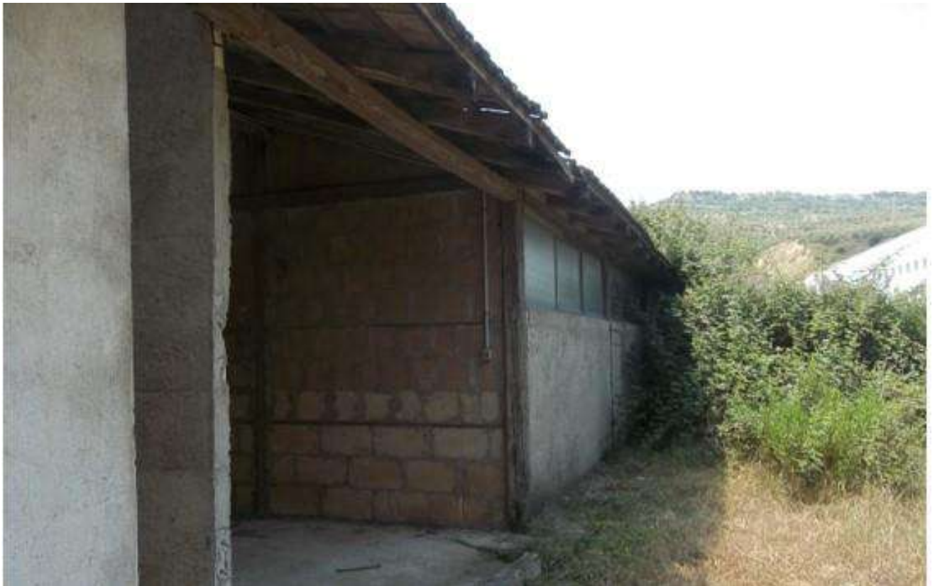
Foto 14 - Piano Terra – deposito aperto – sub 5
