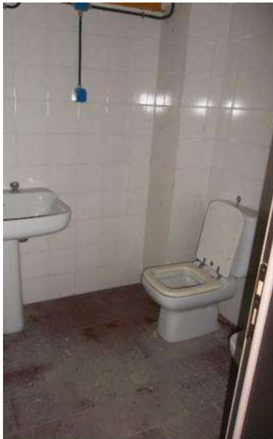
Foto 32- Piano Primo – zona bagno – sub 1
