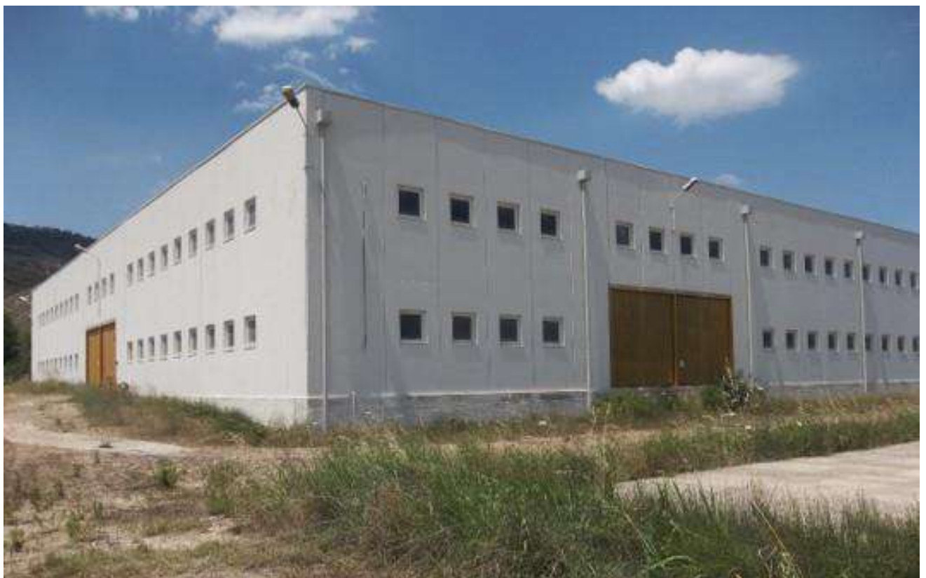
Foto 20 - Piano Terra – capannone: esterno – sub 1
