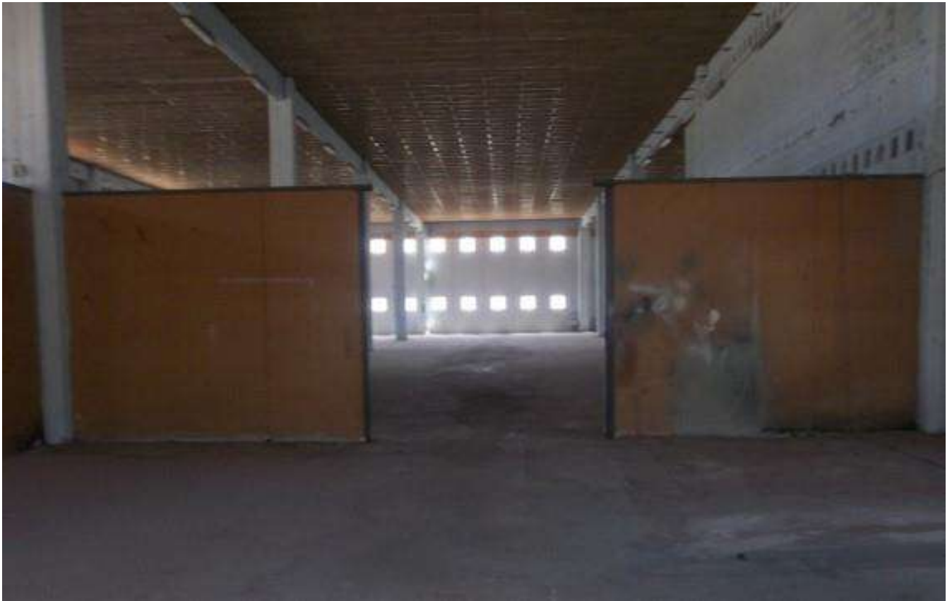
Foto 27 - Piano Terra – capannone: interno – sub 1
