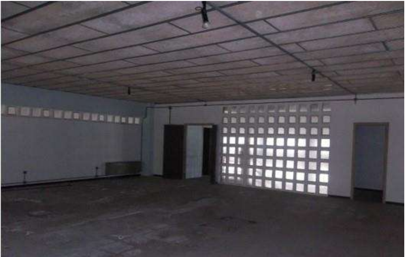
Foto 31 - Piano Primo – ufficio – sub 1
