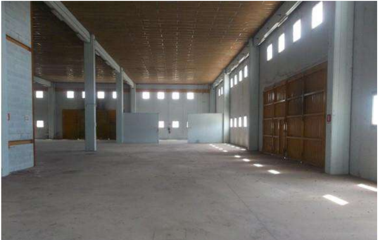
Foto 25 - Piano Terra – capannone: interno – sub 1
