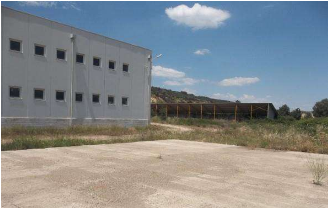
Foto 19 - Piano Terra – capannone: esterno – sub 1
