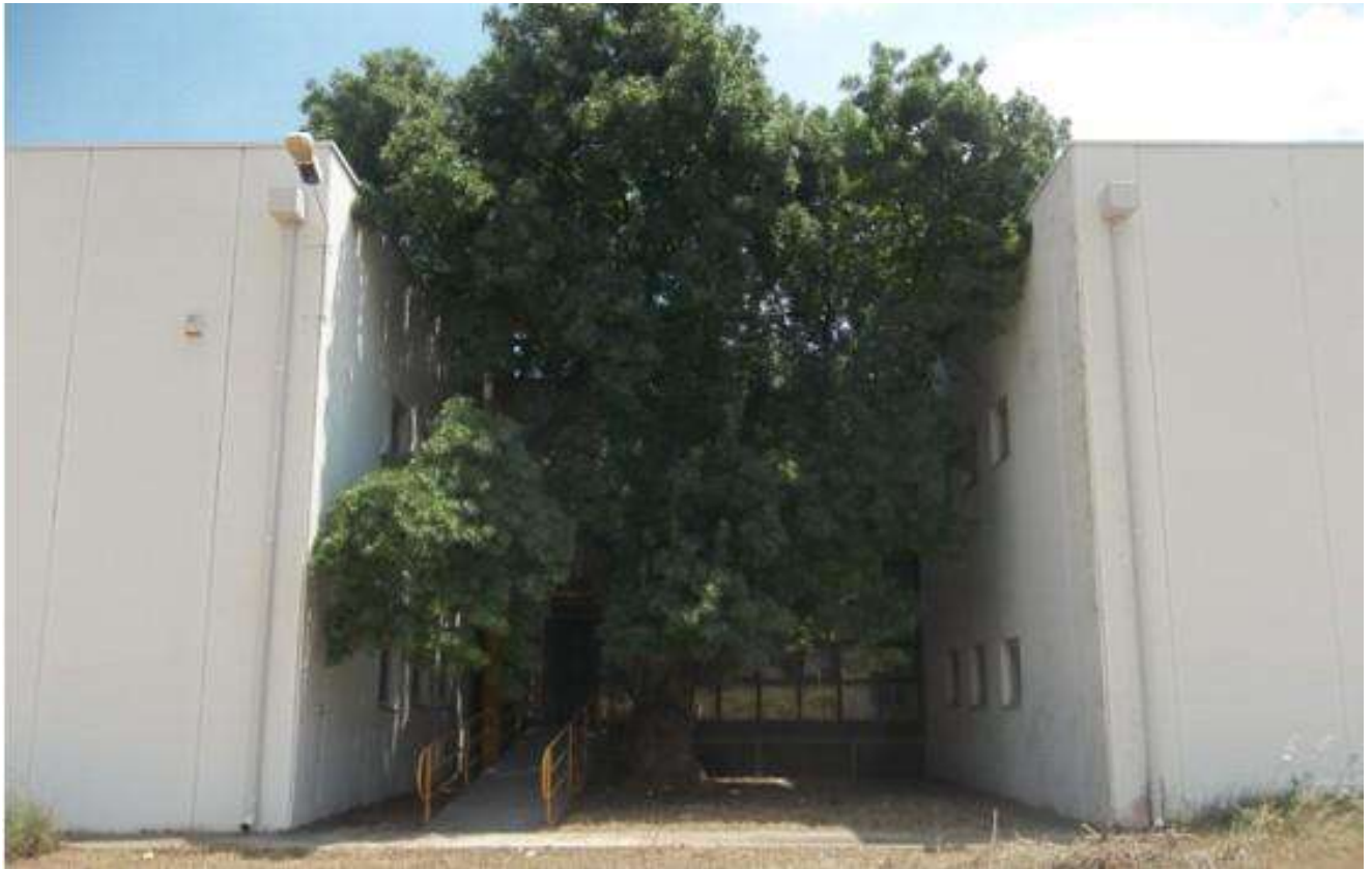
Foto 17 - Piano Terra – capannone: esterno – sub 1
