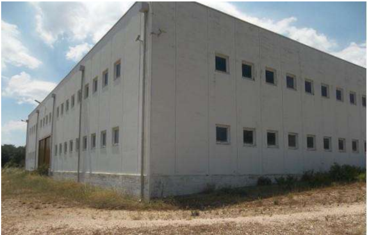
Foto 18 - Piano Terra – capannone: esterno – sub 1
