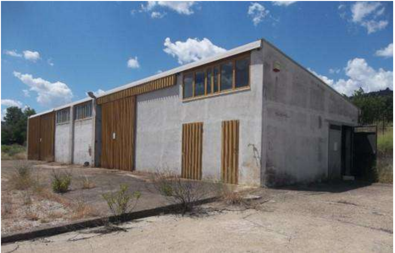
Foto 5 – Piano Terra – Esterno Officina – sub 3
