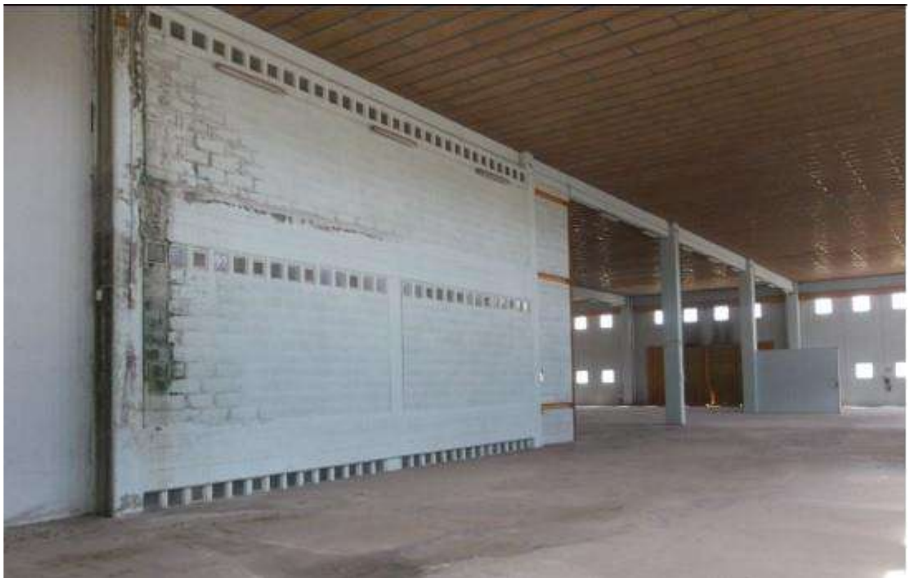
Foto 26 - Piano Terra – capannone: interno – sub 1
