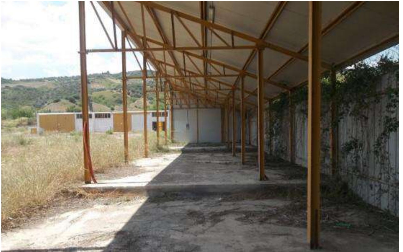
Foto 9 - Piano Terra – Tettoia – sub 4
