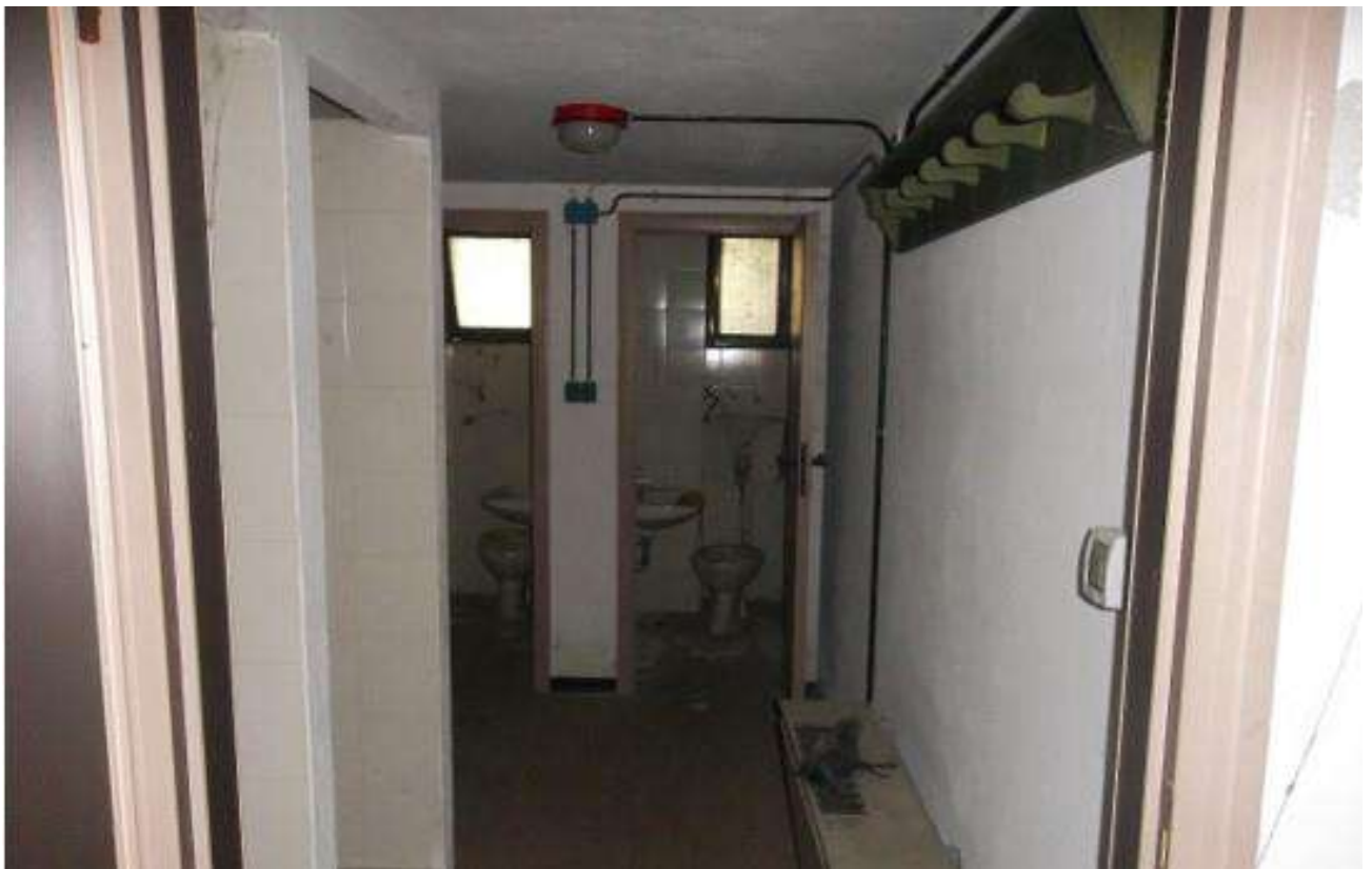
Foto 24 - Piano Seminterrato – zona bagni – sub 1
