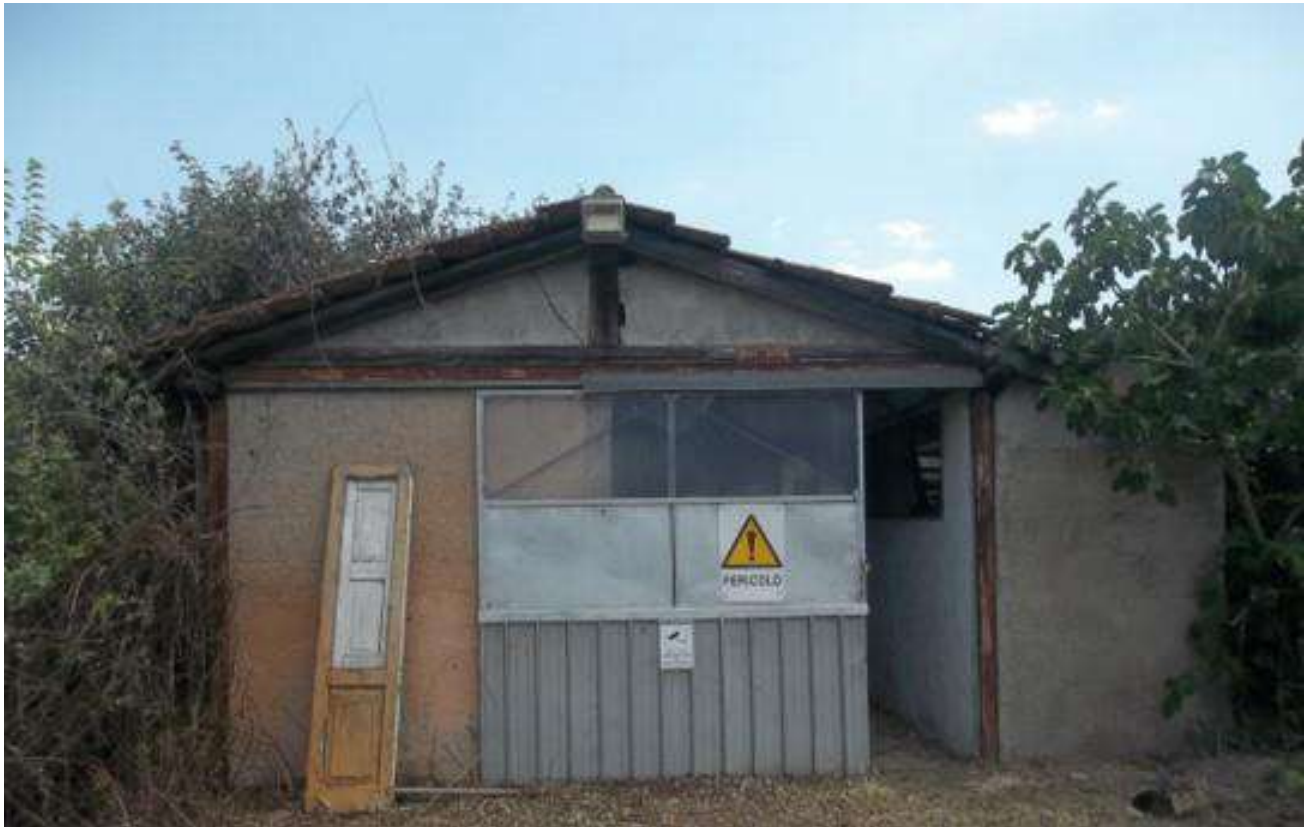
Foto 11 - Piano Terra – deposito attrezzi – sub 5
