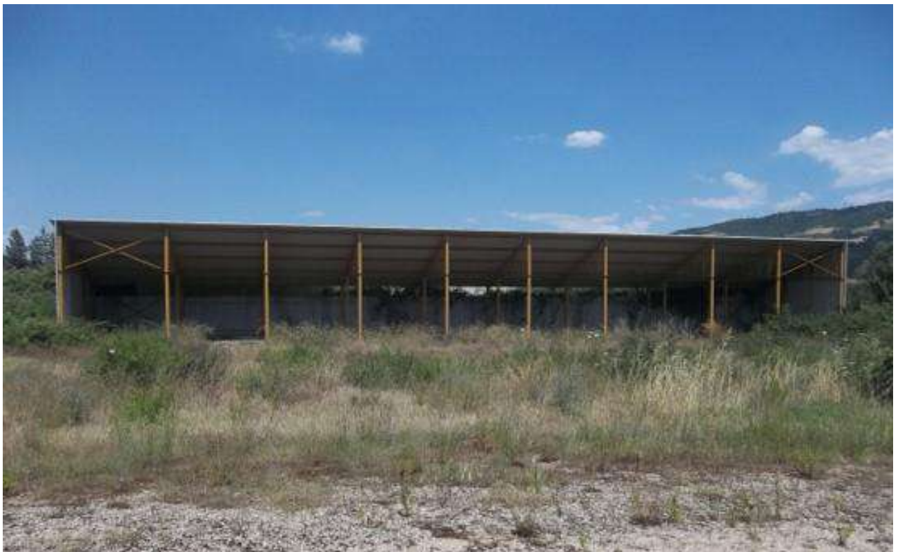
Foto 10 - Piano Terra – Tettoia – sub 4
