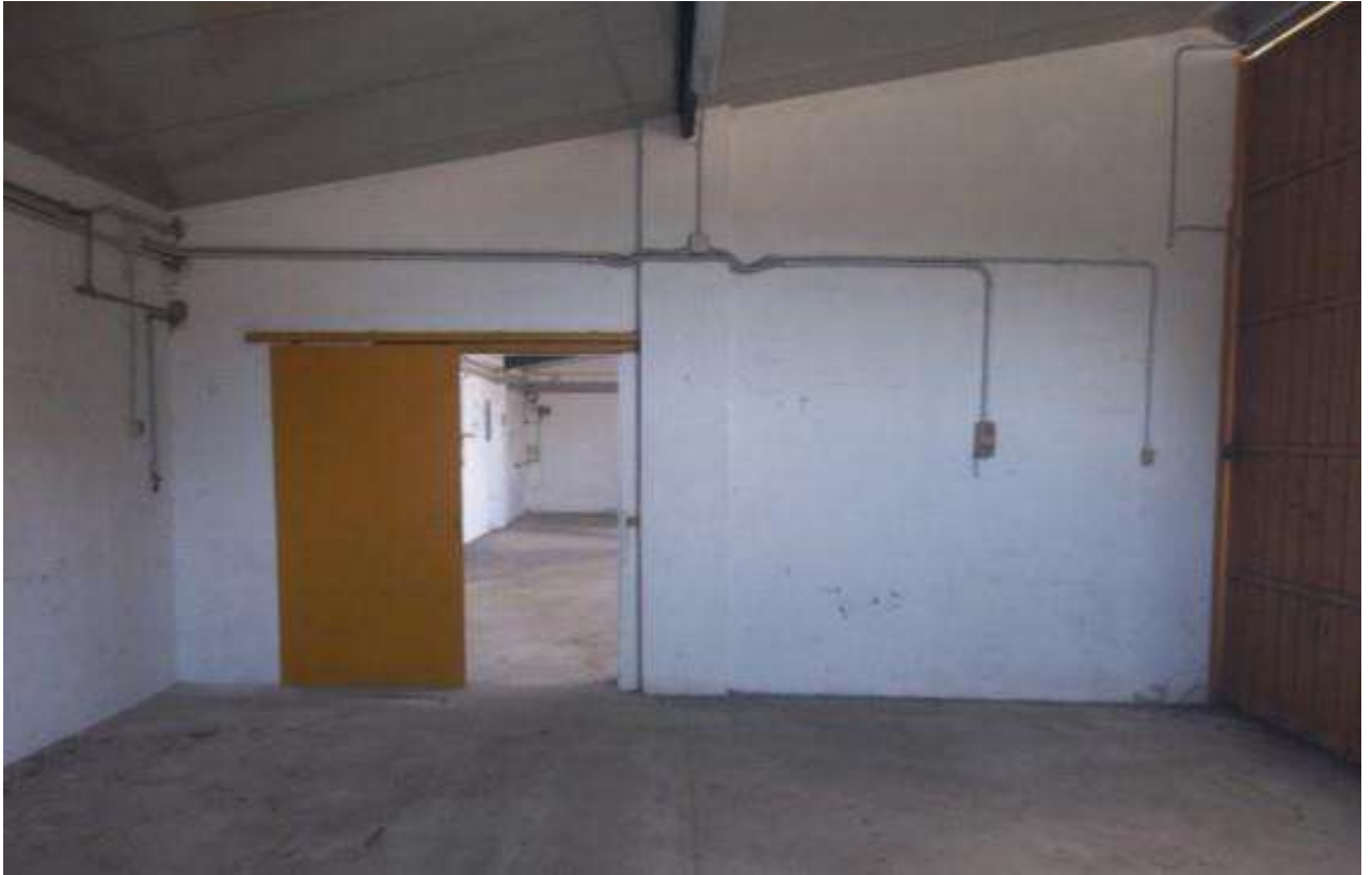
Foto 7 - Piano Terra – Officina – sub 3
