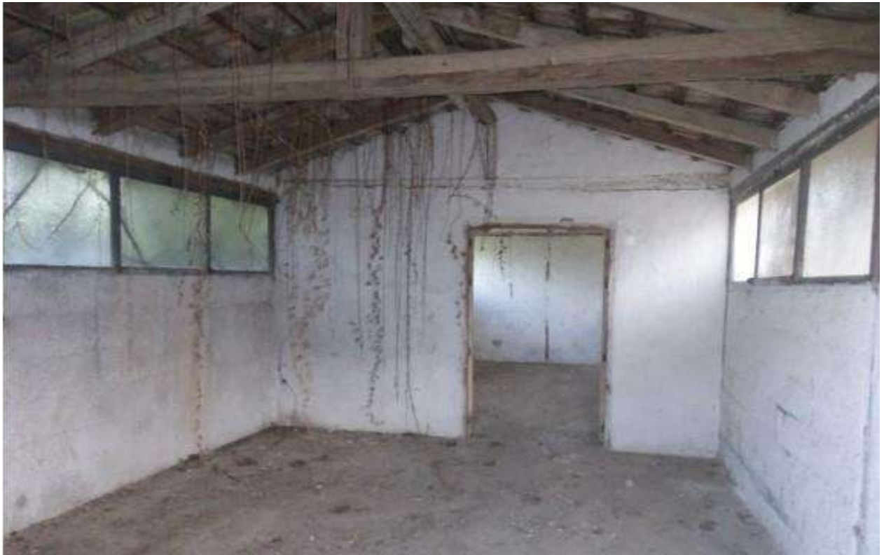
Foto 13 - Piano Terra – deposito attrezzi: interno – sub 5
