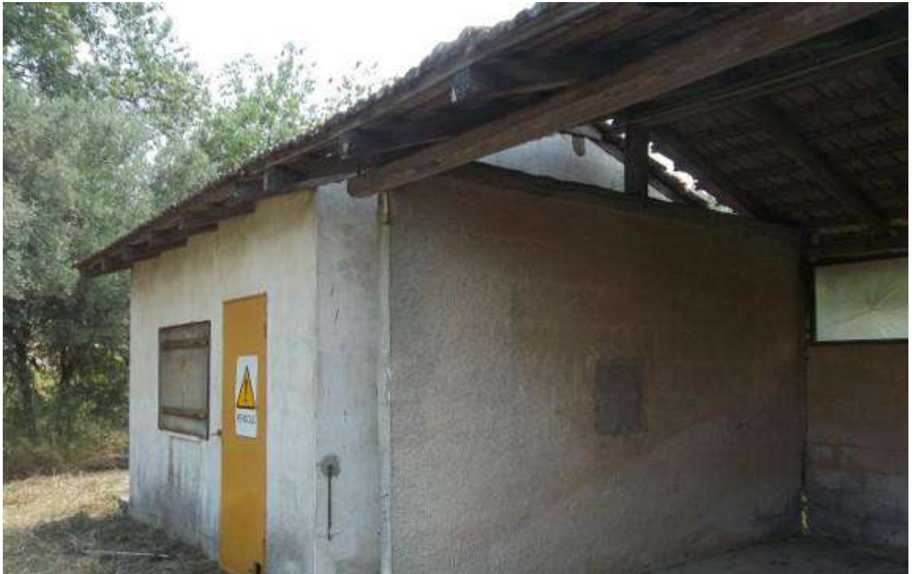
Foto 15 - Piano Terra – magazzino: esterno – sub 6
