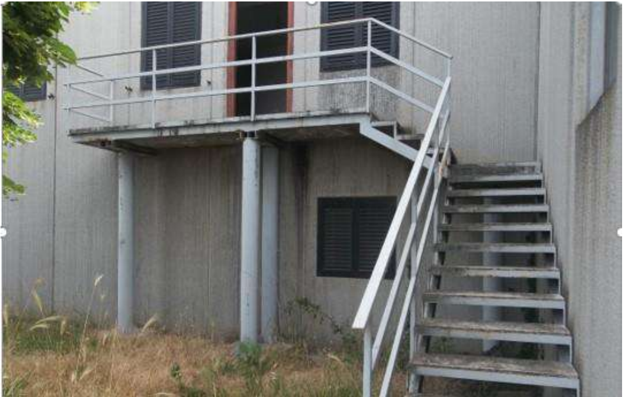
Foto 5 – Scala esterna di accesso al Piano Primo
