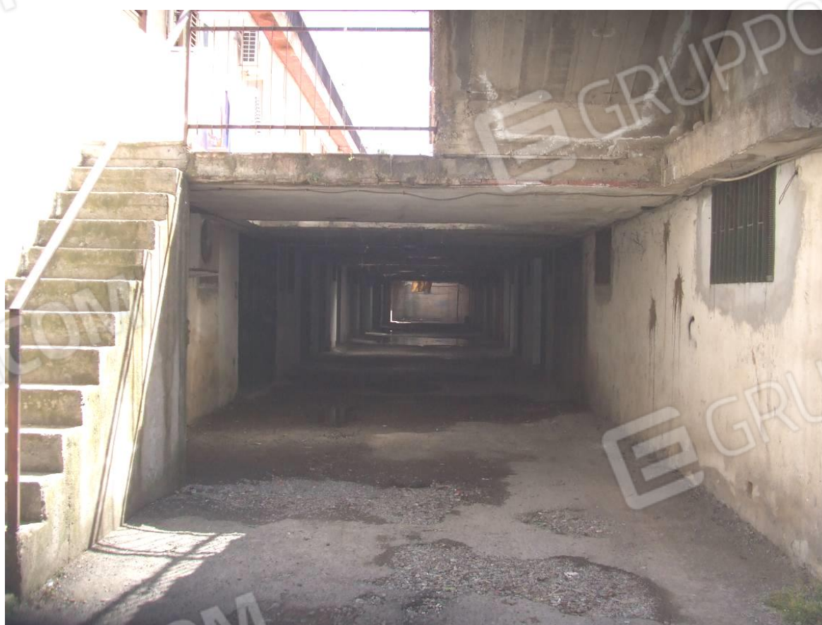
Vista esterna (tunnel d'ingresso)
