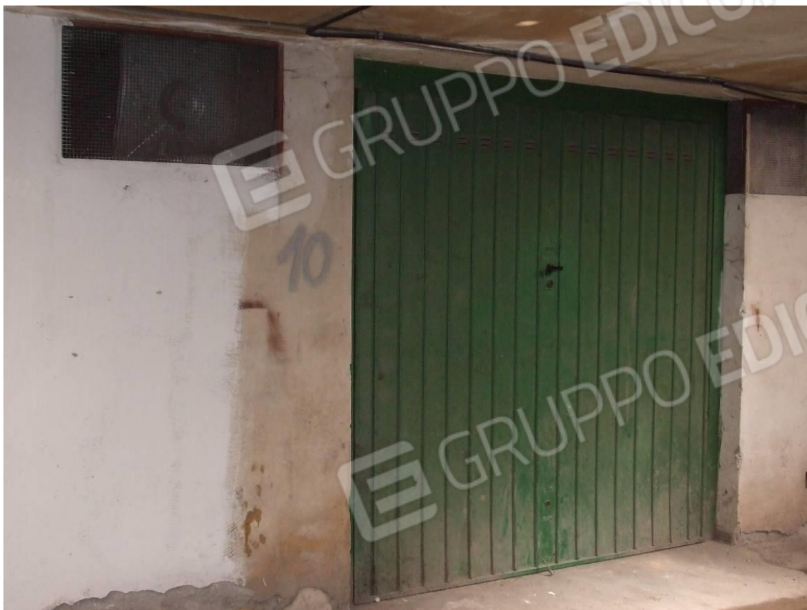
Foto n. 01: Vista esterna della basculante d'ingresso
