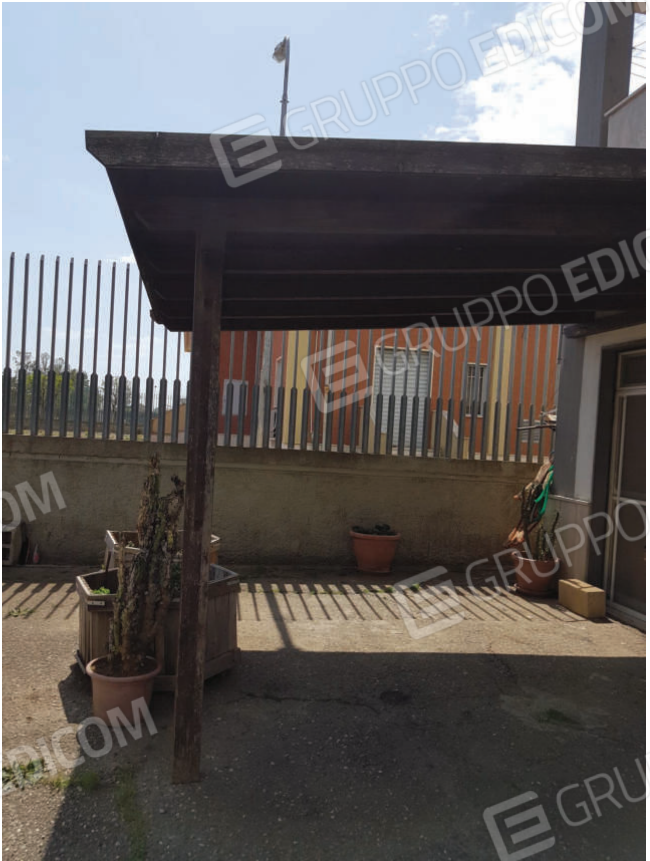
Fig 43 particella 503 sub 34 Autorimessa – tettoia
