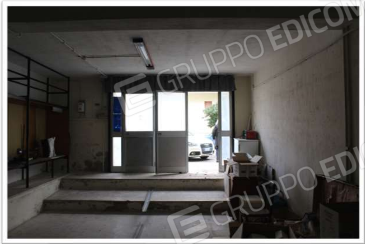
FOTO 3 – GRADINI IN PROSSIMITÀ DELL' ACCESSO AL DEPOSITO
