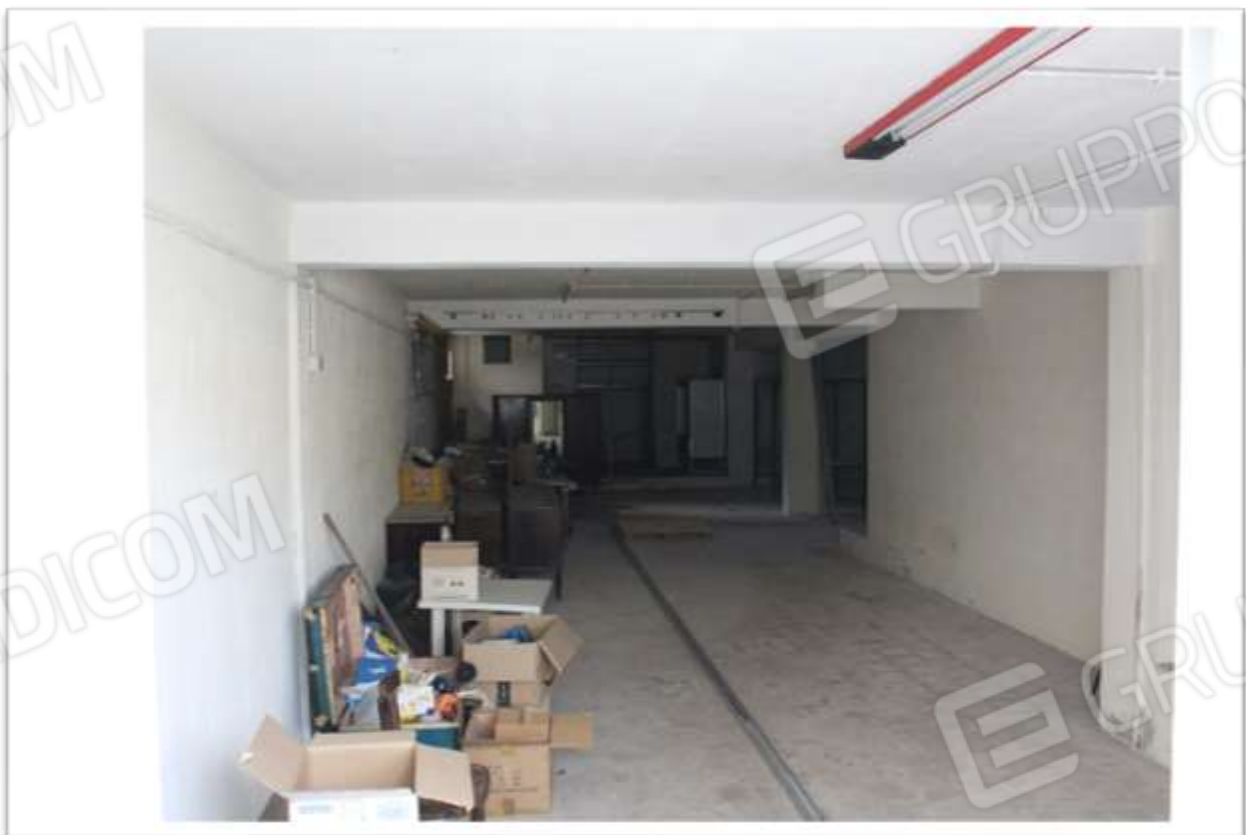
FOTO 4 – AMBIENTE UNICO DEL DEPOSITO
