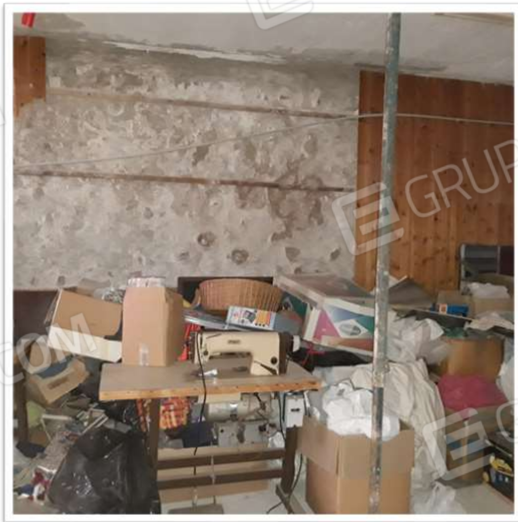
FOTO 14 – SEGNI DI UMIDITÀ DEGLI INTONACI
