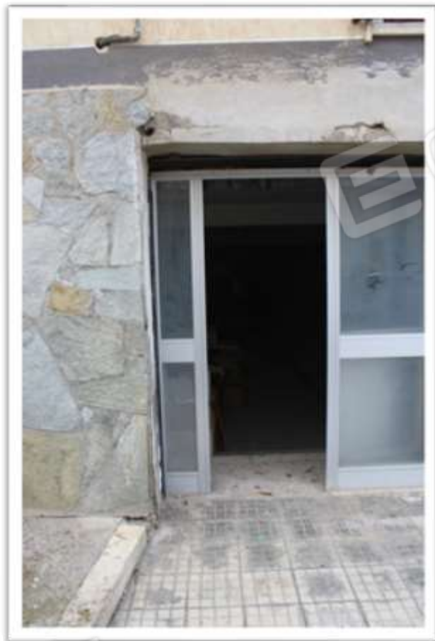
FOTO 2 – PORTA DI ACCESSO
