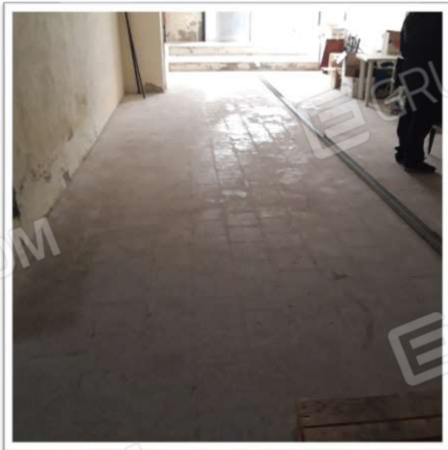
FOTO 12 – PAVIMENTAZIONE DEL DEPOSITO IN GRANIGLIA DI MARMO
